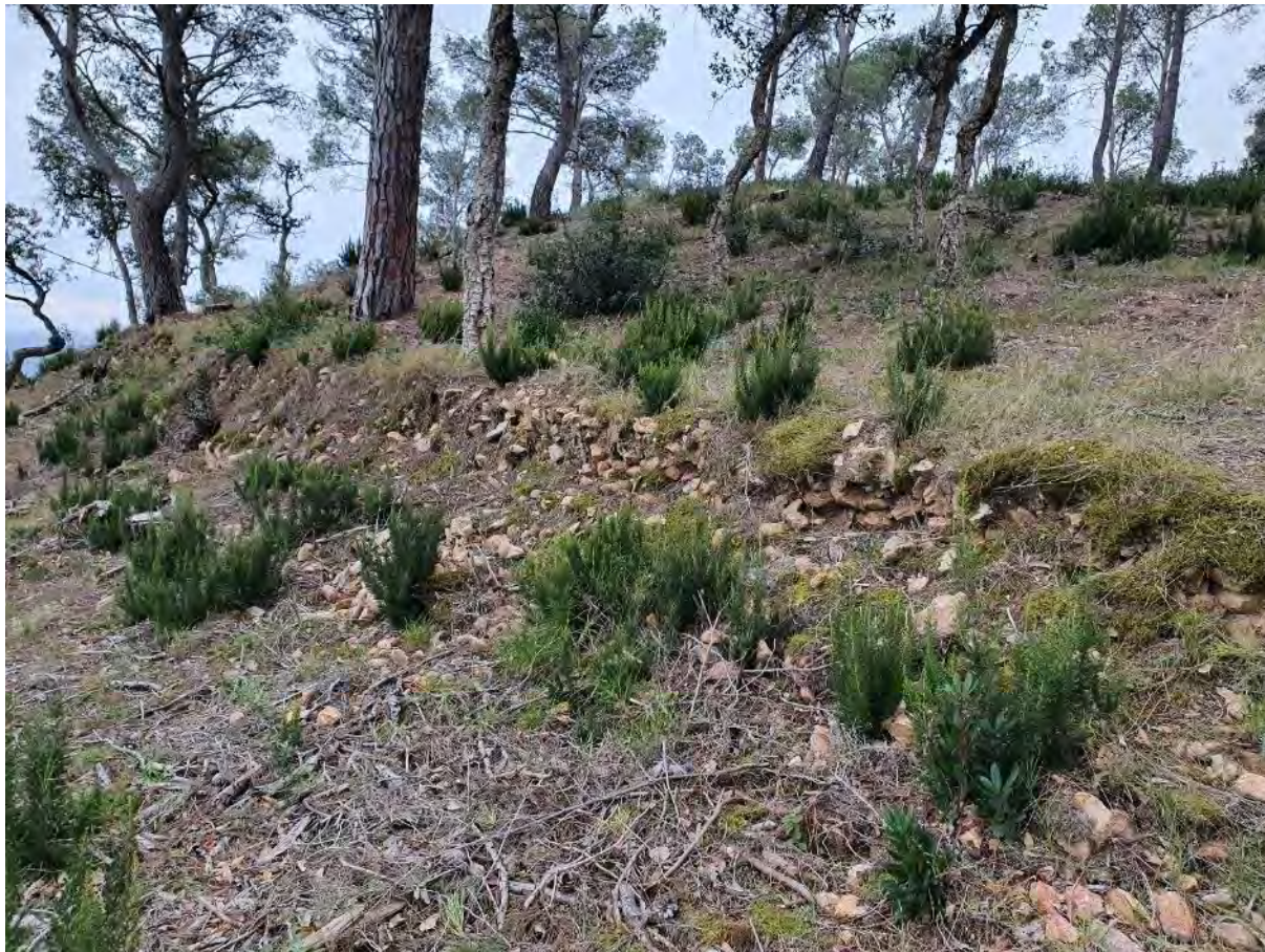
Figura 14: Restes d'un antic mur de pedra seca a prop de l'àmbit d'estudi (marge superior del carrer Capsacosta). Font: elaboració pròpia, 2022.
