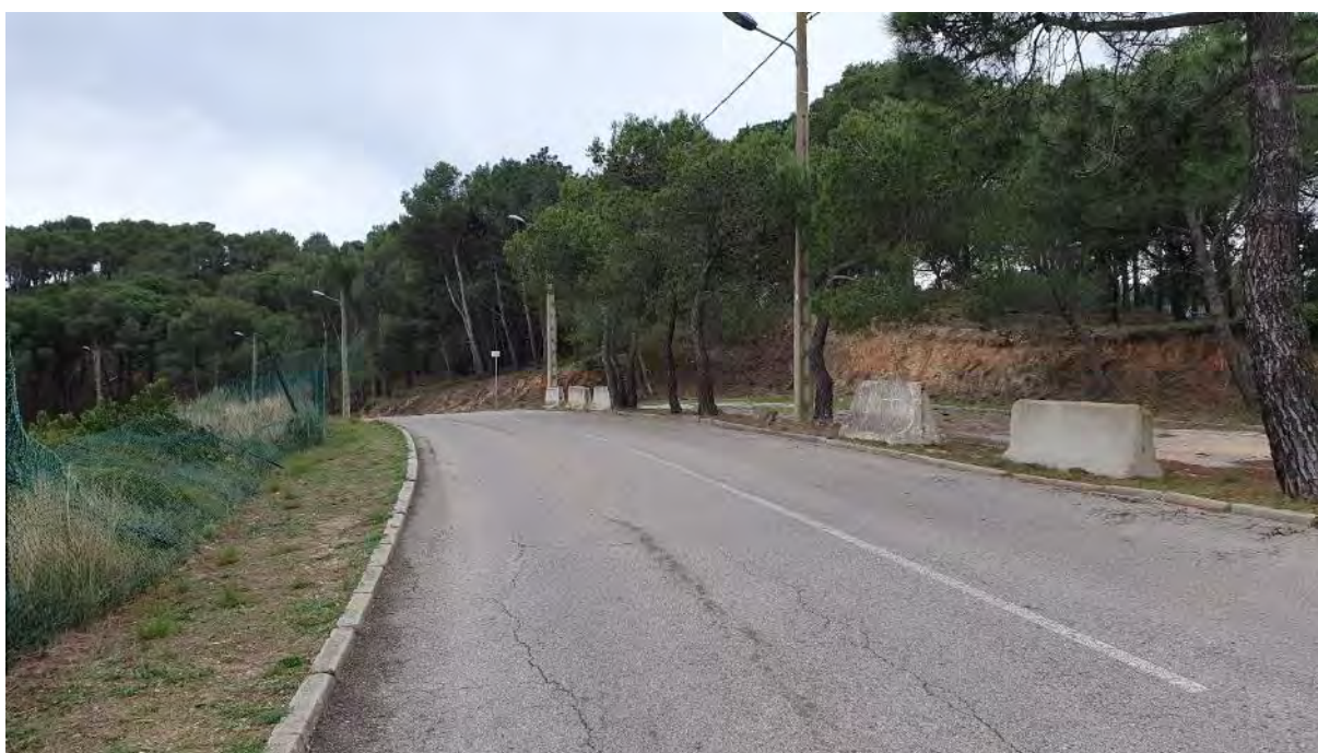
Figura 11: Entorn de l'àmbit d'estudi al carrer Capsacosta. Font: elaboració pròpia, 2022.
