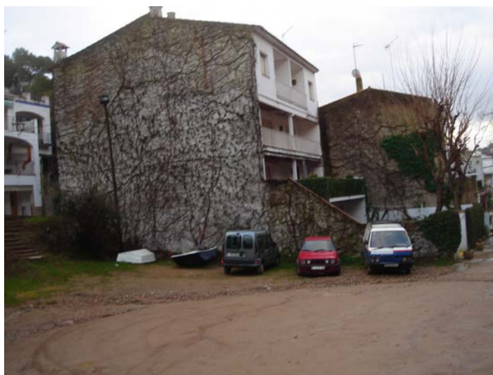
Vista des de l'extrem Nord. Notis l'heura a la paret mitgera. Aquest planejament preveu que sigui possible la seva replantació a la façana nord del nou edifici que serà resolt com a façana i no com a paret mitgera.
