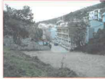
VISTA DES DEL CARRER D' AIGUA BLAVA PER SOBRE DE LA FINCA MIRANT CAP EL MAR
