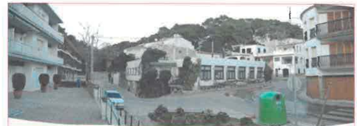
AQUESTA CRUÏLLA DE CARRERS I RIERA MÀI HA ESTAT RESOLTA. ACTUALMENT L' AIGUA DE PLUJA VA MÉS PEL CARRER QUE PER LA RIERA
