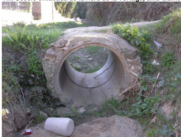
Figura VIII. Secció entubada de la riera de la Tortuga, amb diàmetre interior de 80 cm.
