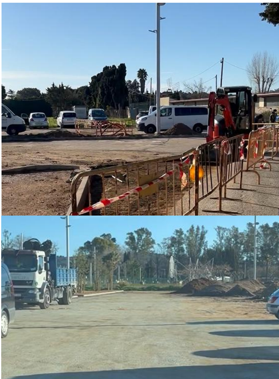
Obres al futur aparcament previst entre passatge Fenaia i carretera GIP-6543.
