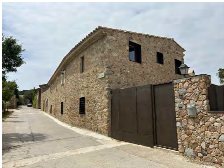
4. Paratge d'Ermedàs nº5A1 i nº5A2
