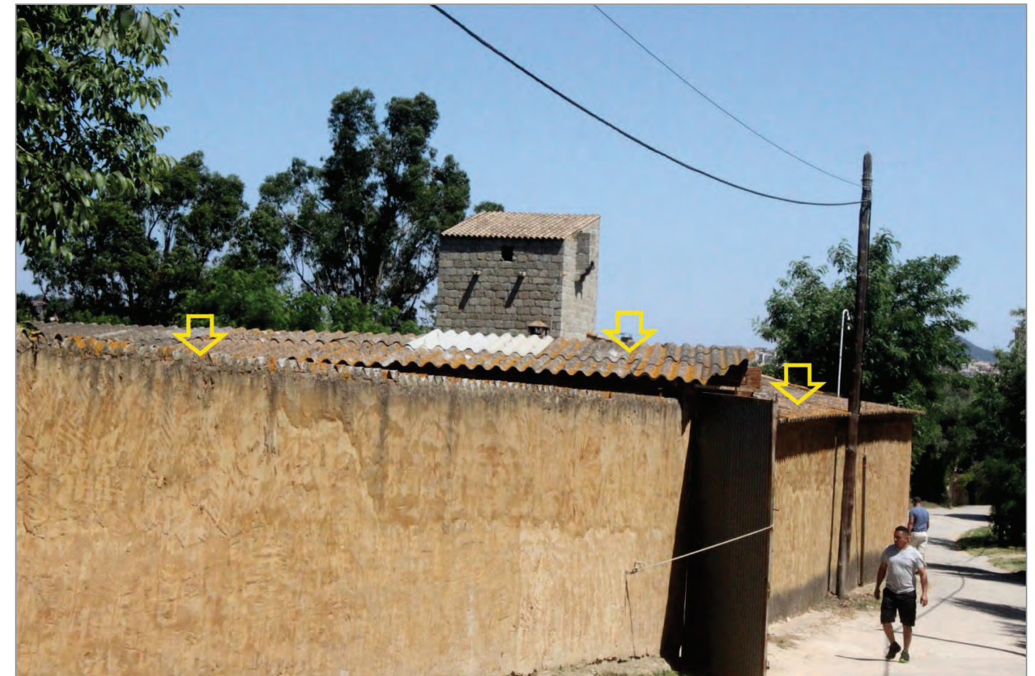
Figura 10 Les noves edificacions solament afecten estructures prèvies amb sostres de fibrociment. A la foto es mostra la que, a la figura anterior, figura amb el nº 2.
