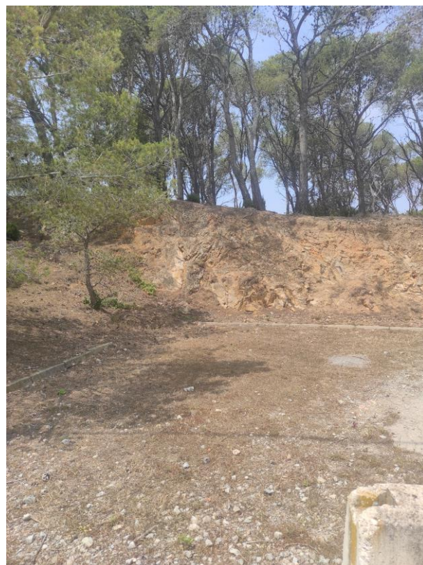
Foto n. 6: Detall talussos aparcament carrer Capsacosta
