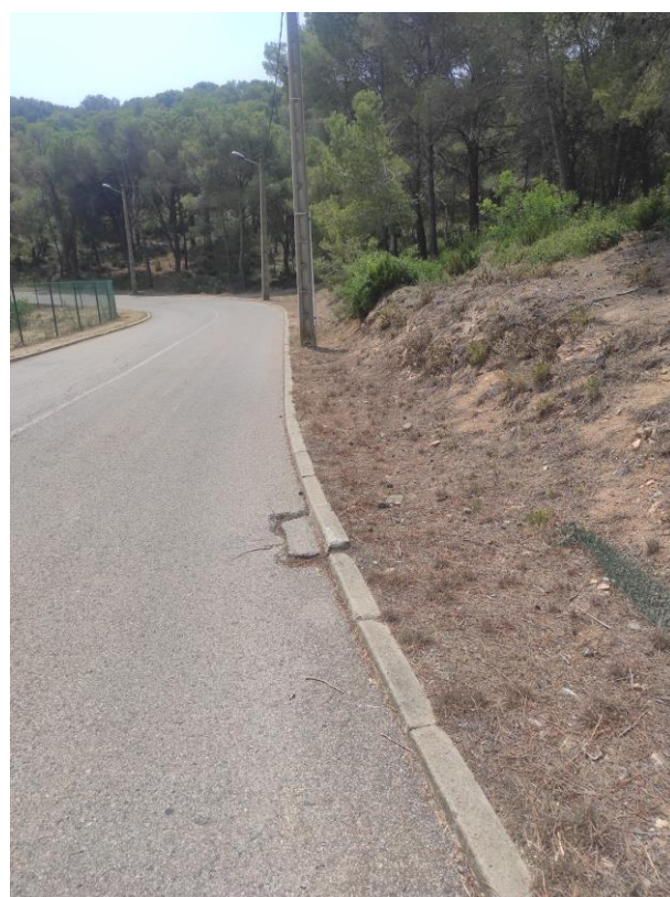
Foto n. 2: Situació existent Carrer Capsacosta sud, àmbit d'actuació nova vorera
