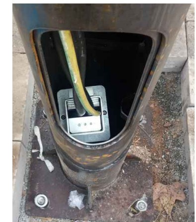
DISPOSITIU ANTIROBATORI TIPUS "APRUDEVAN" PER COLUMNES D'ENLLUMENAT
