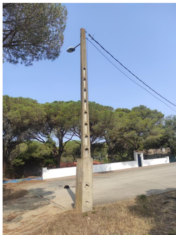
Foto n. 9: Detall conjunt pal de baixa tensió i punt de llum a l'àmbit
