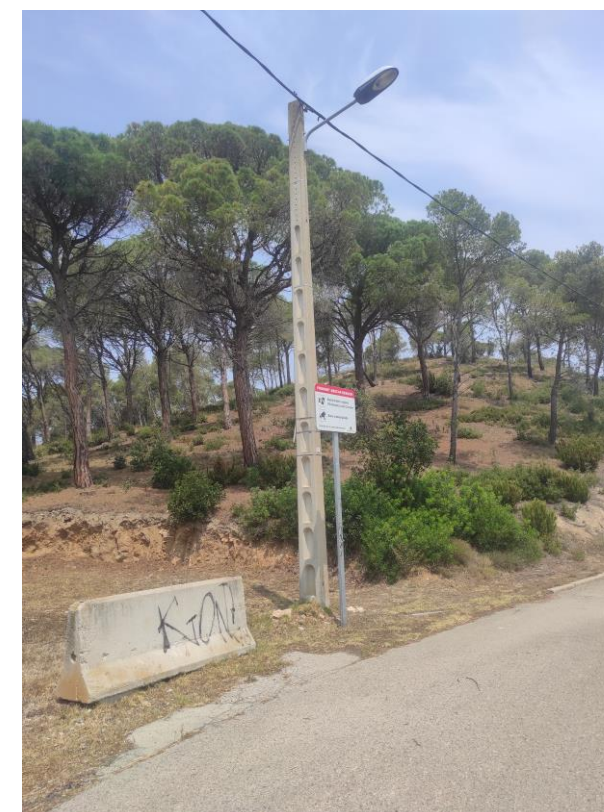
Foto n. 4: Situació existent Carrer Capsacosta, accés a nou aparcament
