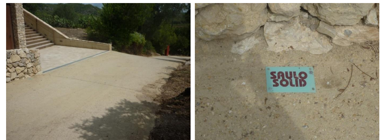
Imatge 2. Exemple de col·locació de sauló sòlid al camí d'accés a l'ermita de Santa Pau de Sant Pere de Ribes.
