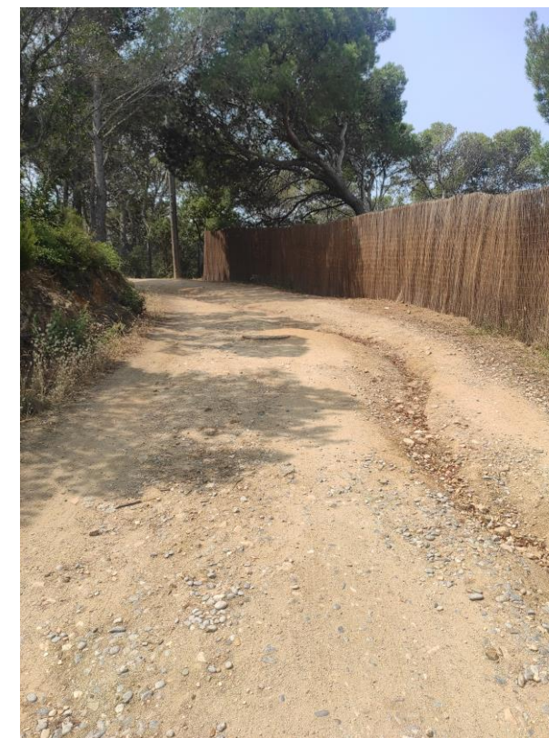
Foto n.20: Camí existent Illa Negra
