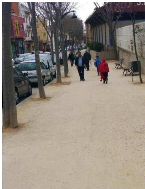
Imatge 3. Exemple de col·locació de sauló sòlid a Sant Feliu de Guixols (vorera IES Carrilet).
