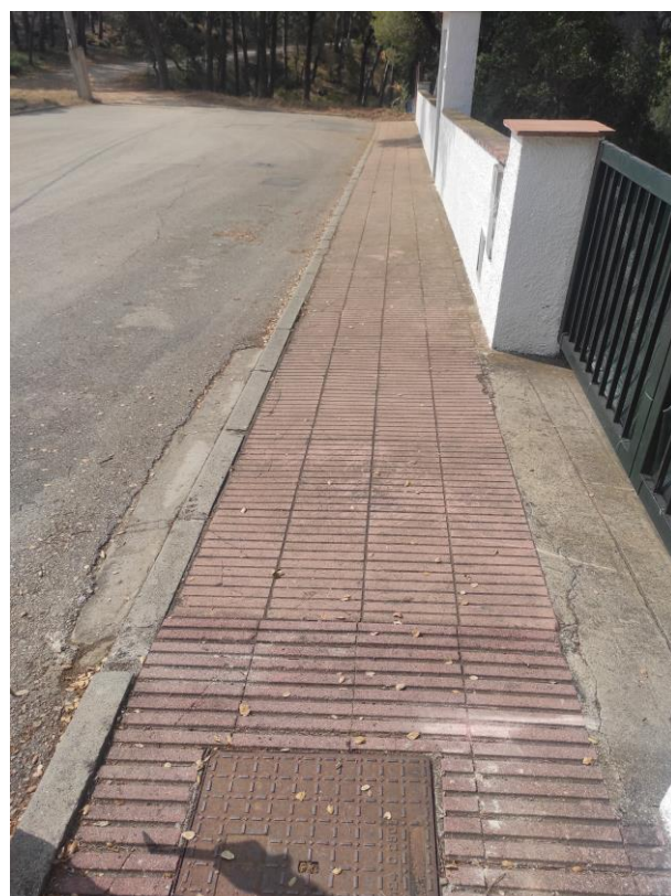
Foto n. 10: Vorera existent al Carrer Puigventós Nord
