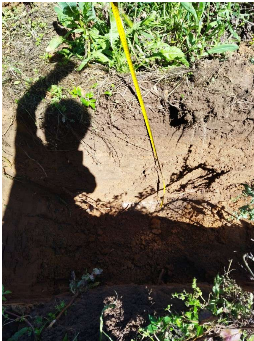
Canonada soterrada a 1,2 metres de profunditat en Cala (C4).
