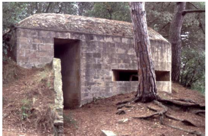
Niu de metralladores B
