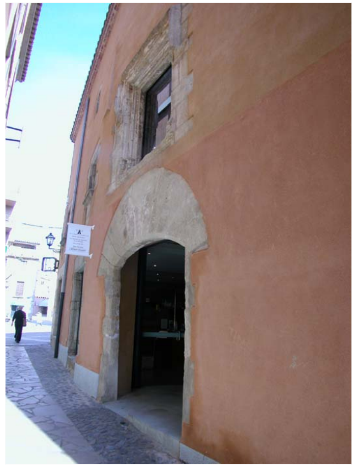
FAÇANA CARRER MAJOR N° 3
