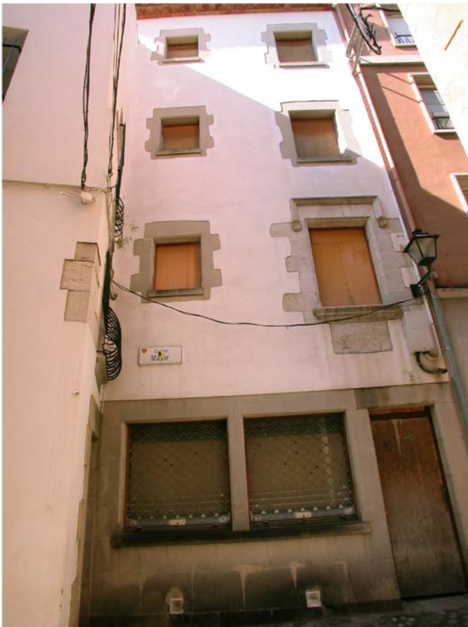
CARRER MAJOR Nº 6
