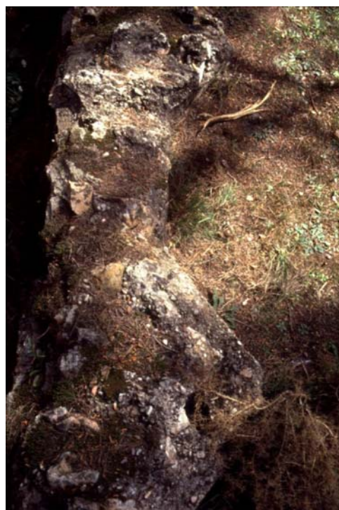
Base de formigó del tancament de la trinxera
