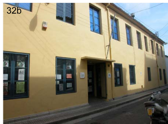
CARRER PROGRÉS Nos 7-13
