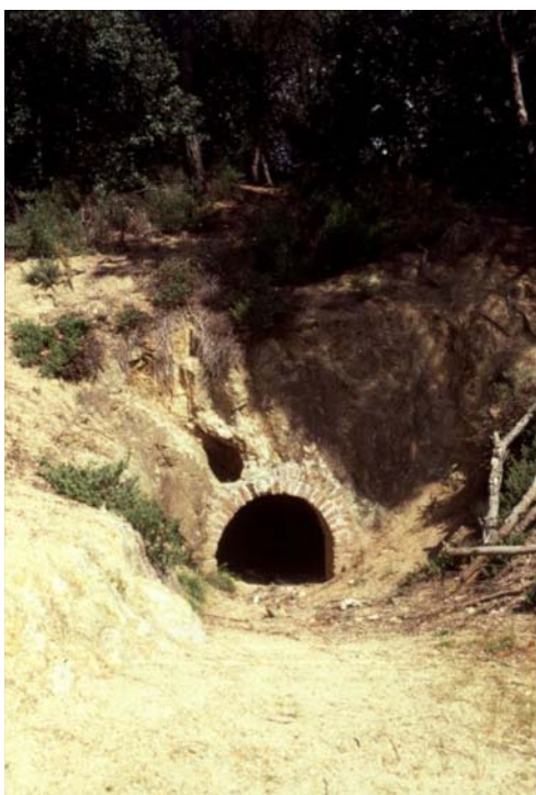
Entrada al túnel
