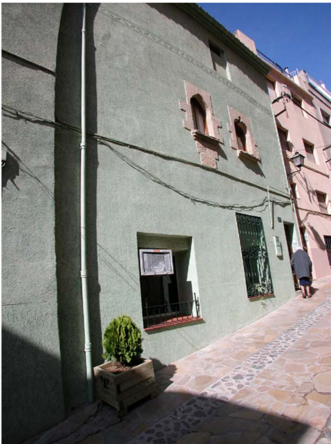
CARRER MAJOR Nº 18
