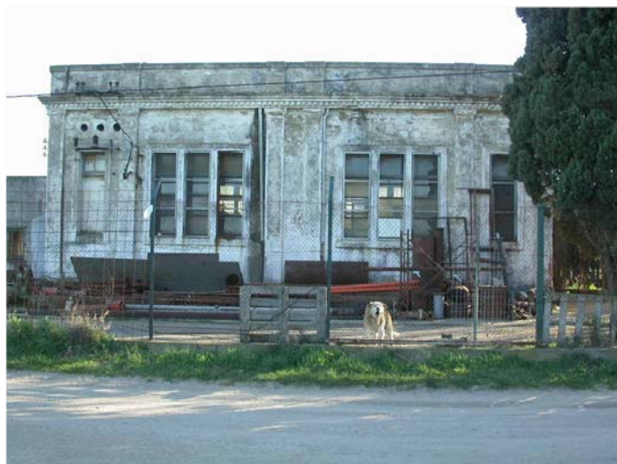
ESTACIÓ ELEVADORA D'AIGUA
