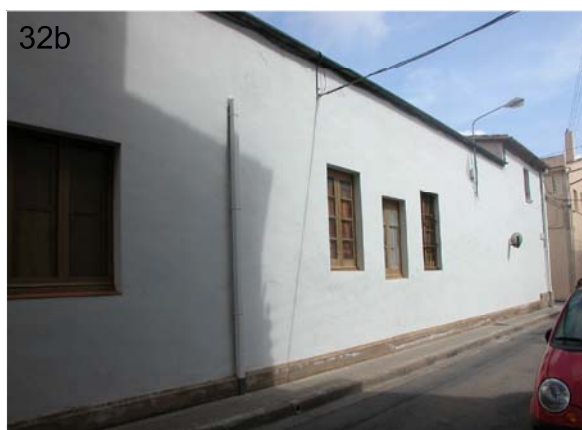
CARRER PROGRÉS Nos 15-17
