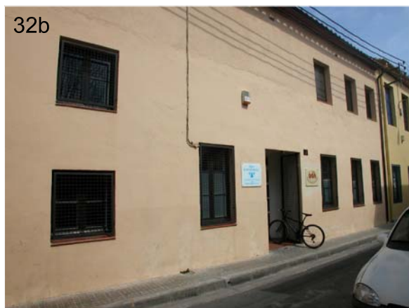
CARRER PROGRÉS Nos 3-5
