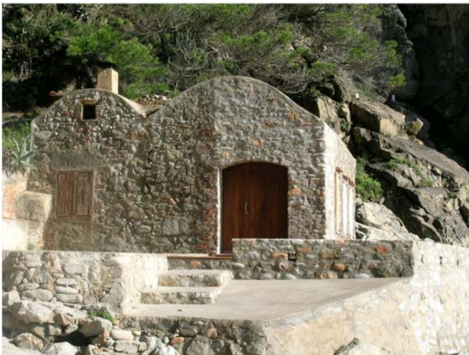
BARRACA DE CALA DEL CAU
