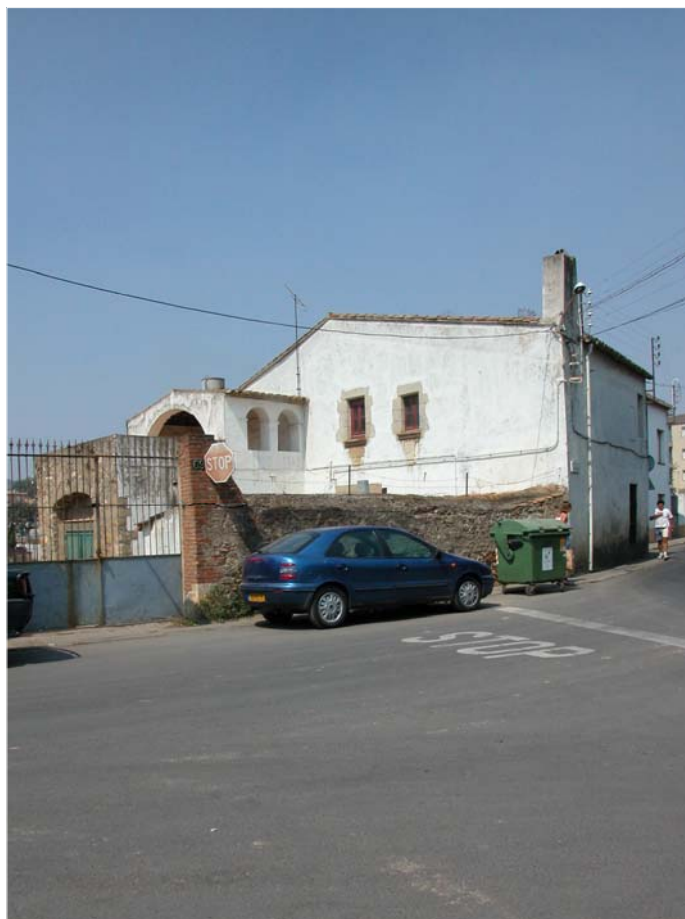
CAN CORREDOR: CARRER VILAR N° 69
