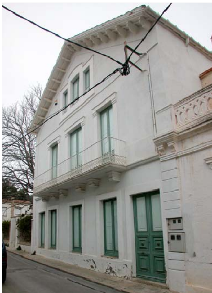
FAÇANA AL CARRER MONTURIOL
