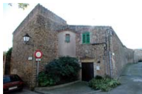
Nº 1-3 Nivell 2 Carrer del Ter
