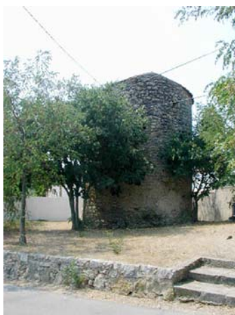
torre de Vila-seca, ronda de Vila-seca, 1 Fitxa nº 88 Nivell 1
