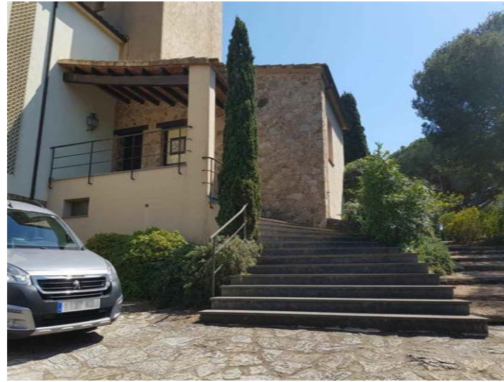
Façana nord - àntic accés
