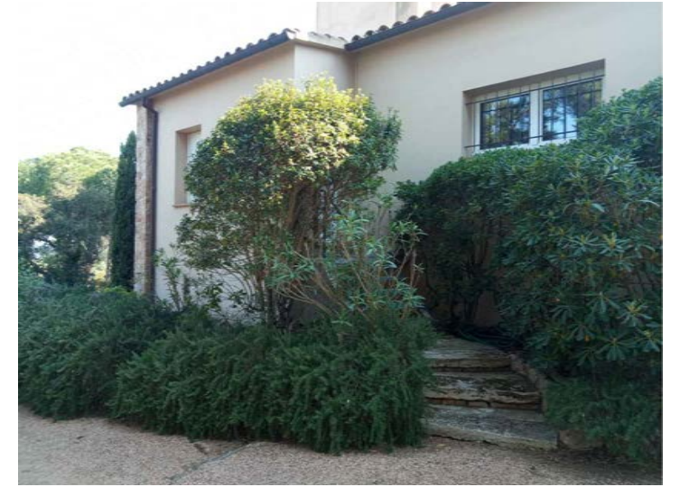
Façana oest - àntic accés del servei
