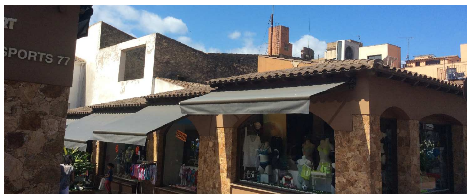
v4. Vista de l'equipament desde interior illa
