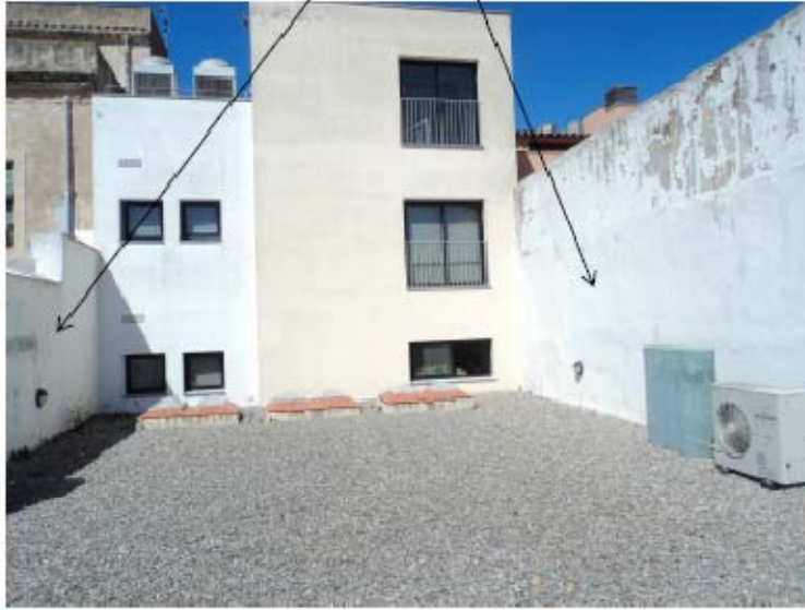
Vista de la cubierta plana sobre Planta Baja Zona de la ampliación propuesta
