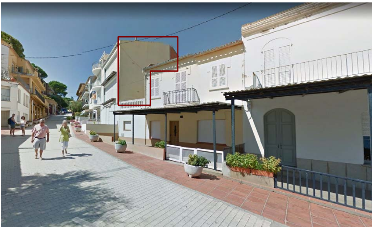
Fotografía de fachada marcando en rojo la pared medianera adosada.
