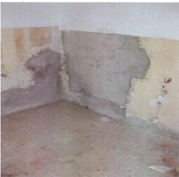
Paviment interior i detall d'instal.lació elèctrica estat actual.
