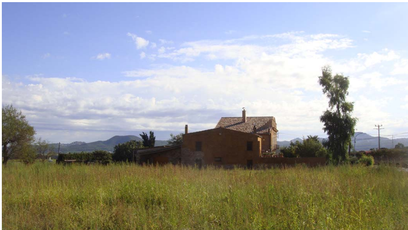
Fotografia general de conjunt façana ponent
