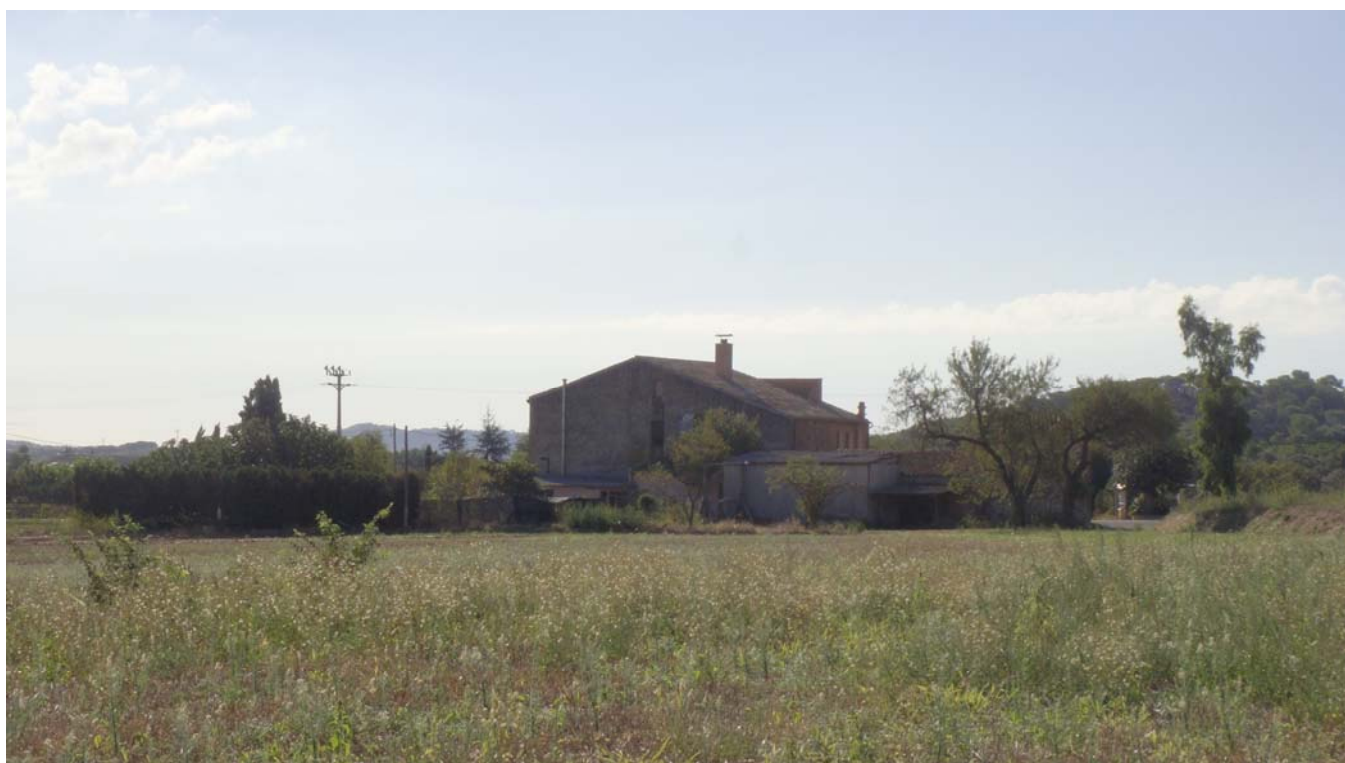
Fotografia general de conjunt façana Nord
