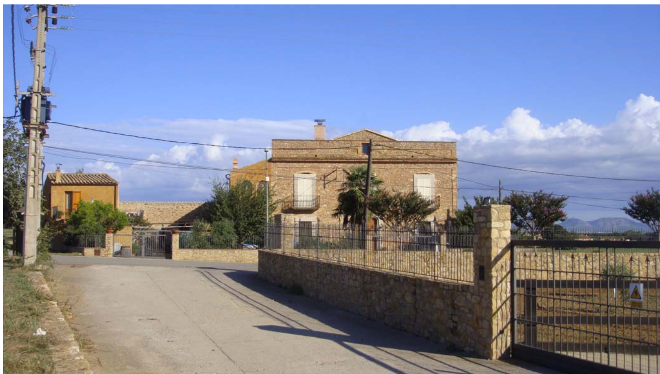
Fotografia general de conjunt façana Sud
