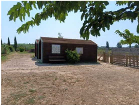
Accés i mòdul prefabricat
