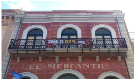
Vista de la barana del balcó
