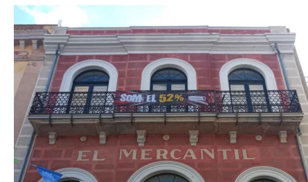
Vista de la barana del balcó
