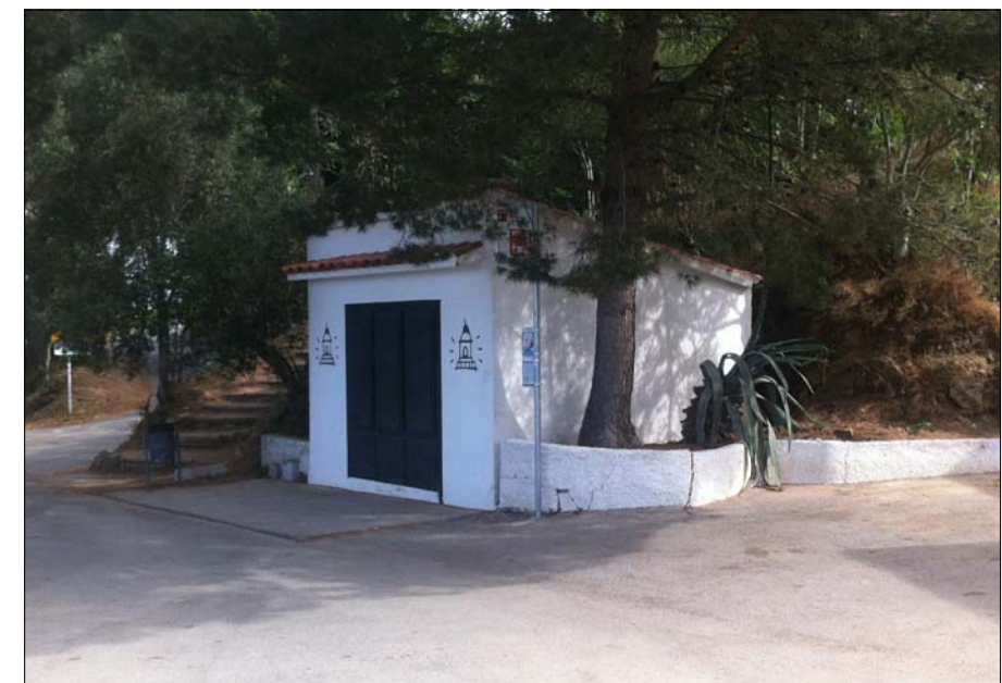
VISTA CASETA RECEPCIÓ
