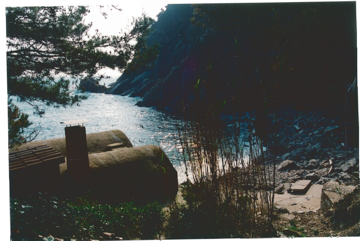
Foto 14. Cala El Cau. L'accés a aquesta cala es realitza per mitjà d'un sender estret i tortuós, de forta pendent. Es preveu l'eixamplament del camí i la construcció de nous graons de pedra.
