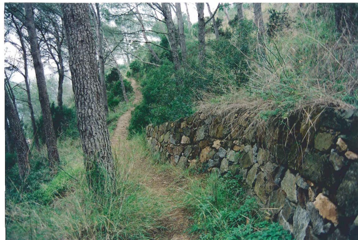
Foto 24. Mur de pedra seca que delimita el camí (aquí sender GR) a l'alçada del PK 1+950. Sobre aquests murs es preveu una conservació i reposició, en cas necessari.
