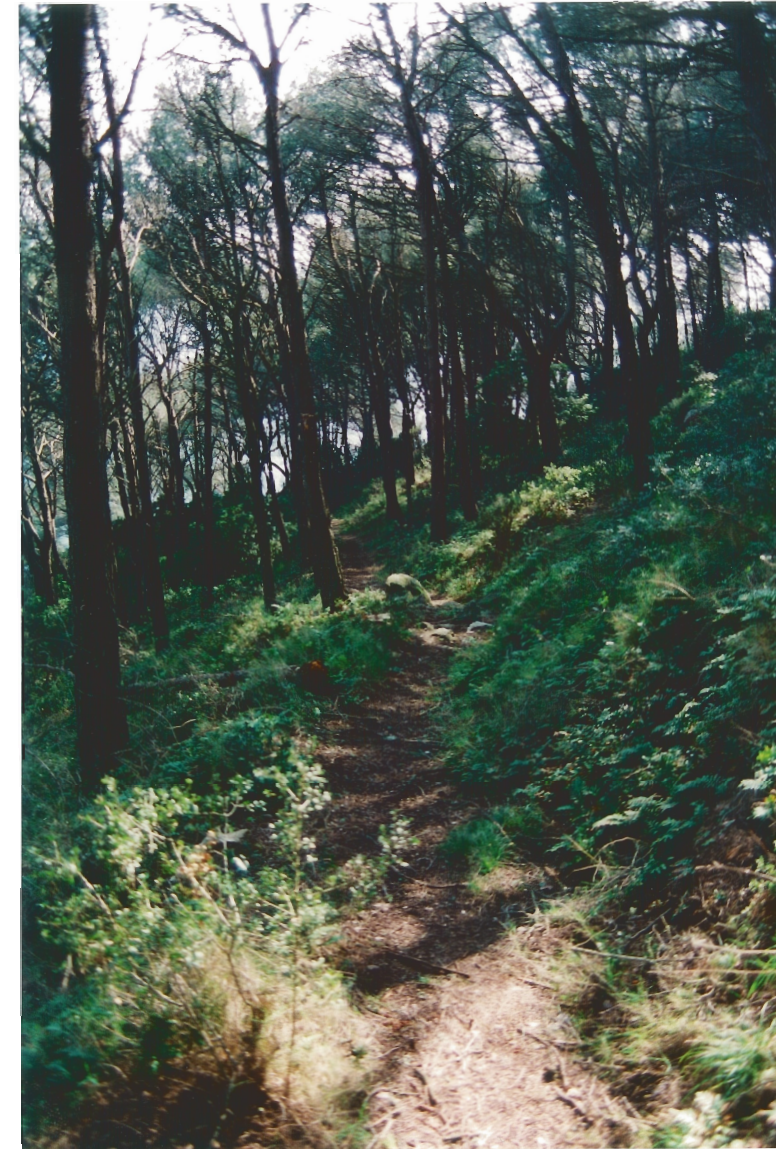
Foto 22. Aspecte de l'actual sender entre els PK 1+790 i 1+850, aproximadament. En aquest tram es preveu un eixamplament fins a 1,5 m i l'adequació de graons de fusta en les zones de més pendent.
