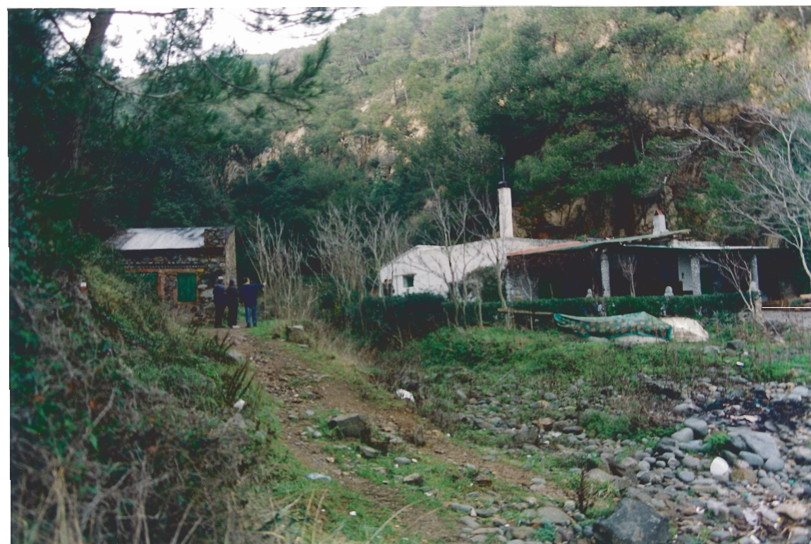
Foto 2. Barraques de pescadors a la cala Pedrosa. L'edificació de la dreta es troba parcialment dins el DPMT, i no disposa de concessió per part de la DGC.
