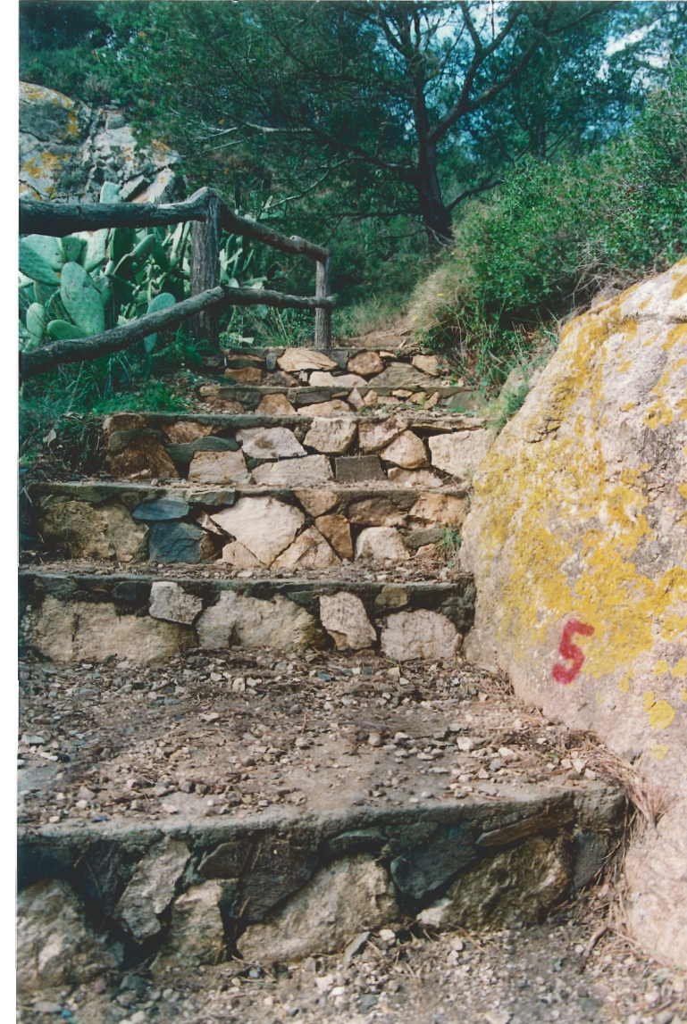
Foto 28. Escales de formigó i pedra entre el PK 2+100 i el PK 2+210 En aquest tram es reconstruirà una escala de pedra, substituint la barana actual per una de nova.
