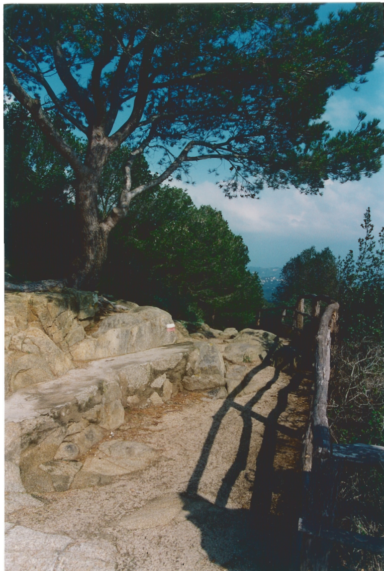
Foto 29. Banc de pedra i barana a l'alçada del PK 2+180. Es proposa la demolició del primer i la substitució de la barana per una de nova, també de fusta.
