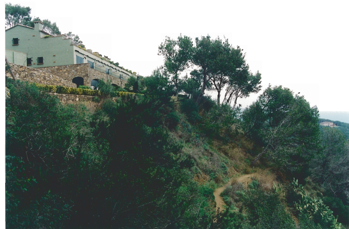
Foto 26. En aquesta zona (PK 2+050 al PK 2+085) es detecta risc d'erosió de materials, pel que s'ha proposat la construcció d'un mur de contenció en el marge interior del camí.
