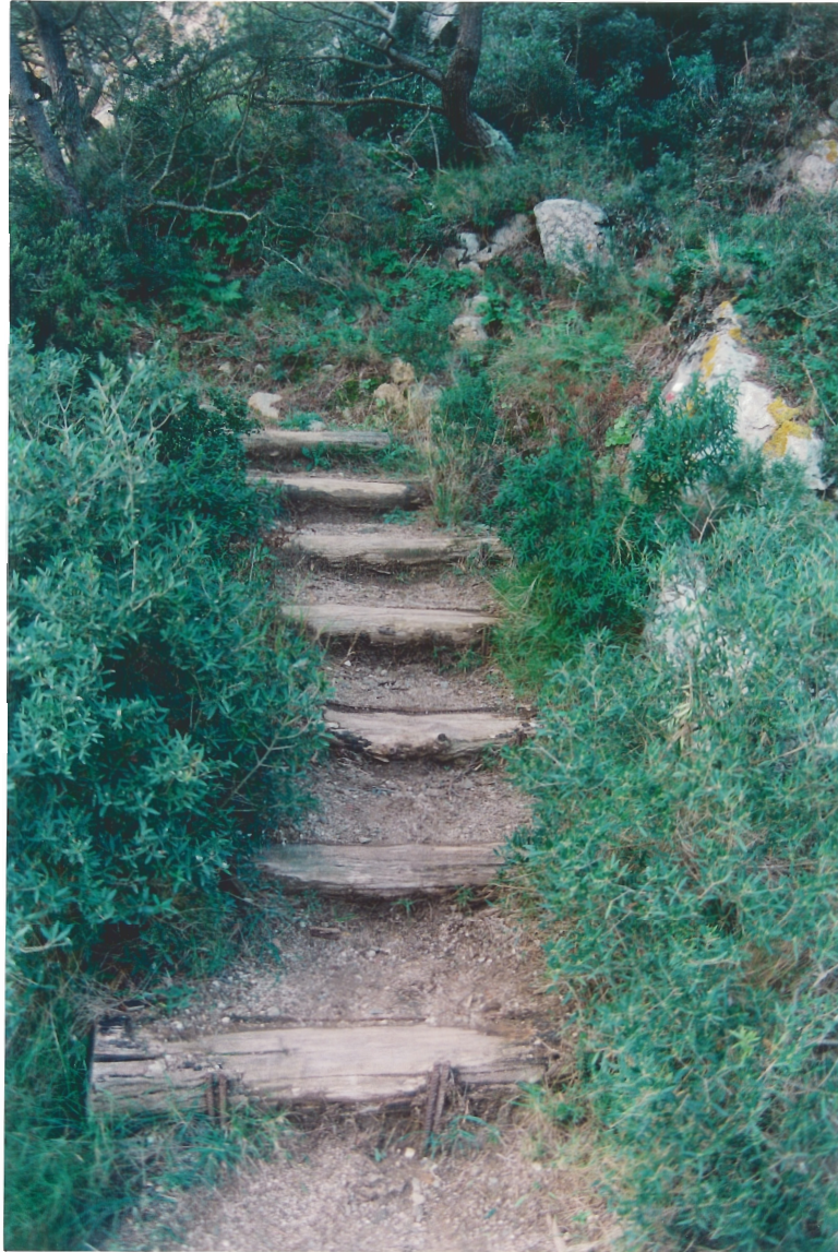
Foto 27. Graons de fusta al PK 2+090. Es proposa la seva reposició amb el model de graó de fusta dissenyat en el Projecte.
