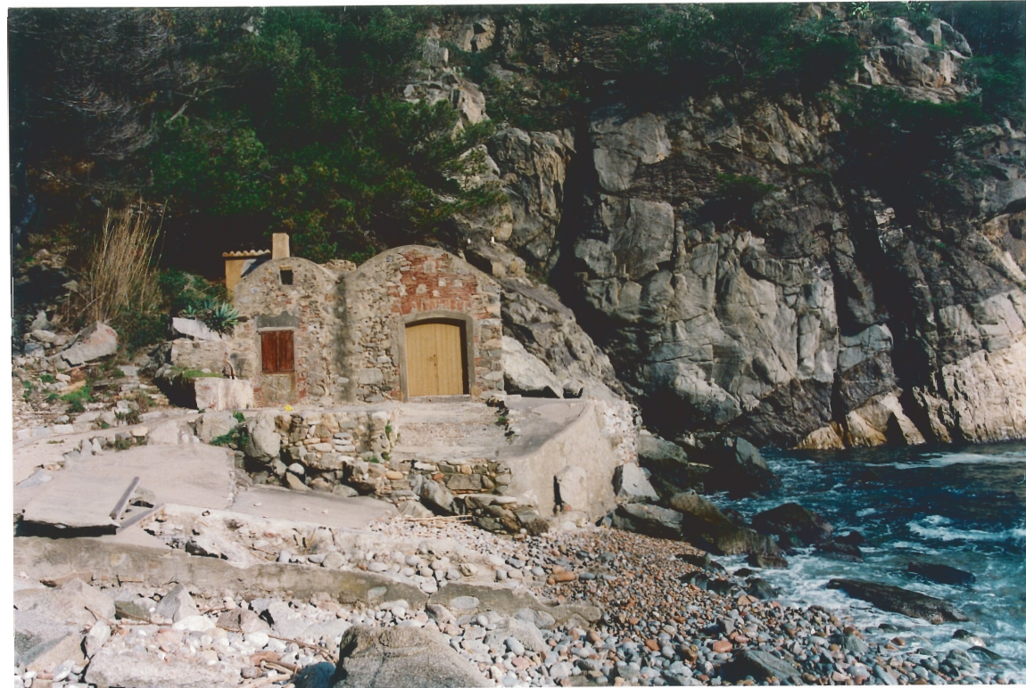
Foto 15. Construccions a la cala del Cau. Aquestes edificacions no disposen de concessió per part de la DGC, a banda de trobar-se força deteriorades per l'acció de l'onatge.
