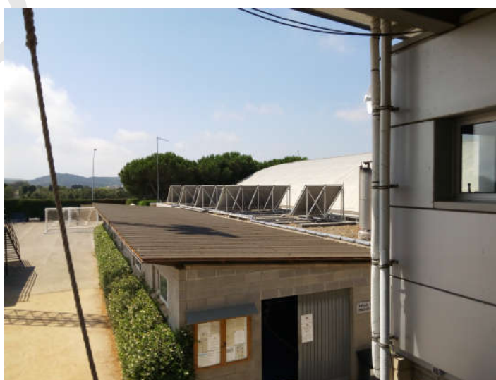
Figura 6 Instal·lació solar tèrmica del Pavelló de hoquei i Estadi municipal
