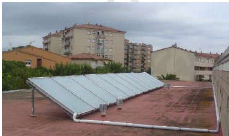
Figura 7 Instal·lació solar tèrmica del Pavelló poliesportiu municipal
