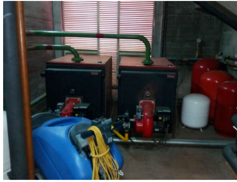
Calderes existents actualment
