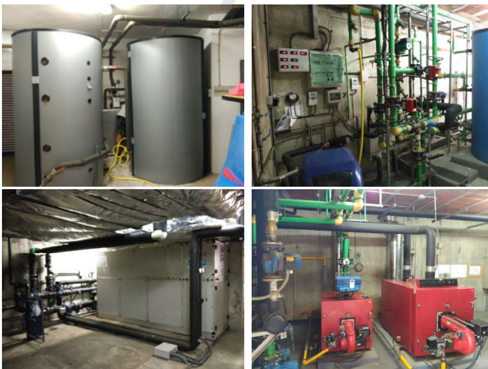
Figures 2 Calderes de gas natural i UTA de la Piscina Municipal
