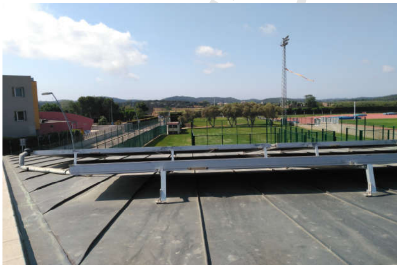
Figura 5 Instal·lació solar tèrmica de la Piscina municipal
