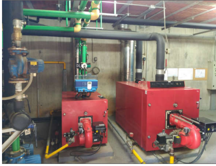
Calderes existents actualment
