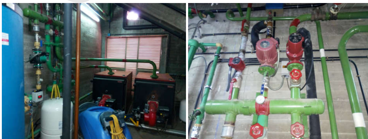
Figures 4 Calderes de gas natural i circuits de calefacció i ACS del Pavelló poliesportiu municipal
