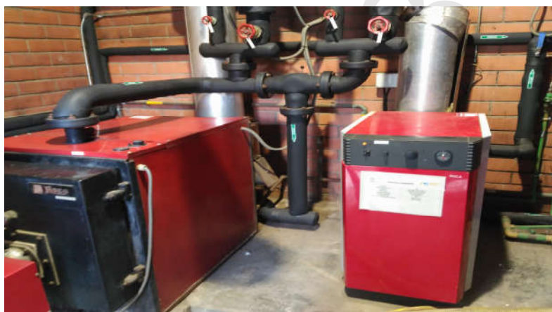
Figures 3 Calderes de gas natural del Pavelló de Hoquei i Estadi municipal
