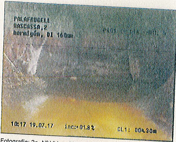
10:17 19.07.17 inc:+01.8% CL1: 004.30m Fotografía: 2a, Nº Video: 0099, 00:02:40 4,3m, Pozo oculto (arqueta)
