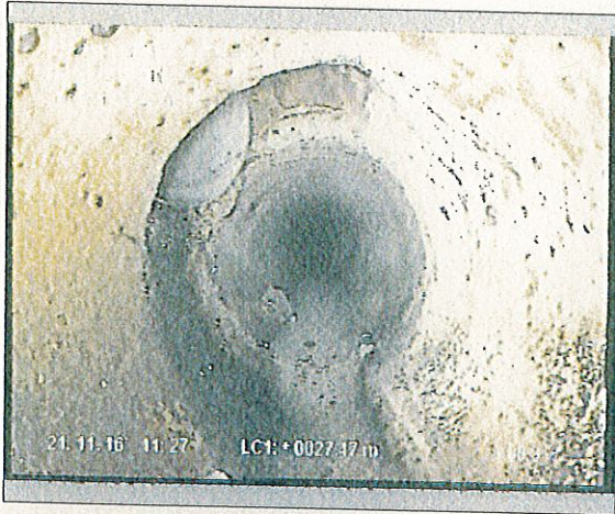
Foto: 8_1_3_21112016_101840_A.JPG 27,7m, Acometida desde 10 hasta 11 horas
