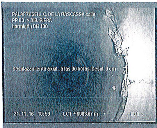
Foto: 7_1_6_21112016_094451_B.JPG 3,6m, Desplazamiento axial , a las 06 horas. Despl. 0 cm
