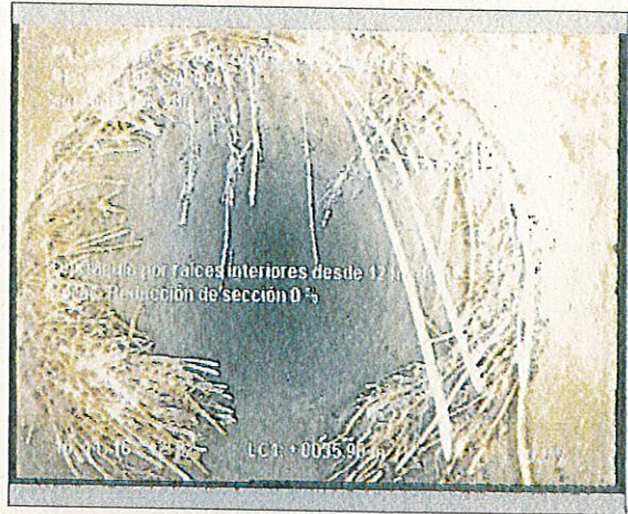
Foto: 1_1_7_16112016_112425_B.JPG 36m, Obstáculo por raíces interiores desde 12 hasta 12 horas. Reducción de sección 0 %
