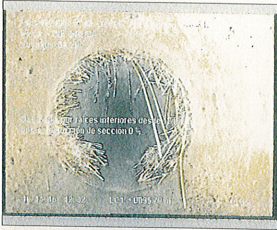
Foto: 1_1_7_16112016_112415_A.JPG 36m, Obstáculo por raíces interiores desde 12 hasta 12 horas. Reducción de sección 0 %
