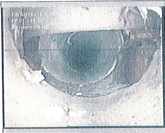
Foto: 3_1_9_16112016_125146_A.JPG 19m, Roturas. Faltan trozos desde 04 hasta 08 horas
