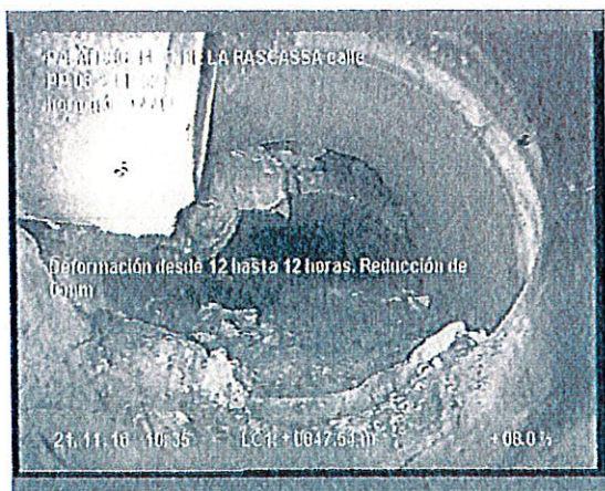
Foto: 6_1_7_21112016_092705_A.JPG 47,8m, Deformación desde 12 hasta 12 horas. Reducción de 0 mm
