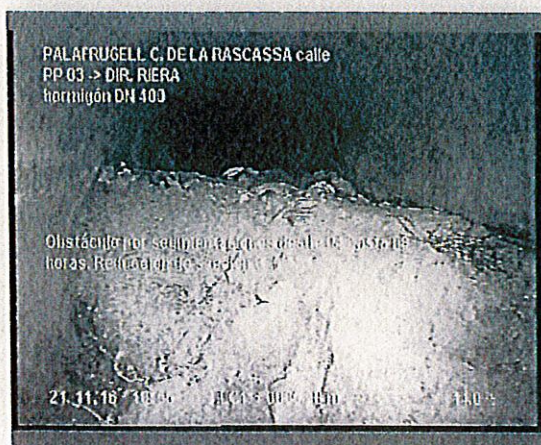
Foto: 7_1_8_21112016_094643_B.JPG 5m, Obstáculo por sedimentaciones desde 04 hasta 08 horas. Reducción de sección 0 %
