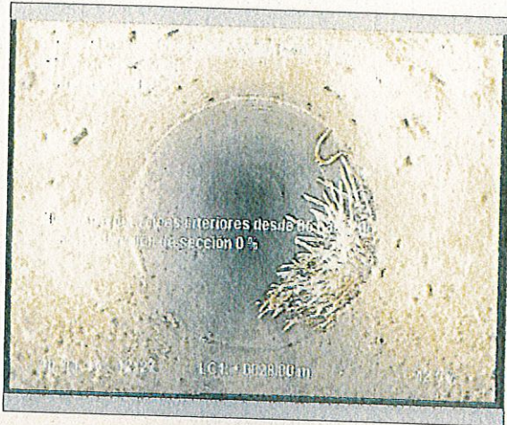
Foto: 1_1_5_16112016_110739_A.JPG 29,1m, Obstáculo por raíces interiores desde 05 hasta 06 horas. Reducción de sección 0 %
