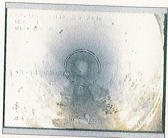
Foto: 8_1_2_21112016_101729_B.JPG 21,5m, Acometida a las 09 horas
