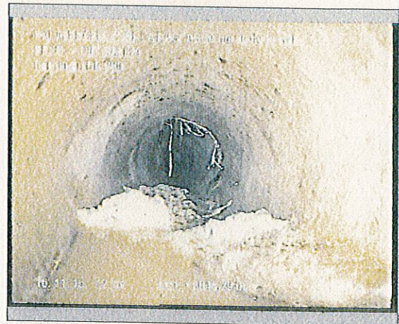
Foto: 1_1_8_16112016_112544_B.JPG 45,2m, Obstáculo por sedimentaciones desde 04 hasta 07 horas. Reducción de sección 0 %
