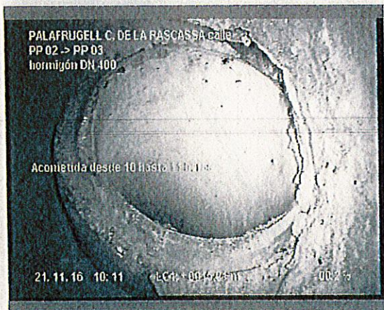
Foto: 5_1_7_21112016_090237_B.JPG 15,9m, Acometida desde 10 hasta 11 horas
