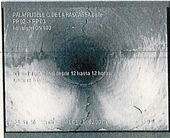
Foto: 5_1_3_21112016_085757_A.JPG 2m, Grieta longitudinal desde 12 hasta 12 horas. Anchura 0 cm
