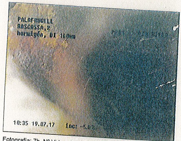
Fotografía: 7b, Nº Video: 0099, 00:01:43 5,6m, Inspección interrumpida CAIDA EN VERTICAL
