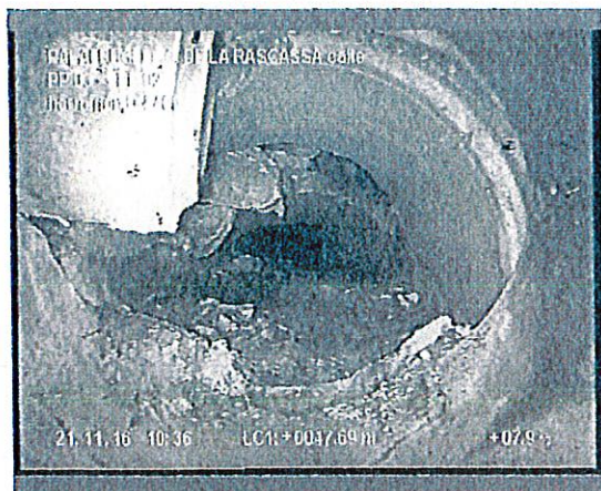
Foto: 6_1_9_21112016_092745_A.JPG 48,1m, Obstáculo por sedimentaciones desde 02 hasta 11 horas. Reducción de sección 0 %
