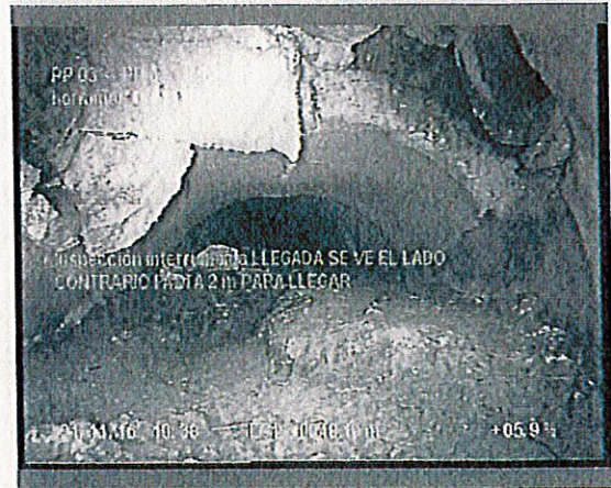
Foto: 6_1_10_21112016_092952_B.JPG 48,1m, Inspección interrumpida LLEGADA SE VE EL LADO CONTRARIO FALTA 2 m PARA LLEGAR
