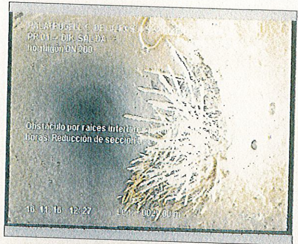
Foto: 1_1_4_16112016_111924_B.JPG 29,1m, Obstáculo por raíces interiores desde 05 hasta 06 horas. Reducción de sección 0 %
