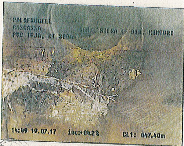
Fotografía: 28a, Nº Video: 0100, 00:07:52 47,4m, MALA ALINEACION DE TUBOS CON ENTRADA DE RAICES
