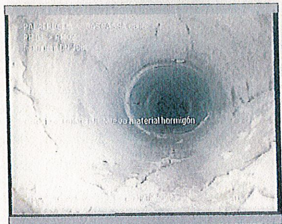
Foto: 3_1_4_16112016_123809_B.JPG 5,4m, Cambio del materiall. Nuevo material hormigón
