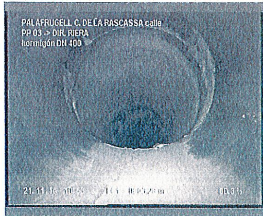
Foto: 7_1_6_21112016_094441_A.JPG 3,6m, Desplazamiento axial , a las 06 horas. Despl. 0 cm
