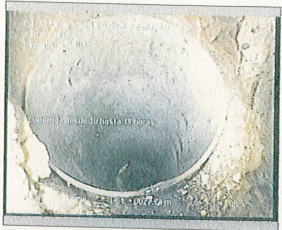
Foto: 8_1_3_21112016_101832_B.JPG 27,7m, Acometida desde 10 hasta 11 horas
