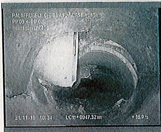
Foto: 6_1_7_21112016_092633_A.JPG 47,8m, Acometida desde 09 hasta 10 horas
