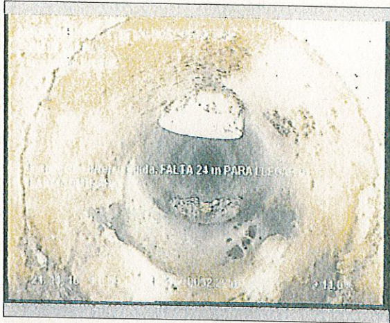
Foto: 8_1_5_21112016_102614_A.JPG 32,4m, Inspección interrumpida
