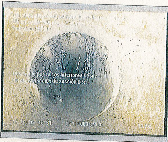
Foto: 1_1_6_16112016_112322_A.JPG 35m, Obstáculo por raíces interiores desde 12 hasta 12 horas. Reducción de sección 0 %
