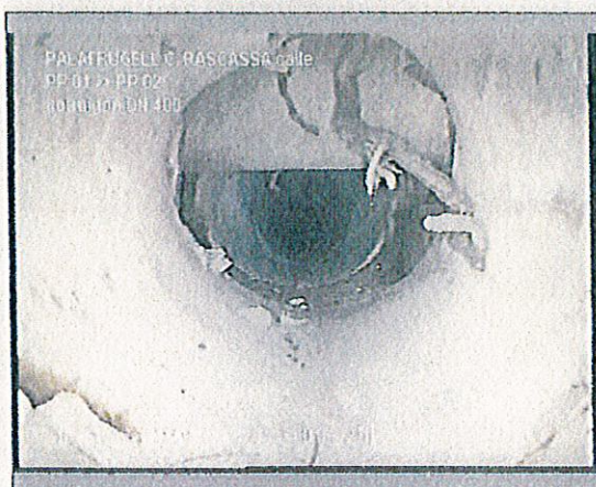
Foto: 3_1_8_16112016_125101_A.JPG 19m, Comentario
