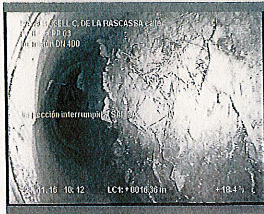
Foto: 5_1_9_21112016_090421_B.JPG 16,1m, Inspección interrumpida
