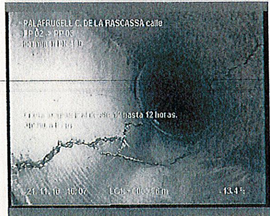
Foto: 5_1_3_21112016_085910_B.JPG 2m, Grieta longitudinal desde 12 hasta 12 horas. Anchura 0 cm
