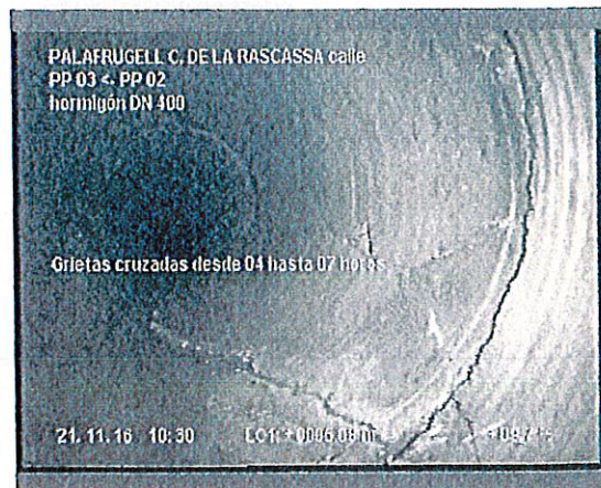
Foto: 6_1_3_21112016_092133_A.JPG 5,2m, Grietas cruzadas desde 04 hasta 07 horas
