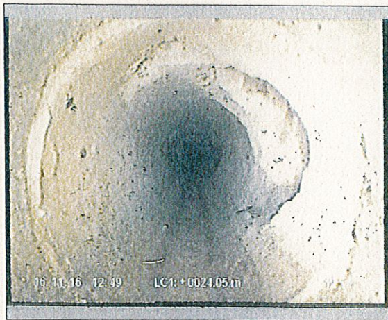
Foto: 1_1_4_16112016_110710_A.JPG 24,4m, Acometida desde 02 hasta 03 horas
