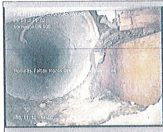
Foto: 3_1_9_16112016_125157_B.JPG 19m, Roturas. Faltan trozos desde 04 hasta 08 horas
