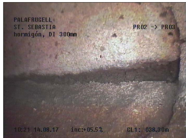
Fotografía: 53a, Nº Video: 115, 00:24:34 38,3m, Grieta longitudinal a las 03 horas. Anchura ? cm
