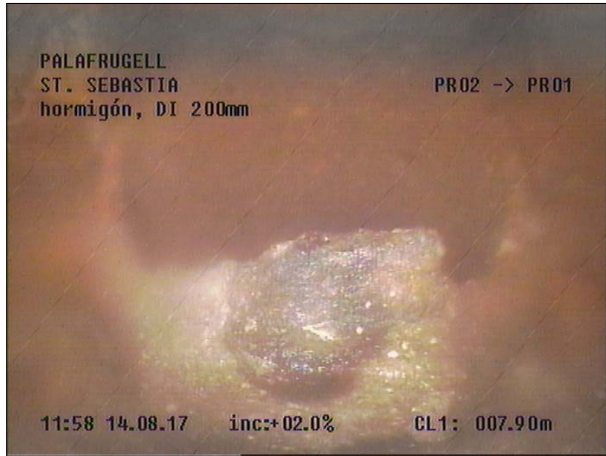
Fotografía: 84b, Nº Video: 115, 00:03:52 7,9m, Acometida desde 12 hasta 02 horas
