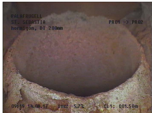
Fotografía: 4b, Nº Video: 115, 00:00:43 1,5m, Acometida desde 09 hasta 11 horas
