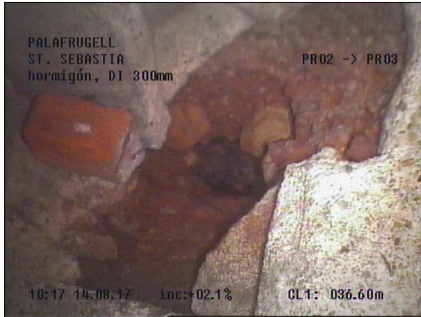
Fotografía: 48b, Nº Video: 115, 00:21:36 36,6m, Roturas. Faltan trozos desde 09 hasta 12 horas, con el fondo visible
