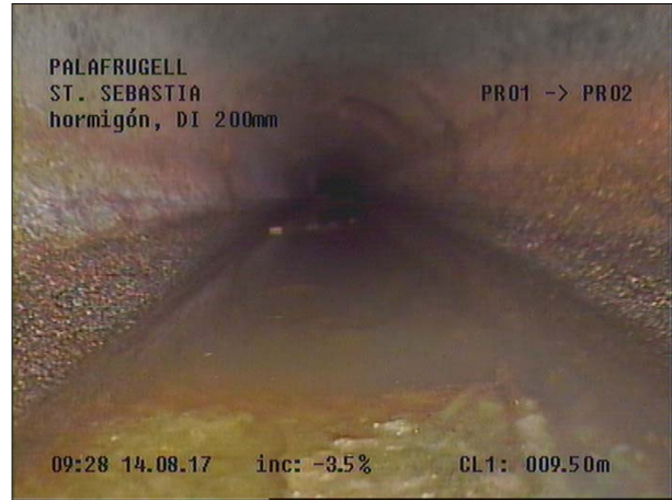
Fotografía: 11a, Nº Video: 115, 00:05:44 9,5m, Retención de agua ? m, desde 05 hasta 07 horas
