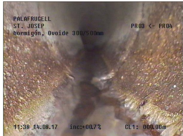
Fotografía: 74b, Nº Video: 115, 00:00:15 0m, Inicio de la inspección
