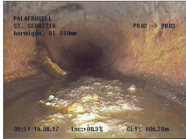
Fotografía: 22a, Nº Video: 115, 00:03:19 6,2m, Obstáculo por sedimentaciones desde 05 hasta 07 horas. Reducción de sección ? %
