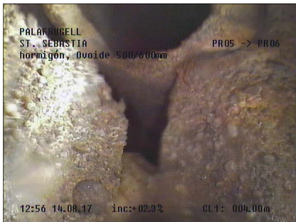
Fotografía: 112a, Nº Video: 115, 00:02:46 4m, Junta abierta desde 03 hasta 05 horas, con el fondo visible
