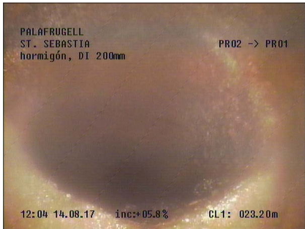
Fotografía: 89b, Nº Video: 115, 00:08:00 23,2m, Acometida desde 08 hasta 11 horas
