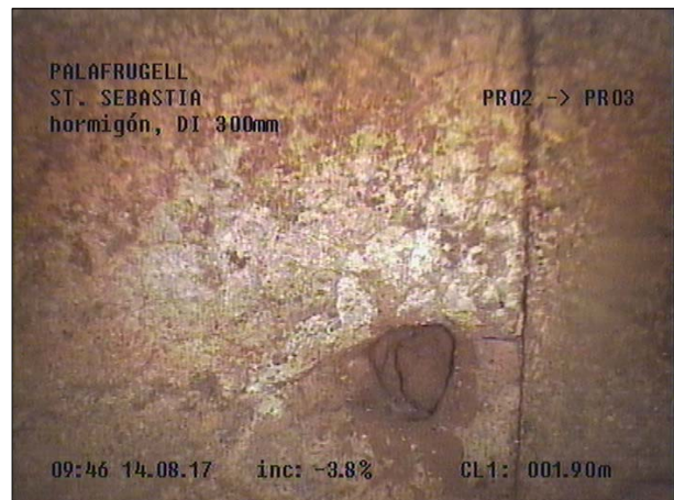
Fotografía: 18b, Nº Video: 115, 00:00:26 1,9m, PEQUEÑA Rotura. Faltan trozos desde 02 hasta 03 horas
