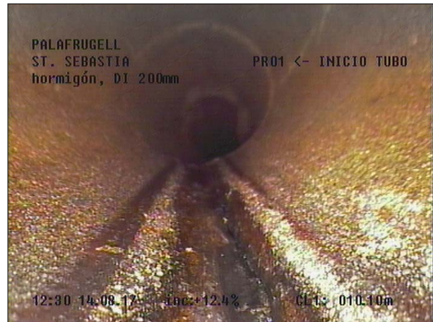
Fotografía: 103a, Nº Video: 115, 00:06:03 10,1m, Fin de la inspección
