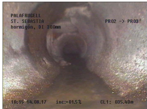
Fotografía: 46a, Nº Video: 115, 00:20:30 35,9m, Acometida desde 11 hasta 12 horas POSIBLEMENTE ANULADA
