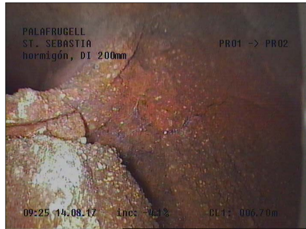
Fotografía: 8a, Nº Video: 115, 00:03:47 6,7m, Grieta transversal desde 03 hasta 04 horas, JUNTO A LA ACOMETIDA. Anchura ? cm
