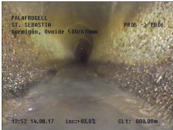
Fotografía: 108a, Nº Video: 115, 00:00:04 0m, Inicio de la inspección
