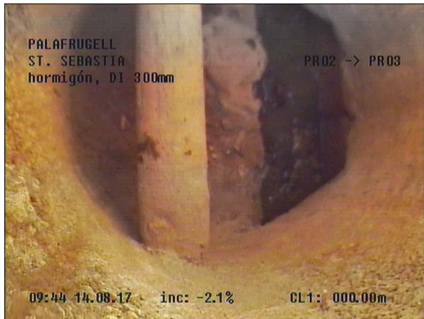
Fotografía: 17a, Nº Video: 115, 00:00:11 0m, Inicio de la inspección
