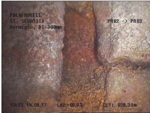
Fotografía: 54a, Nº Video: 115, 00:24:58 38,3m, Roturas. Faltan trozos desde 07 hasta 09 horas, con el fondo visible EN LA JUNTA
