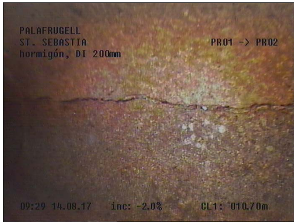
Fotografía: 13a, Nº Video: 115, 00:06:46 10,7m, Grieta longitudinal a las 12 horas. Anchura ? cm
