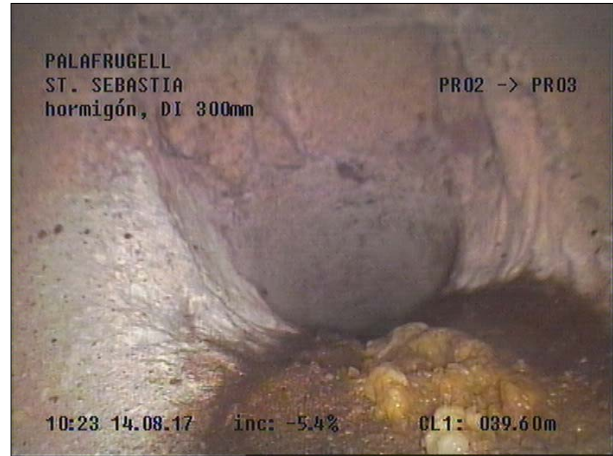
Fotografía: 55a, Nº Video: 115, 00:25:45 39,6m, Acometida desde 10 hasta 11 horas
