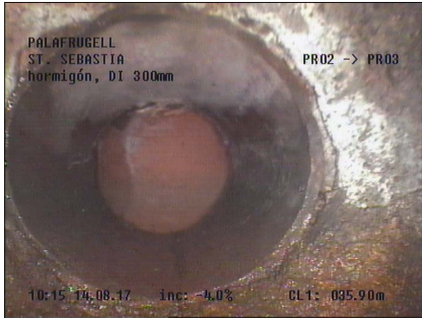
Fotografía: 46b, Nº Video: 115, 00:20:30 35,9m, Acometida desde 11 hasta 12 horas POSIBLEMENTE ANULADA
