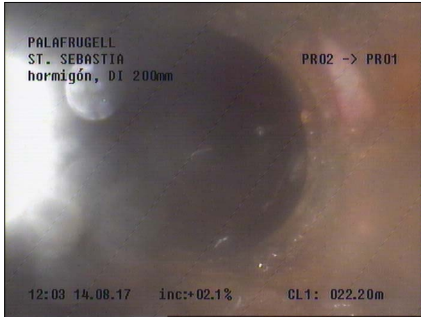
Fotografía: 88b, Nº Video: 115, 00:07:16 22,2m, Acometida desde 10 hasta 12 horas
