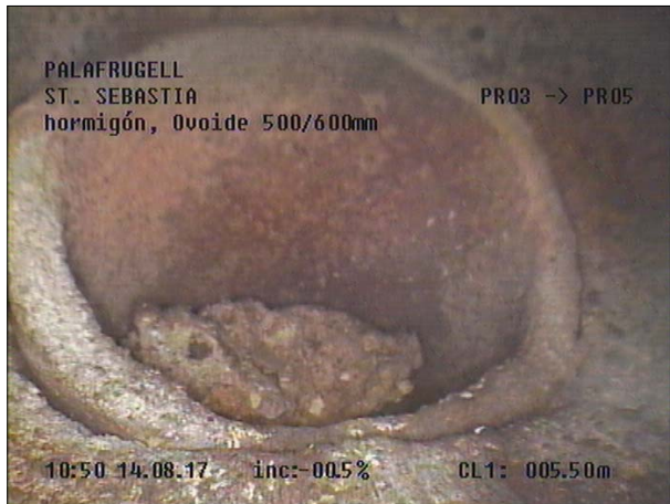
Fotografía: 67a, Nº Video: 115, 00:02:07 5,5m, Acometida desde 02 hasta 03 horas
