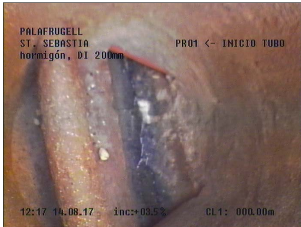
Fotografía: 94a, Nº Video: 115, 00:00:09 0m, Inicio de la inspección
