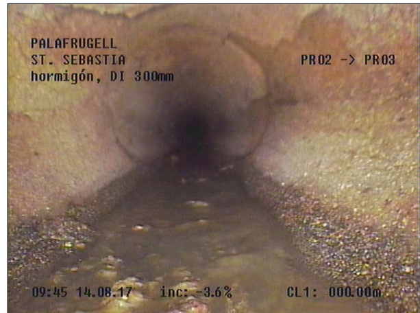
Fotografía: 17b, Nº Video: 115, 00:00:11 0m, Inicio de la inspección
