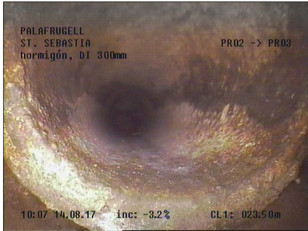
Fotografía: 37b, Nº Video: 115, 00:15:08 23,5m, Acometida desde 01 hasta 03 horas
