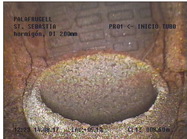
Fotografía: 99a, Nº Video: 115, 00:03:54 8,6m, Acometida desde 12 hasta 02 horas
