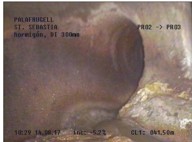
Fotografía: 61a, Nº Video: 115, 00:28:36 41,5m, Fin de la inspección SALIDA DE 10 A 11 HORAS
