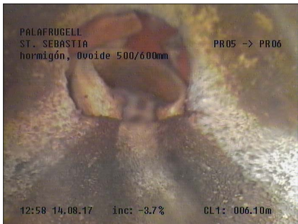
Fotografía: 114b, Nº Video: 115, 00:03:56 6,1m, Acometida desde 09 hasta 10 horas
