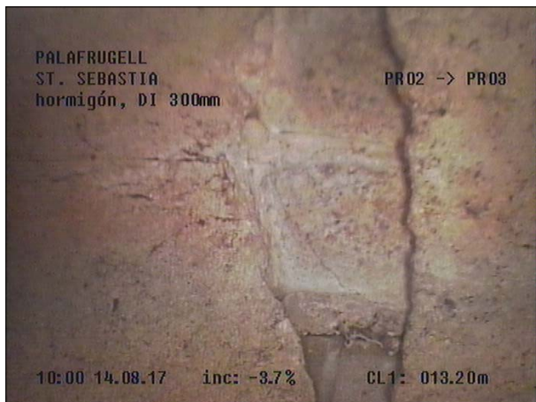
Fotografía: 31a, Nº Video: 115, 00:09:59 13,2m, VISTA DE LA JUNTA
