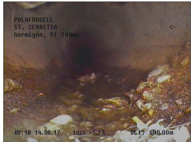
Fotografía: 3b, Nº Video: 115, 00:00:16 0m, Inicio de la inspección
