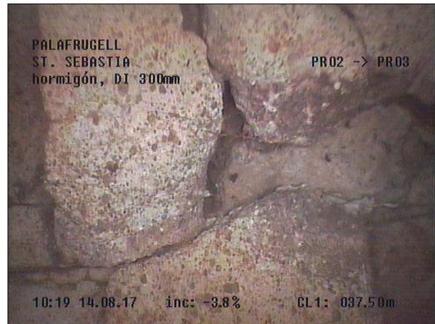
Fotografía: 51a, Nº Video: 115, 00:23:16 37,5m, Grietas cruzadas desde 01 hasta 03 horas
