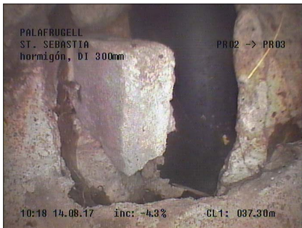
Fotografía: 49b, Nº Video: 115, 00:22:25 37,3m, Roturas. Faltan trozos desde 10 hasta 02 horas, con el fondo visible PASA UN SERVICIO
