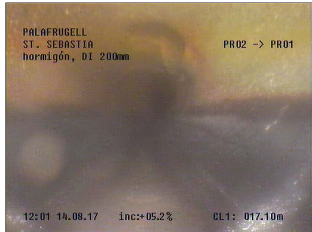
Fotografía: 87a, Nº Video: 115, 00:06:10 17,8m, Acometida desde 01 hasta 03 horas
