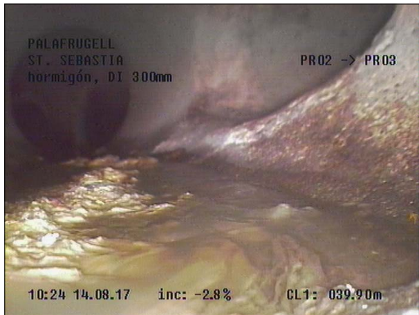
Fotografía: 56a, Nº Video: 115, 00:26:24 40,5m, Acometida desde 01 hasta 05 horas
