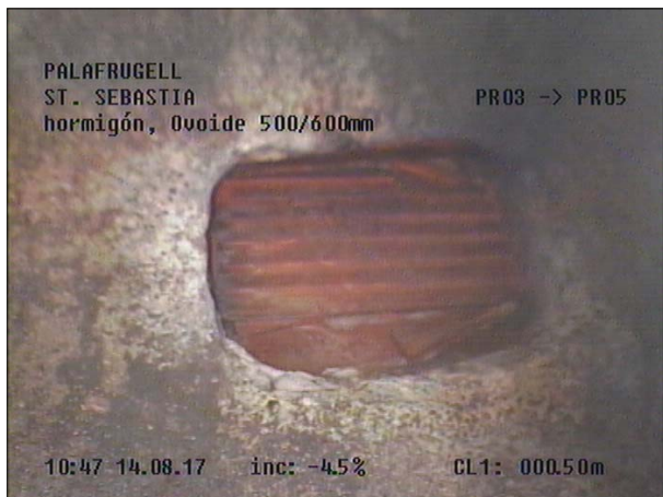
Fotografía: 66a, Nº Video: 115, 00:00:34 0,5m, REPARACION, desde 12 hasta 01 horas
