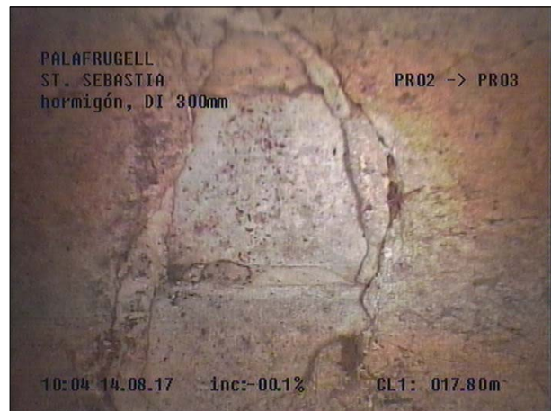
Fotografía: 34a, Nº Video: 115, 00:12:39 17,8m, REPARACION, desde 11 hasta 01 horas
