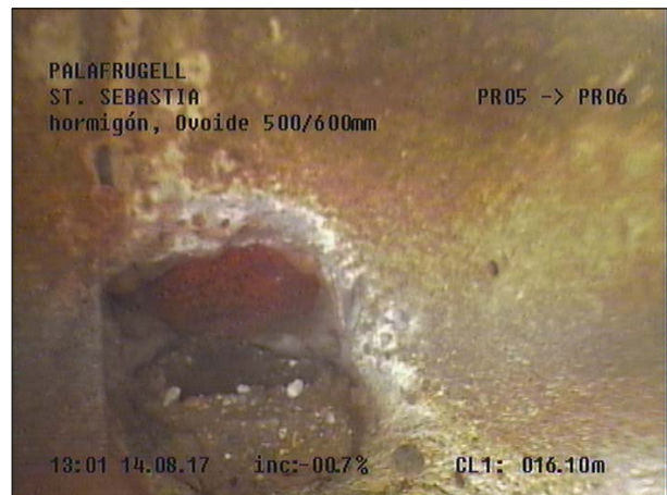
Fotografía: 115a, Nº Video: 115, 00:07:13 16,1m, Acometida desde 10 hasta 11 horas
