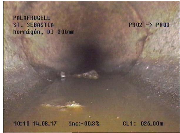
Fotografía: 41a, Nº Video: 115, 00:16:59 26,4m, Acometida desde 11 hasta 12 horas
