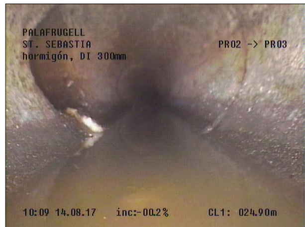
Fotografía: 40a, Nº Video: 115, 00:16:19 25,5m, Acometida desde 09 hasta 11 horas
