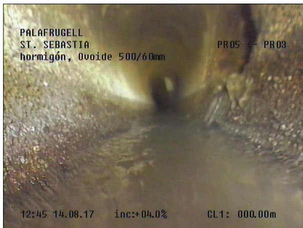
Fotografía: 105a, Nº Video: 115, 00:01:33 1m, Acometida desde 02 hasta 03 horas
