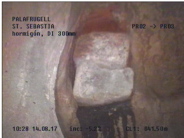
Fotografía: 60a, Nº Video: 115, 00:28:16 41,5m, REPARACION DE 9 A 11 HORAS
