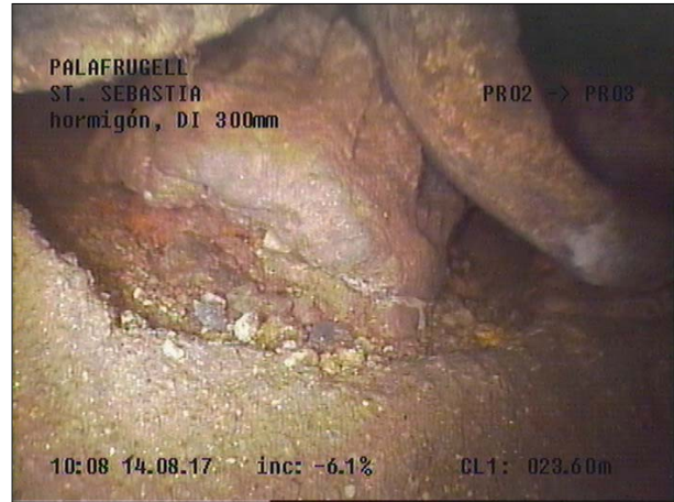
Fotografía: 38a, Nº Video: 115, 00:15:24 23,6m, Roturas. Faltan trozos desde 02 hasta 04 horas, con el fondo visible ENTRE LAS DOS ACOMETIDAS
