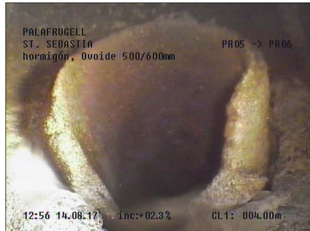
Fotografía: 111b, Nº Video: 115, 00:02:31 4m, Acometida desde 02 hasta 03 horas
