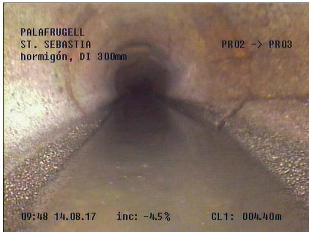
Fotografía: 19a, Nº Video: 115, 00:01:41 4,9m, VISTA DE LA JUNTA CON GRIETAS LONGITUDINALES DE 12 A 4
