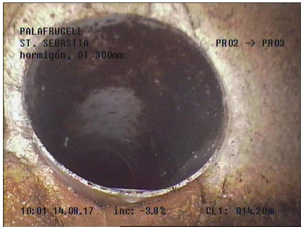
Fotografía: 32b, Nº Video: 115, 00:10:56 14,2m, Acometida desde 02 hasta 04 horas
