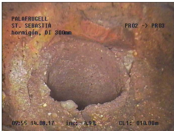
Fotografía: 26b, Nº Video: 115, 00:05:57 10m, Acometida desde 10 hasta 11 horas
