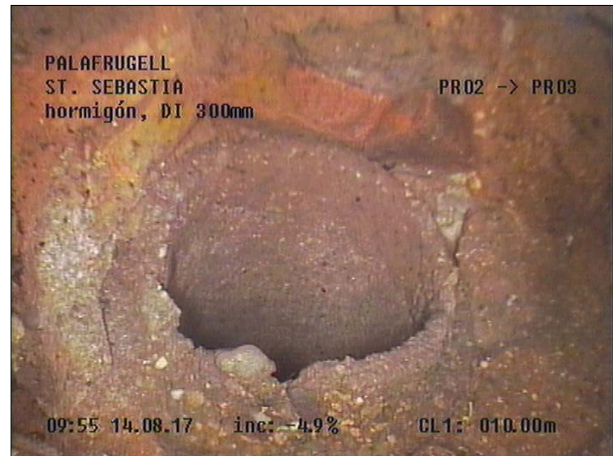
Fotografía: 26a, Nº Video: 115, 00:05:57 10m, Acometida desde 10 hasta 11 horas
