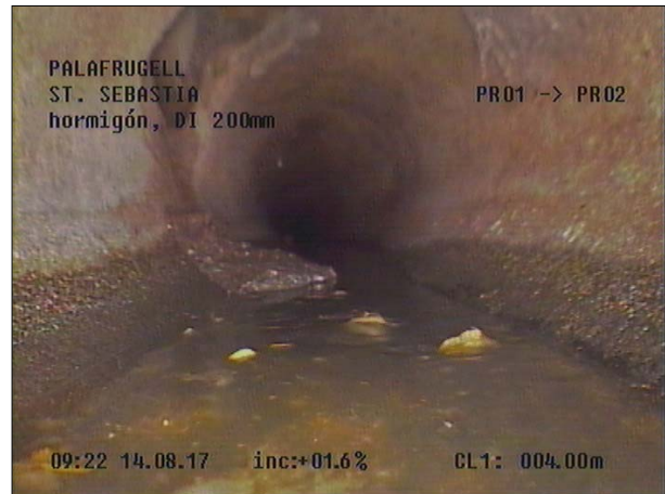
Fotografía: 6a, Nº Video: 115, 00:02:39 4,3m, Acometida desde 09 hasta 11 horas
