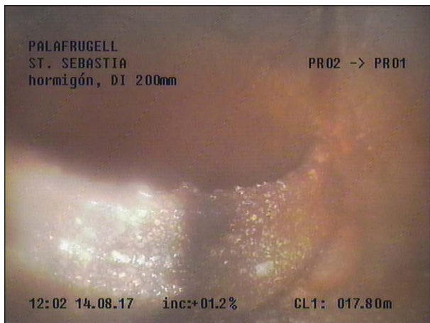
Fotografía: 87b, Nº Video: 115, 00:06:10 17,8m, Acometida desde 01 hasta 03 horas
