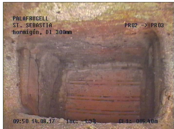
Fotografía: 20b, Nº Video: 115, 00:02:29 5,4m, Acometida desde 05 hasta 06 horas CON ARQUETA OCULTA
