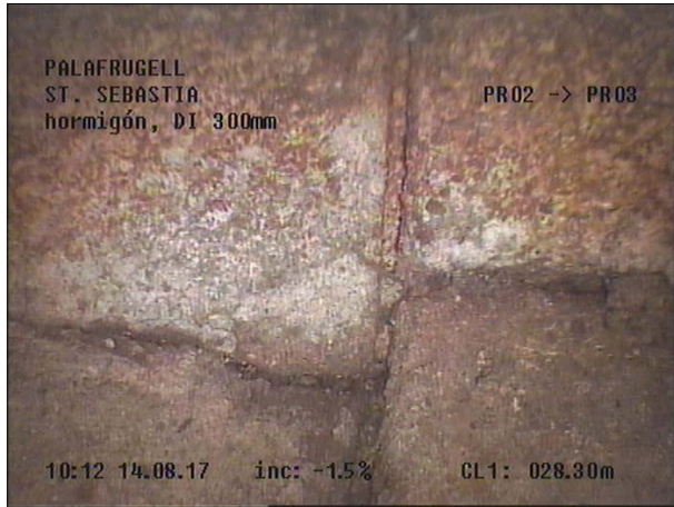
Fotografía: 43a, Nº Video: 115, 00:17:58 28,3m, Grieta longitudinal desde 03 hasta 04 horas. Anchura ? cm
