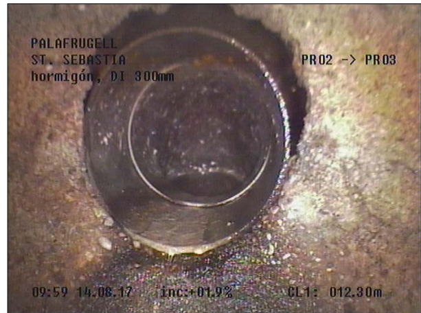
Fotografía: 30b, Nº Video: 115, 00:09:22 12,3m, Acometida desde 11 hasta 12 horas
