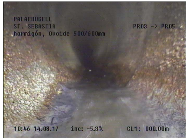
Fotografía: 65b, Nº Video: 115, 00:00:12 0m, Inicio de la inspección
