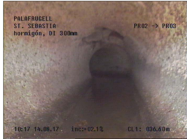
Fotografía: 49a, Nº Video: 115, 00:22:25 37,3m, Roturas. Faltan trozos desde 10 hasta 02 horas, con el fondo visible PASA UN SERVICIO
