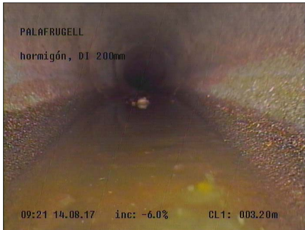
Fotografía: 5a, Nº Video: 115, 00:01:46 3,2m, Retención de agua ? m, desde 05 hasta 07 horas
