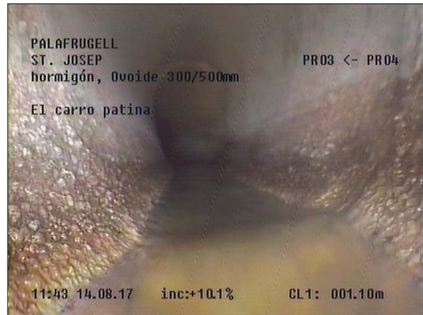
Fotografía: 78a, Nº Video: 115, 00:02:35 1,1m, Inspección interrumpida. LLEGADA
