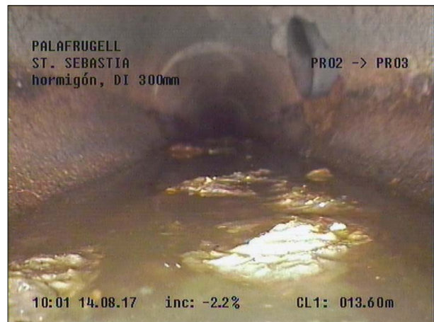
Fotografía: 32a, Nº Video: 115, 00:10:56 14,2m, Acometida desde 02 hasta 04 horas
