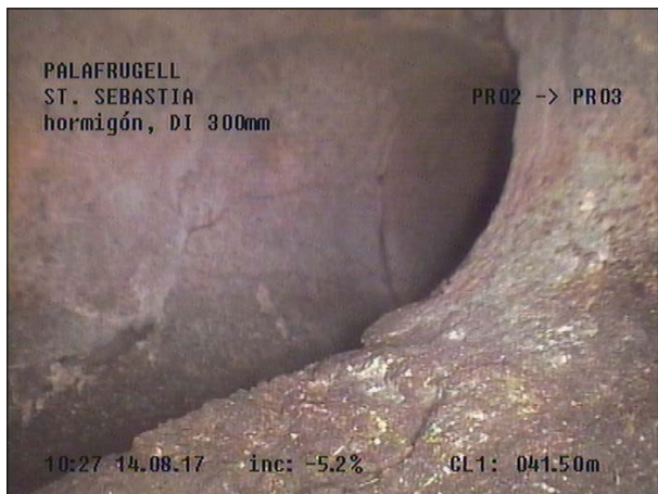
Fotografía: 58a, Nº Video: 115, 00:27:34 41,5m, Acometida desde 04 hasta 05 horas
