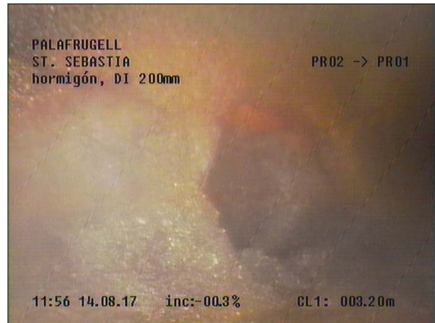
Fotografía: 83a, Nº Video: 115, 00:02:52 3,5m, Acometida desde 09 hasta 11 horas
