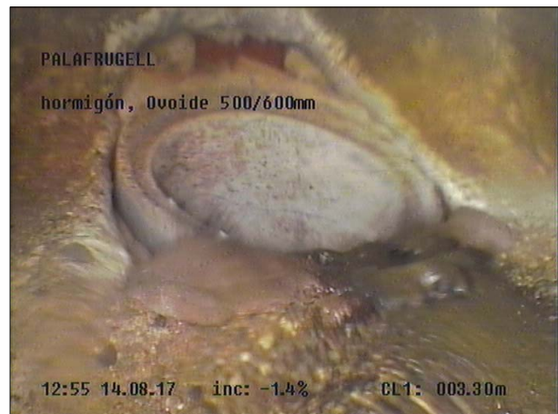
Fotografía: 110b, Nº Video: 115, 00:01:42 3,3m, Acometida desde 09 hasta 10 horas
