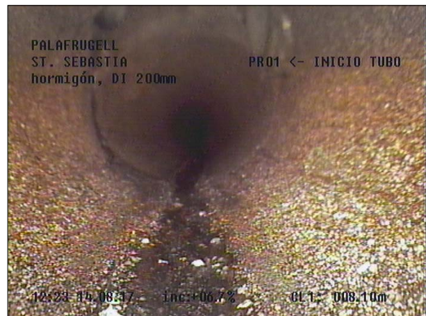
Fotografía: 98a, Nº Video: 115, 00:03:40 8,6m, Acometida desde 10 hasta 11 horas
