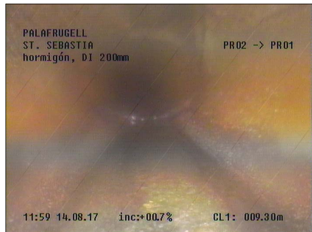
Fotografía: 86a, Nº Video: 115, 00:04:53 9,9m, Acometida desde 01 hasta 03 horas
