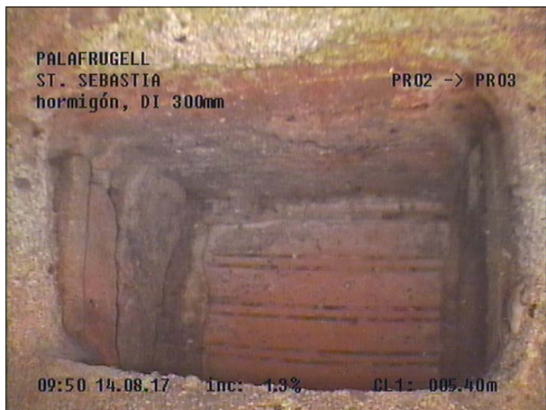
Fotografía: 20a, Nº Video: 115, 00:02:29 5,4m, Acometida desde 05 hasta 06 horas CON ARQUETA OCULTA
