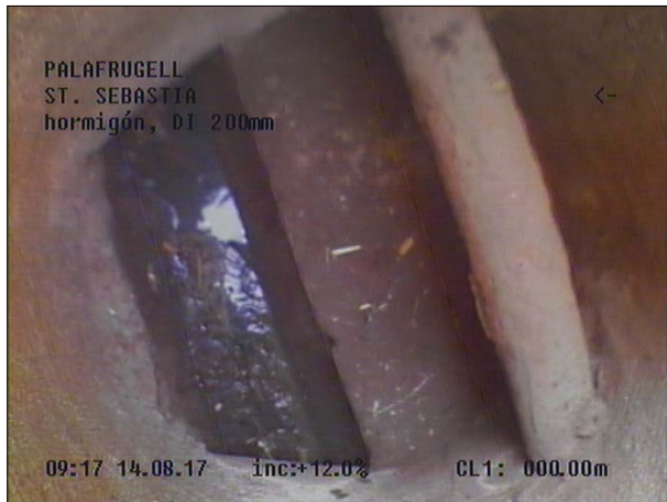
Fotografía: 3a, Nº Video: 115, 00:00:16 0m, Inicio de la inspección
