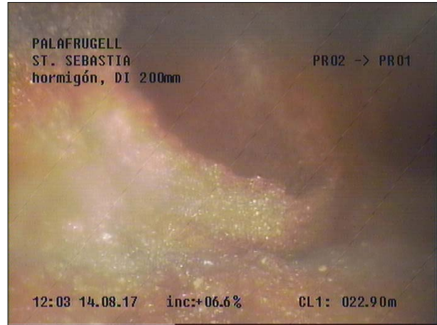
Fotografía: 89a, Nº Video: 115, 00:08:00 23,2m, Acometida desde 08 hasta 11 horas
