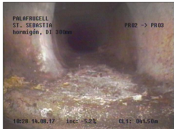
Fotografía: 59a, Nº Video: 115, 00:27:51 41,5m, Acometida desde 01 hasta 02 horas
