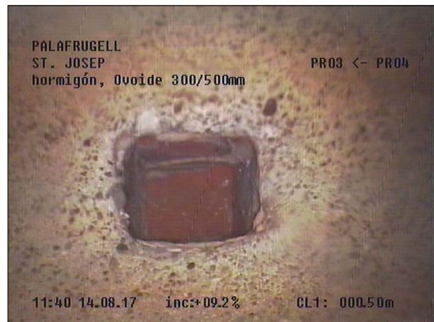
Fotografía: 76a, Nº Video: 115, 00:01:38 1m, Acometida desde 11 hasta 12 horas
