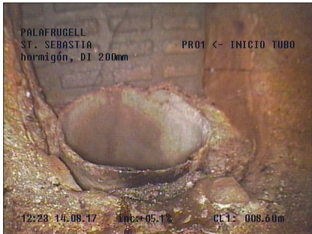
Fotografía: 98b, Nº Video: 115, 00:03:40 8,6m, Acometida desde 10 hasta 11 horas
