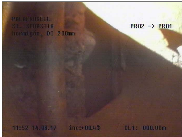
Fotografía: 79a, Nº Video: 115, 00:00:15 0m, Inicio de la inspección
