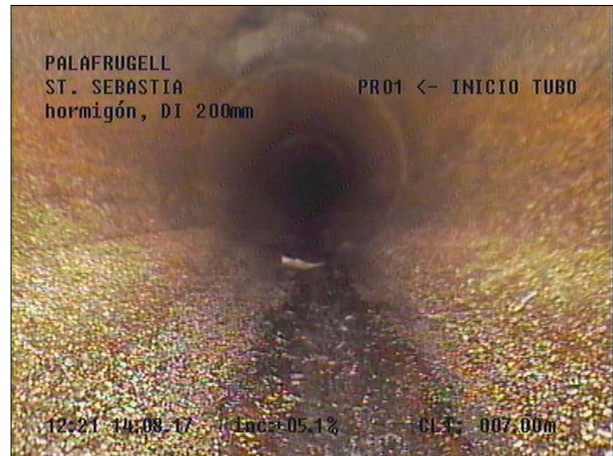
Fotografía: 97a, Nº Video: 115, 00:03:07 7,5m, Acometida desde 11 hasta 12 horas
