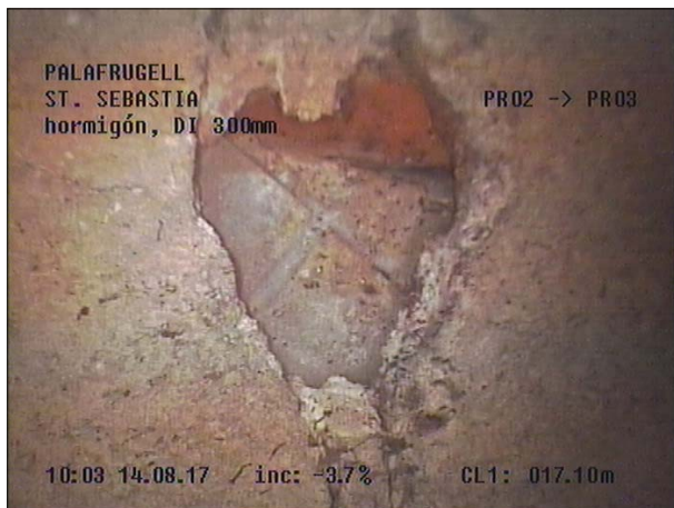
Fotografía: 33b, Nº Video: 115, 00:12:14 17,1m, REPARACION, desde 11 hasta 01 horas
