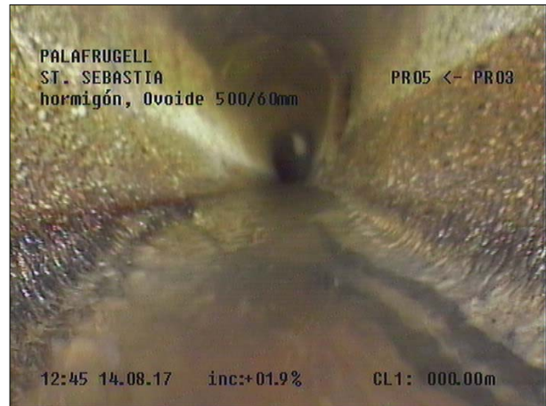
Fotografía: 104b, Nº Video: 115, 00:00:10 0m, Inicio de la inspección
