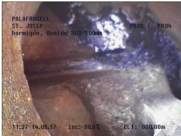
Fotografía: 74a, Nº Video: 115, 00:00:15 0m, Inicio de la inspección
