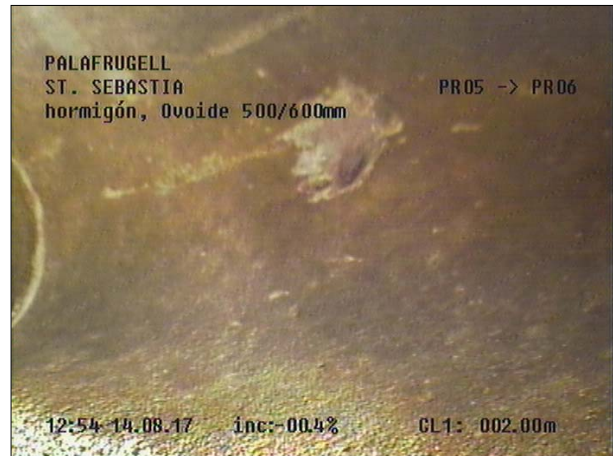
Fotografía: 109a, Nº Video: 115, 00:00:49 2m, Roturas. Faltan trozos a las 12 horas
