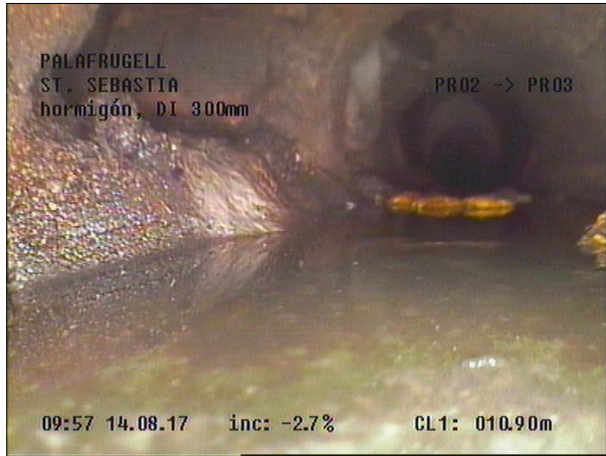
Fotografía: 28a, Nº Video: 115, 00:07:52 11,2m, Acometida desde 08 hasta 11 horas
