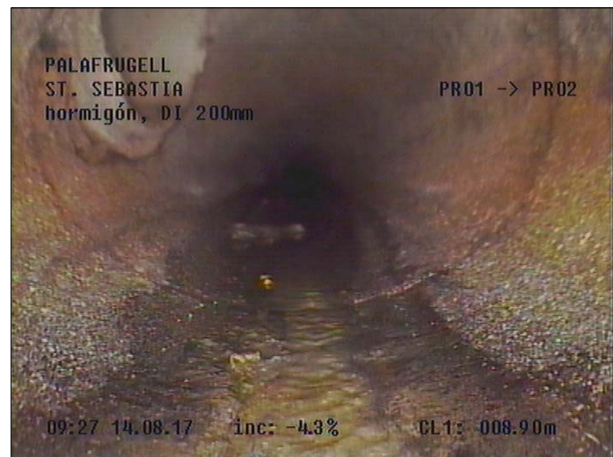
Fotografía: 10a, Nº Video: 115, 00:05:30 9,2m, Acometida desde 09 hasta 11 horas
