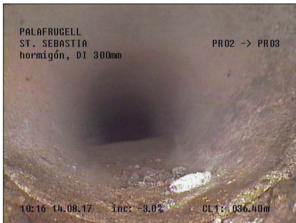
Fotografía: 47b, Nº Video: 115, 00:21:04 36,4m, Acometida desde 08 hasta 12 horas
