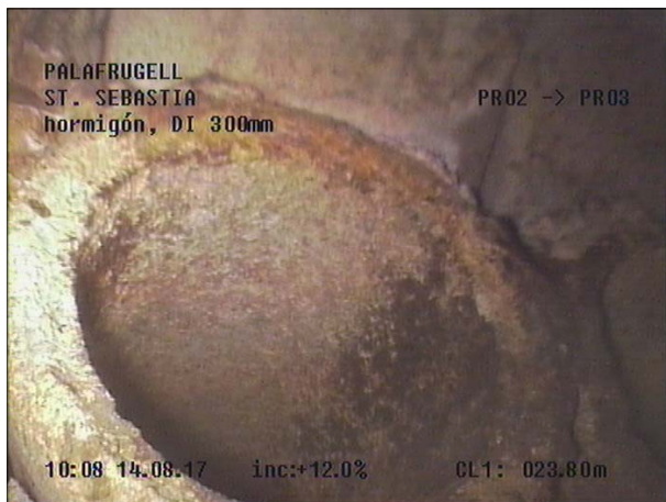
Fotografía: 39a, Nº Video: 115, 00:15:40 23,8m, Acometida desde 01 hasta 03 horas
