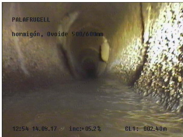
Fotografía: 110a, Nº Video: 115, 00:01:42 3,3m, Acometida desde 09 hasta 10 horas
