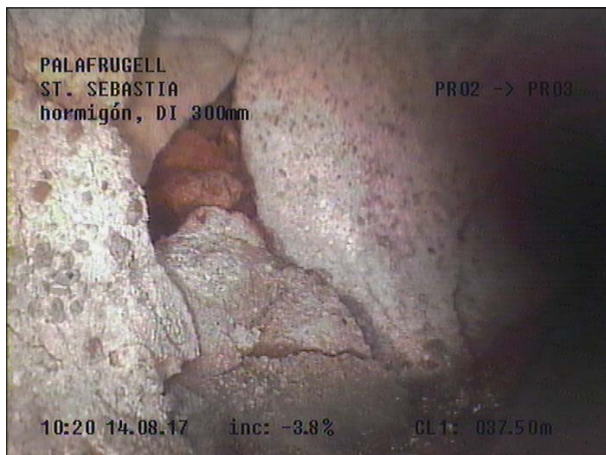
Fotografía: 52a, Nº Video: 115, 00:23:37 37,5m, Grietas cruzadas desde 07 hasta 09 horas
