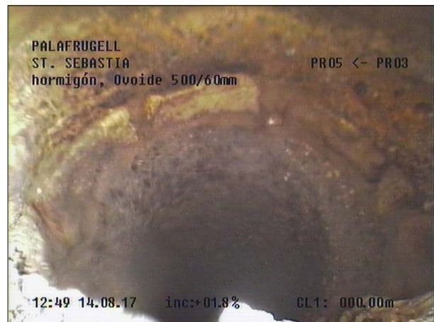
Fotografía: 105b, Nº Video: 115, 00:01:33 1m, Acometida desde 02 hasta 03 horas
