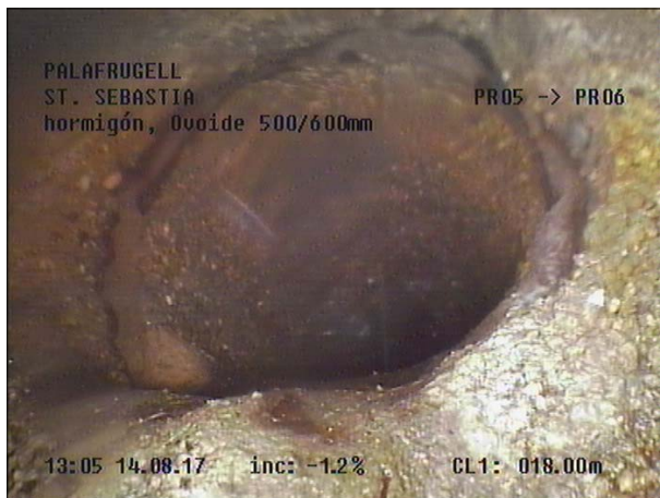
Fotografía: 116b, Nº Video: 115, 00:09:38 18m, Acometida desde 09 hasta 10 horas
