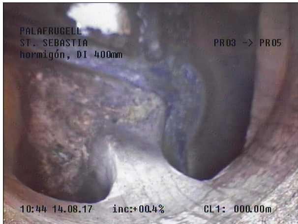
Fotografía: 65a, Nº Video: 115, 00:00:12 0m, Inicio de la inspección
