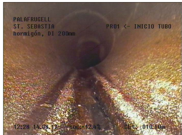
Fotografía: 101a, Nº Video: 115, 00:05:31 10,1m, El carro no puede continuar (stop). LA RUEDA QUEDA ATASCADA EN LA GRIETA
