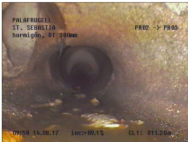
Fotografía: 29a, Nº Video: 115, 00:08:45 11,6m, Acometida desde 09 hasta 11 horas
