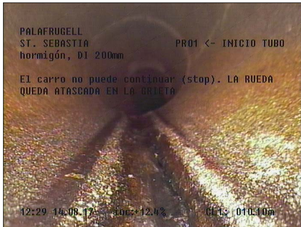
Fotografía: 102a, Nº Video: 115, 00:05:37 10,1m, Inspección interrumpida. LLEGADA
