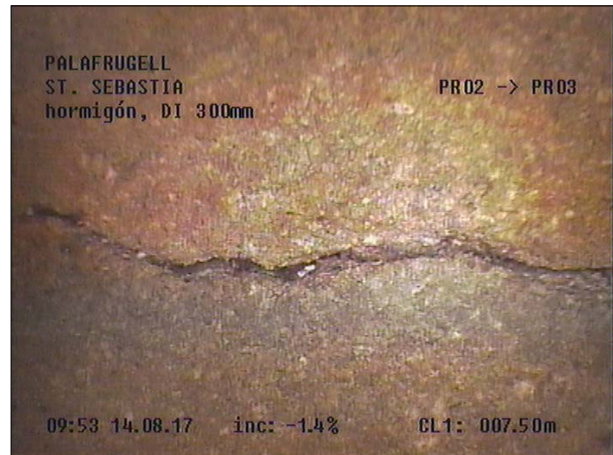
Fotografía: 24a, Nº Video: 115, 00:04:06 7,5m, Grieta longitudinal desde 12 hasta 01 horas. Anchura ? cm
