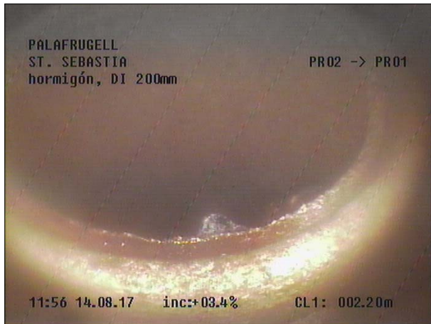
Fotografía: 82b, Nº Video: 115, 00:02:19 2,2m, Acometida desde 01 hasta 03 horas
