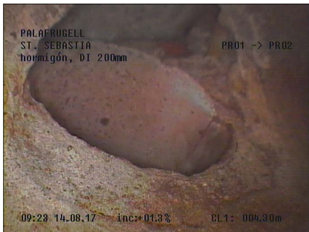
Fotografía: 6b, Nº Video: 115, 00:02:39 4,3m, Acometida desde 09 hasta 11 horas
