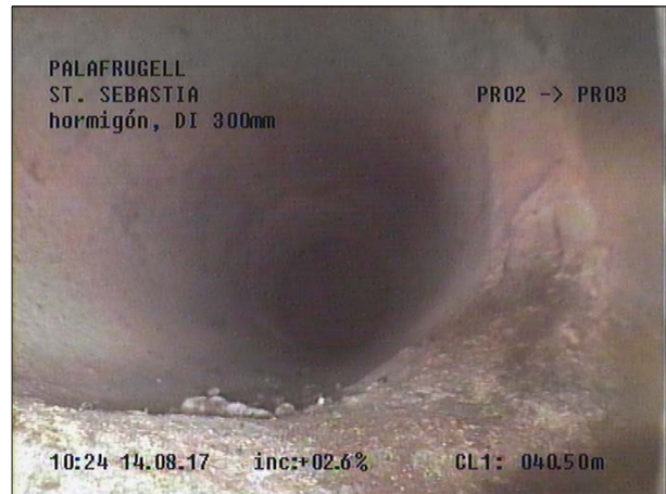
Fotografía: 56b, Nº Video: 115, 00:26:24 40,5m, Acometida desde 01 hasta 05 horas
