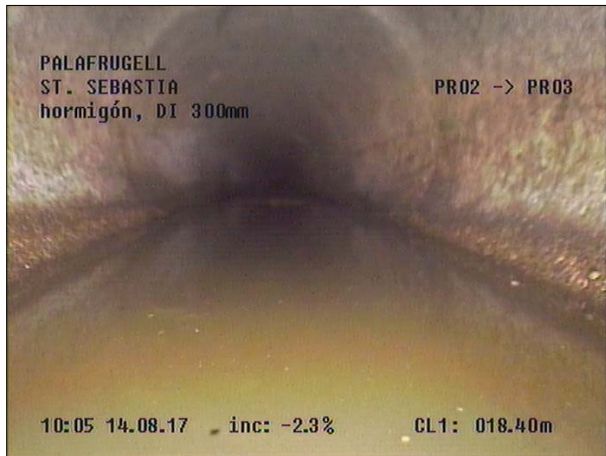
Fotografía: 35a, Nº Video: 115, 00:13:02 18,4m, Retención de agua ? m, desde 05 hasta 07 horas
