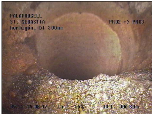
Fotografía: 23a, Nº Video: 115, 00:03:39 6,8m, Acometida desde 09 hasta 11 horas
