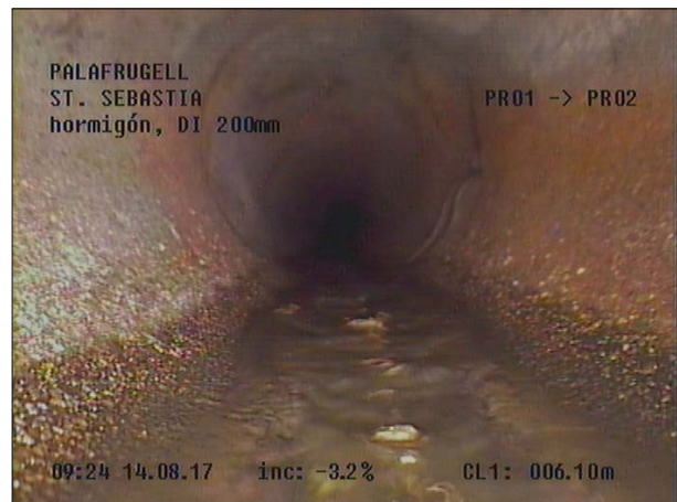
Fotografía: 7a, Nº Video: 115, 00:03:33 6,7m, Acometida desde 01 hasta 03 horas
