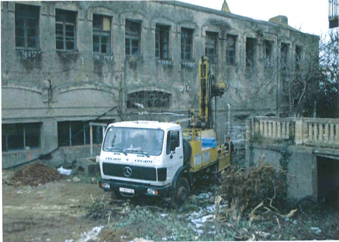
Realització d'un sondatge amb la penetrosonda TECOINSA TP-40 (17-12-2001). Estudi realitzat per la nova ubicació del Museu del Suro (Palafrugell).
