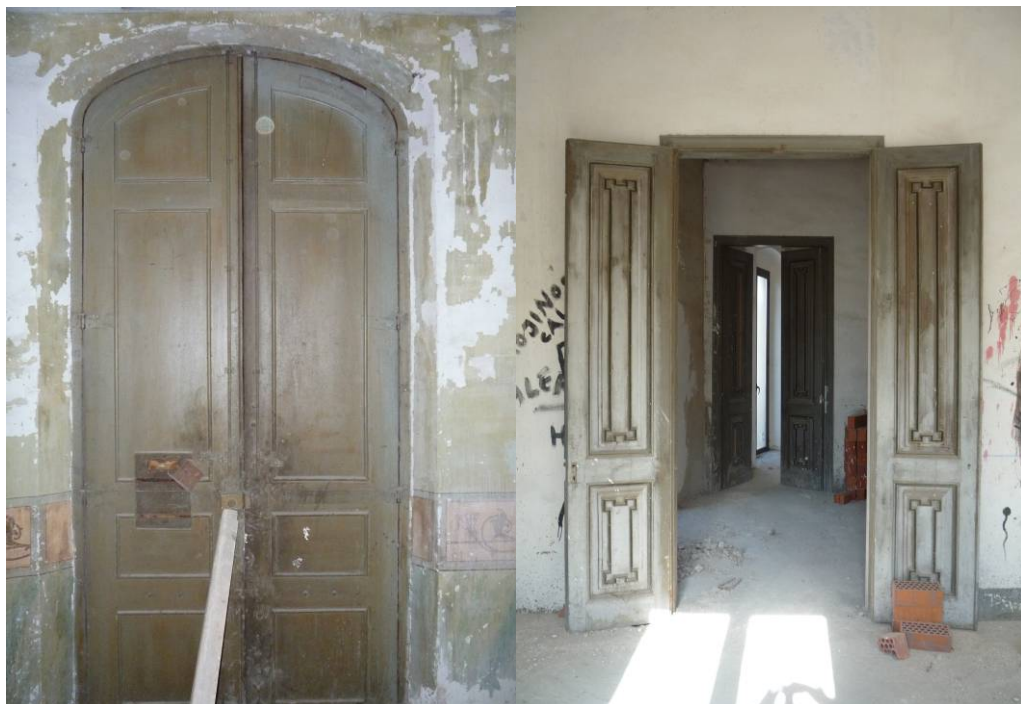
Puerta principal en planta baja vista desde el interior
