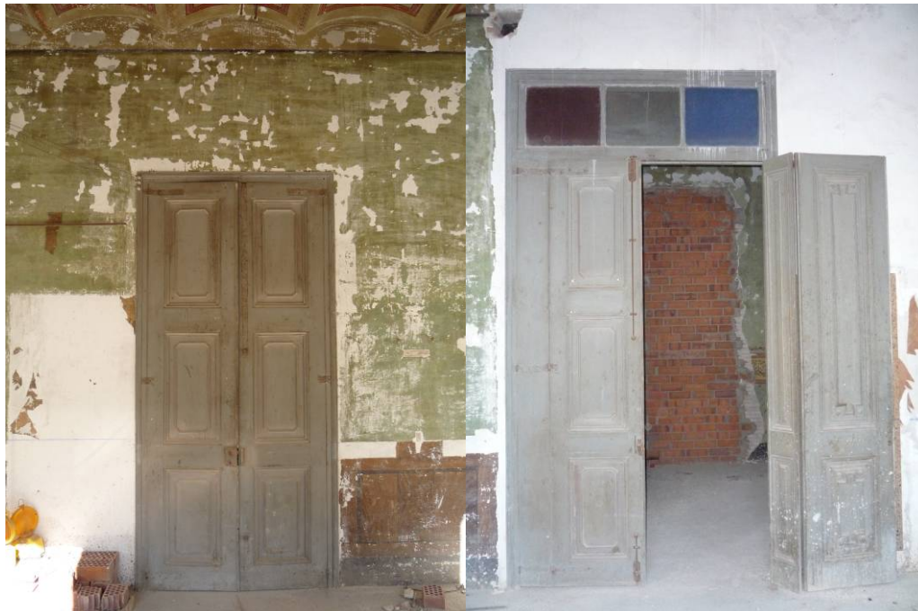
Puertas interiores existentes
