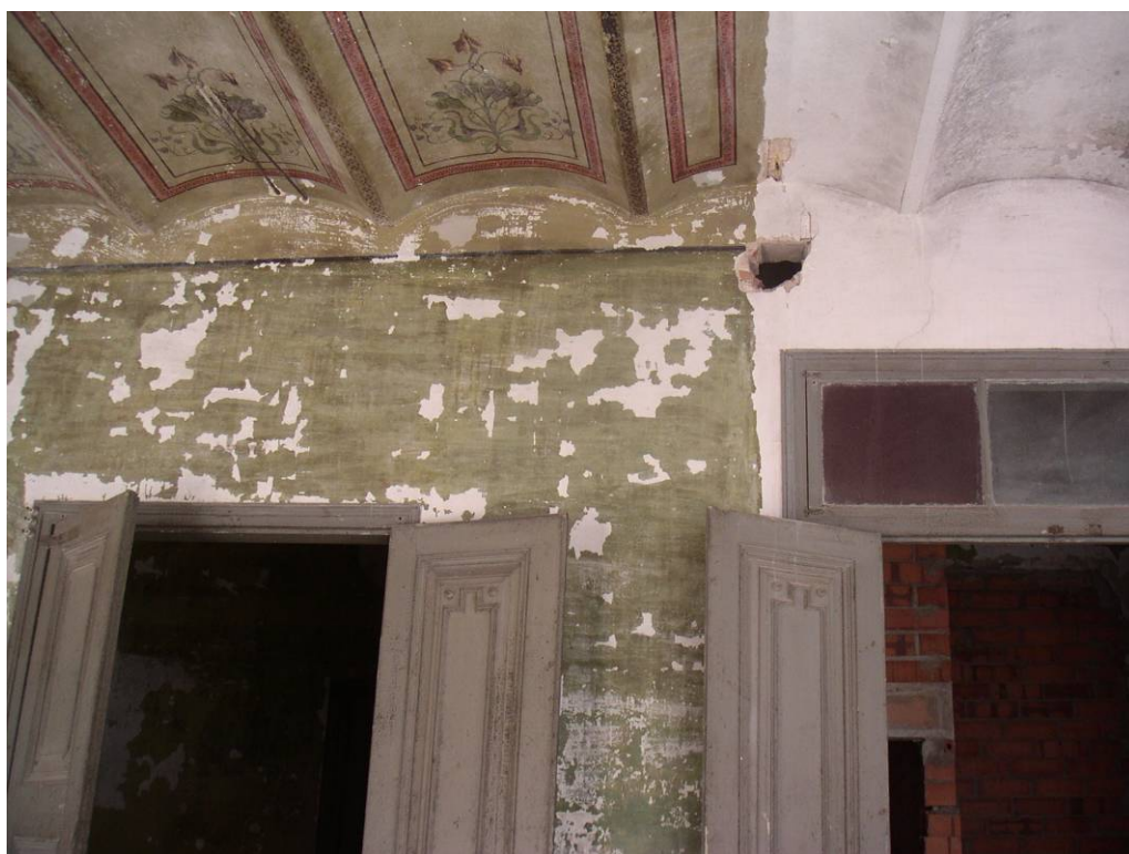
Detalle del techo con revoltones ornamentados
