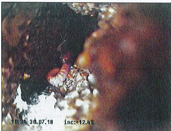
Fotografía: 2a, Nº Video: 0154, 00:00:20 0m, Roturas. Faltan trozos desde 04 hasta 06 horas, con el fondo visible POR LA PARTE EXTERIOR DE LA CONEXION
