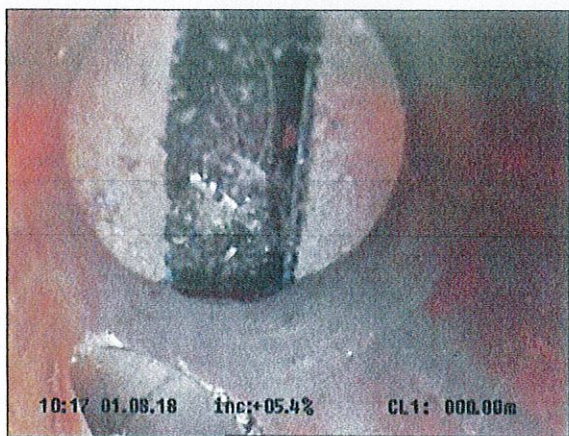
Fotografía: 1a, Nº Video: 0157, 00:00:17 0m, Inicio de la inspección
