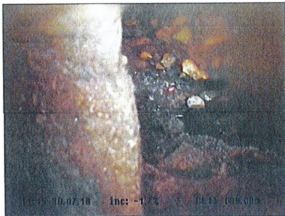
Fotografía: 14a, Nº Video: 0154, 00:18:14 84m, Inspección interrumpida POR RESALTO
