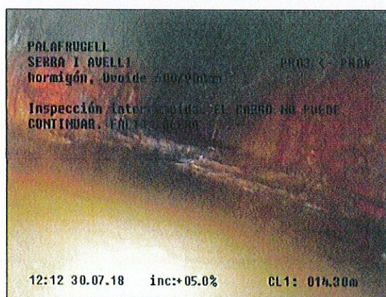
Fotografía: 18a, Nº Video: 0154, 00:02:52 14,3m, Fin de la inspección. LLEGADA
