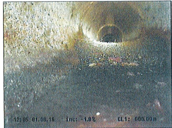
Fotografía: 18b, Nº Video: 0157, 00:00:08 0m, Inicio de la inspección
