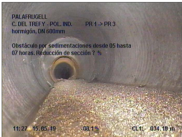
Fotografía: 9a, Nº Video: 070, 00:04:14 34,1m, Obstáculo por sedimentaciones desde 05 hasta 07 horas. Reducción de sección ? %
