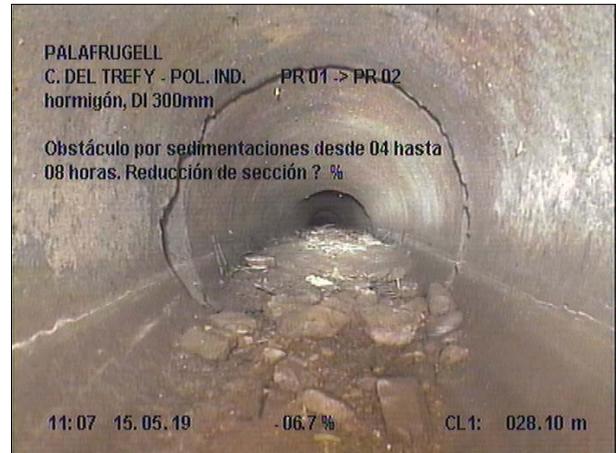
Fotografía: 4a, Nº Video: 070, 00:02:54 28,1m, Obstáculo por sedimentaciones desde 04 hasta 08 horas. Reducción de sección ? %
