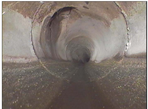
Fotografía: 36a, Nº Video: 070, 00:04:07 24,5m, Acometida desde 10 hasta 11 horas
