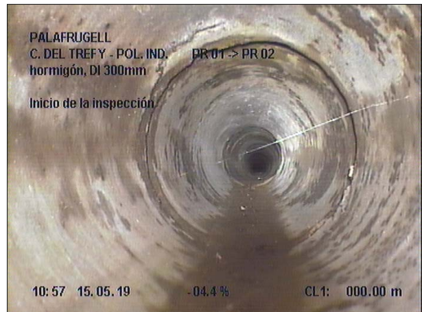
Fotografía: 1b, Nº Video: 070, 00:00:24 0m, Inicio de la inspección
