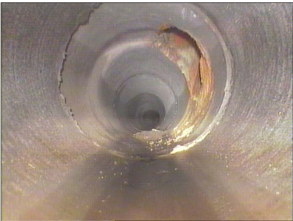
Fotografía: 11a, Nº Video: 070, 00:06:29 45,2m, Acometida desde 01 hasta 02 horas
