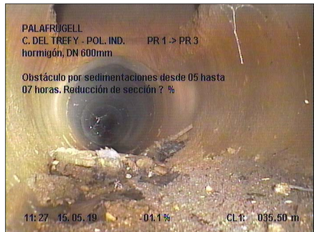
Fotografía: 9b, Nº Video: 070, 00:04:14 34,1m, Obstáculo por sedimentaciones desde 05 hasta 07 horas. Reducción de sección ? %
