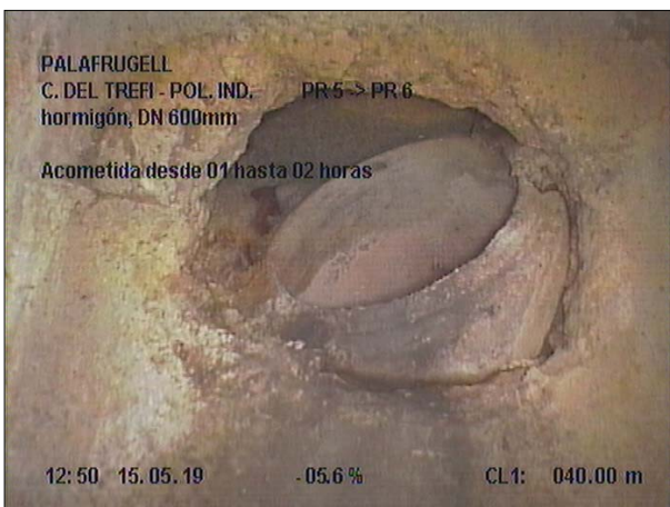
Fotografía: 39b, Nº Video: 070, 00:06:35 40m, Acometida desde 01 hasta 02 horas
