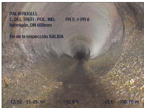
Fotografía: 42a, Nº Video: 070, 00:08:26 50,7m, Fin de la inspección SALIDA
