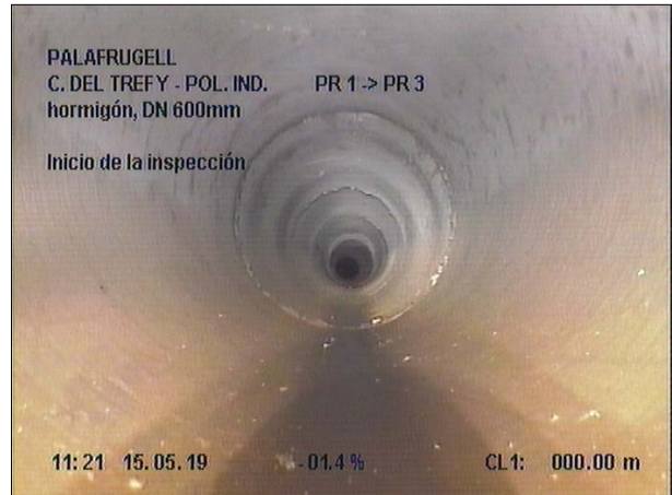
Fotografía: 6b, Nº Video: 070, 00:00:26 0m, Inicio de la inspección
