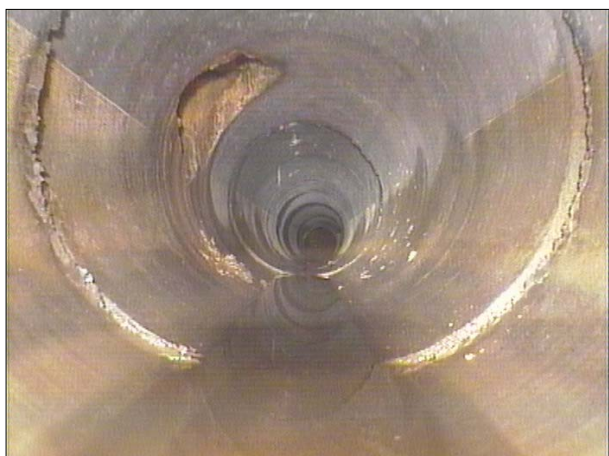
Fotografía: 15a, Nº Video: 070, 00:09:46 74,1m, Acometida desde 10 hasta 11 horas
