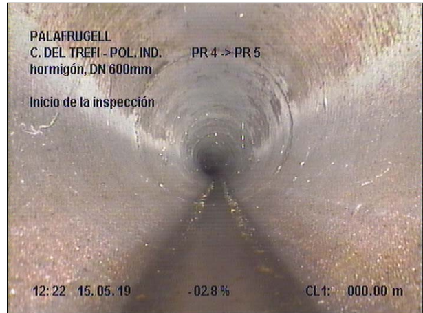
Fotografía: 26b, Nº Video: 070, 00:00:22 0m, Inicio de la inspección
