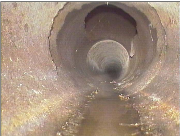
Fotografía: 24a, Nº Video: 070, 00:05:26 52,1m, Llegada al punto deseado
