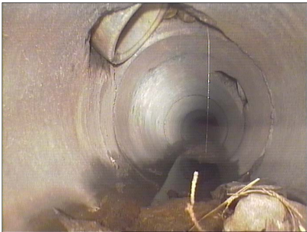
Fotografía: 13a, Nº Video: 070, 00:07:50 57,7m, Acometida desde 10 hasta 11 horas DE EMBORNAL
