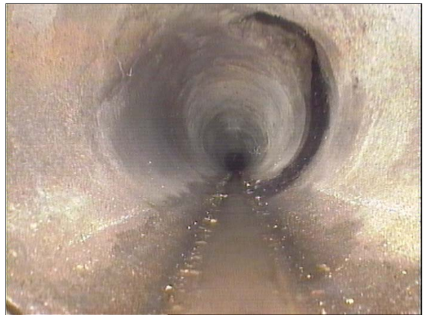
Fotografía: 30a, Nº Video: 070, 00:03:51 37,9m, Acometida desde 01 hasta 02 horas
