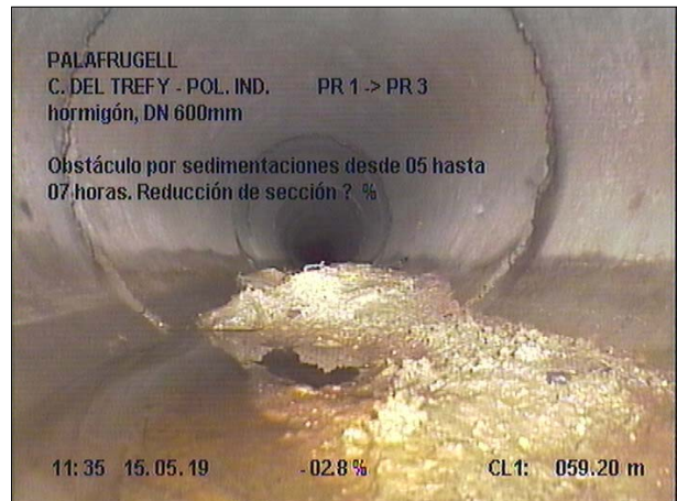
Fotografía: 12b, Nº Video: 070, 00:07:07 54,1m, Obstáculo por sedimentaciones desde 05 hasta 07 horas. Reducción de sección ? %
