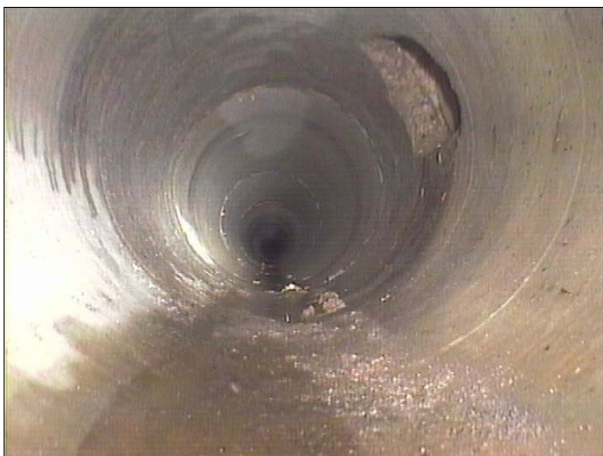
Fotografía: 7a, Nº Video: 070, 00:01:38 15,6m, Acometida desde 01 hasta 02 horas DE EMBORNAL
