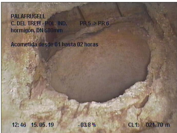
Fotografía: 35b, Nº Video: 070, 00:03:39 21,7m, Acometida desde 01 hasta 02 horas
