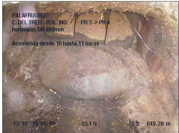
Fotografía: 23b, Nº Video: 070, 00:05:01 49,2m, Acometida desde 10 hasta 11 horas
