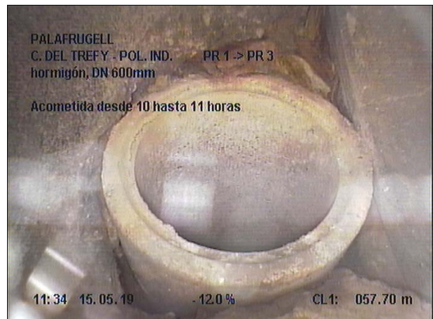
Fotografía: 13b, Nº Video: 070, 00:07:50 57,7m, Acometida desde 10 hasta 11 horas DE EMBORNAL
