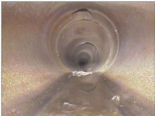
Fotografía: 21a, Nº Video: 070, 00:03:26 33m, Acometida desde 10 hasta 11 horas DE EMBORNAL
