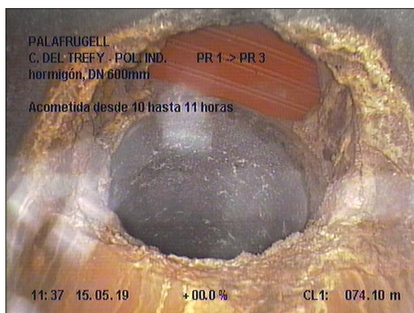
Fotografía: 15b, Nº Video: 070, 00:09:46 74,1m, Acometida desde 10 hasta 11 horas
