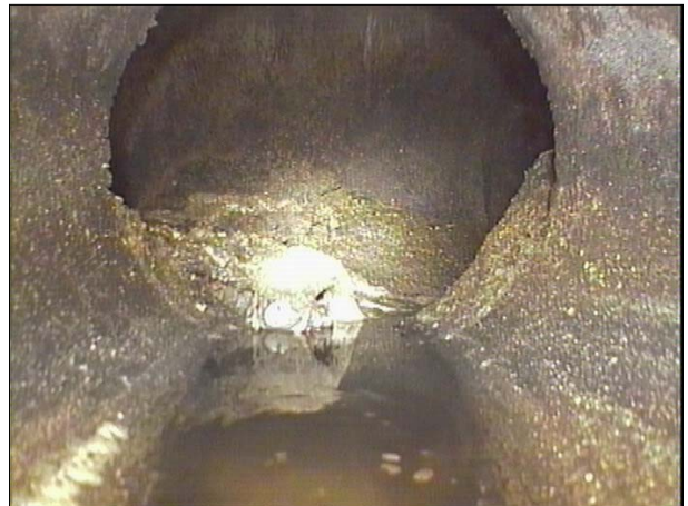
Fotografía: 48a, Nº Video: 070, 00:04:19 46,4m, Llegada al punto deseado
