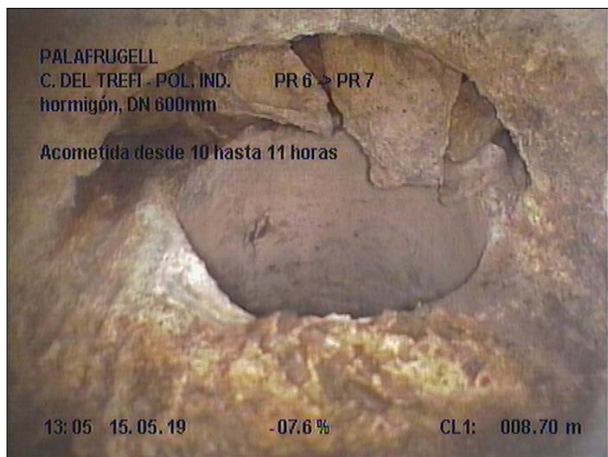
Fotografía: 45b, Nº Video: 070, 00:01:28 8,7m, Acometida desde 10 hasta 11 horas
