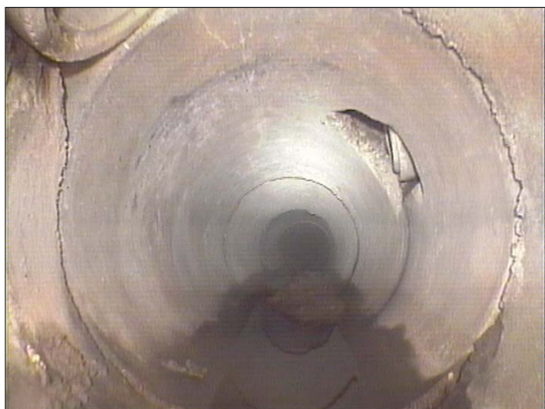
Fotografía: 14a, Nº Video: 070, 00:08:21 58,3m, Acometida desde 12 hasta 02 horas DE EMBORNAL
