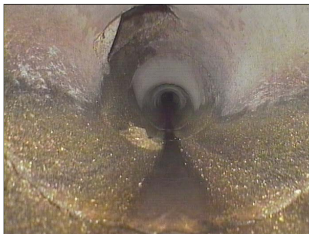
Fotografía: 46a, Nº Video: 070, 00:02:23 22m, Acometida desde 10 hasta 11 horas
