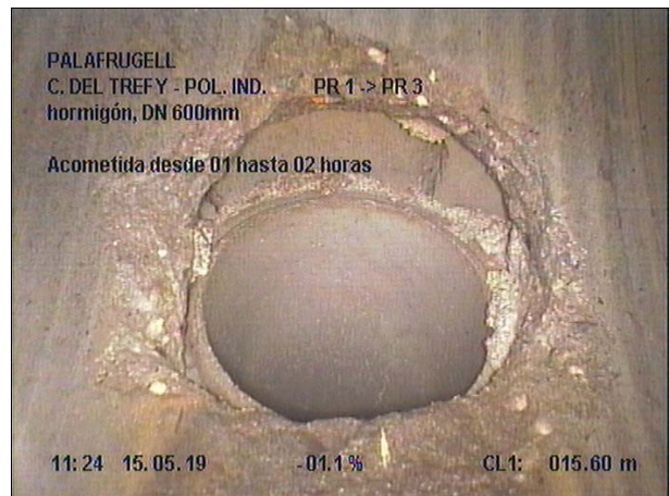
Fotografía: 7b, Nº Video: 070, 00:01:38 15,6m, Acometida desde 01 hasta 02 horas DE EMBORNAL
