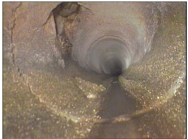
Fotografía: 45a, Nº Video: 070, 00:01:28 8,7m, Acometida desde 10 hasta 11 horas
