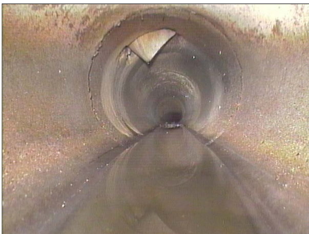
Fotografía: 20a, Nº Video: 070, 00:02:14 21,7m, Acometida desde 10 hasta 11 horas
