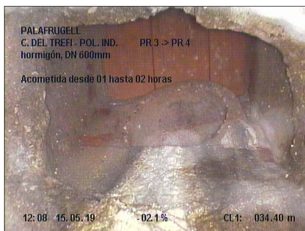
Fotografía: 22b, Nº Video: 070, 00:03:51 34,4m, Acometida desde 01 hasta 02 horas
