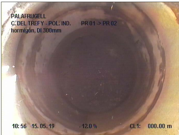
Fotografía: 1a, Nº Video: 070, 00:00:24 0m, Inicio de la inspección
