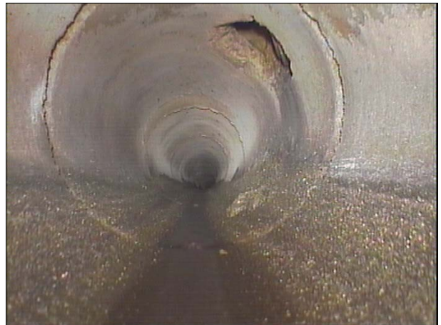
Fotografía: 39a, Nº Video: 070, 00:06:35 40m, Acometida desde 01 hasta 02 horas
