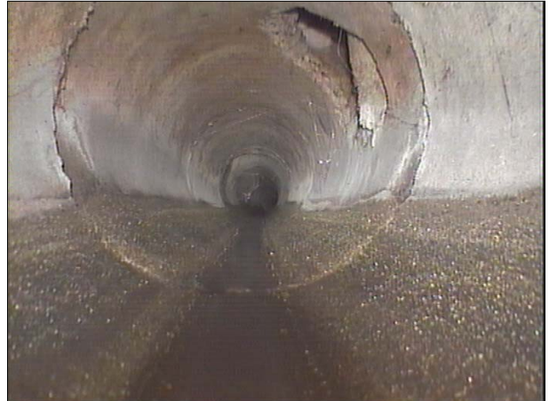
Fotografía: 35a, Nº Video: 070, 00:03:39 21,7m, Acometida desde 01 hasta 02 horas
