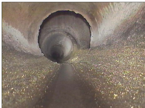
Fotografía: 41a, Nº Video: 070, 00:07:55 50,6m, Llegada al punto deseado
