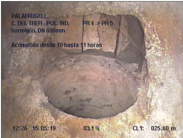
Fotografía: 28b, Nº Video: 070, 00:02:14 25,6m, Acometida desde 10 hasta 11 horas
