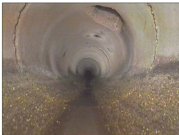
Fotografía: 47a, Nº Video: 070, 00:03:16 33,4m, Acometida desde 01 hasta 02 horas DE EMBORNAL
