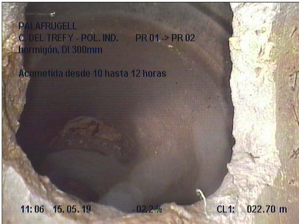
Fotografía: 3b, Nº Video: 070, 00:02:20 22,7m, Acometida desde 10 hasta 12 horas DE EMBORNAL
