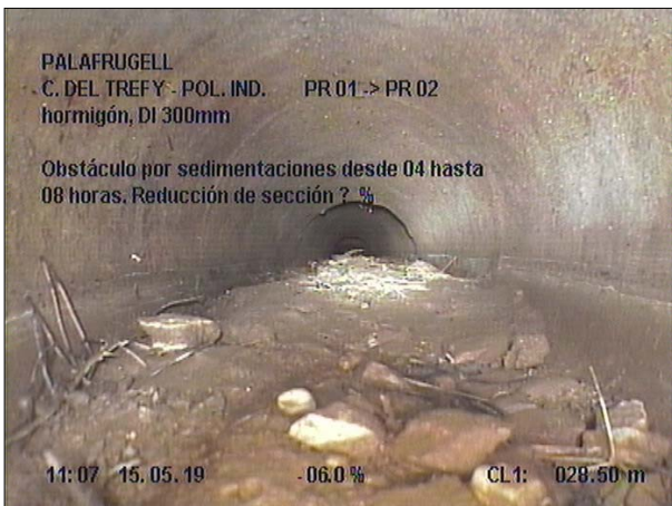
Fotografía: 4b, Nº Video: 070, 00:02:54 28,1m, Obstáculo por sedimentaciones desde 04 hasta 08 horas. Reducción de sección ? %
