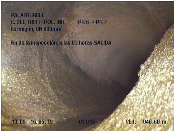
Fotografía: 50a, Nº Video: 070, 00:04:54 46,6m, Fin de la inspección, a las 03 horas SALIDA
