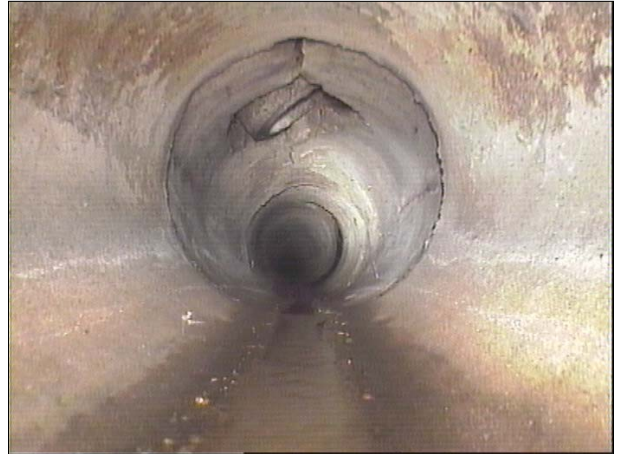
Fotografía: 29a, Nº Video: 070, 00:03:16 36,1m, Acometida con grietas desde 10 hasta 12 horas DE EMBORNAL
