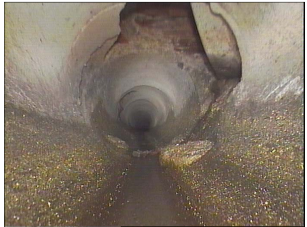
Fotografía: 44a, Nº Video: 070, 00:00:50 6,8m, Acometida desde 01 hasta 02 horas
