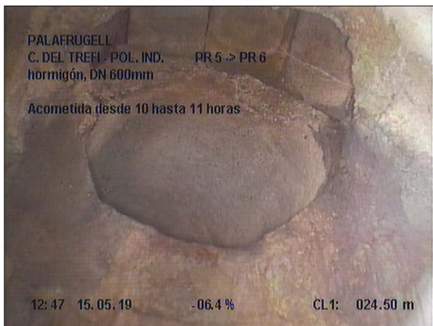
Fotografía: 36b, Nº Video: 070, 00:04:07 24,5m, Acometida desde 10 hasta 11 horas
