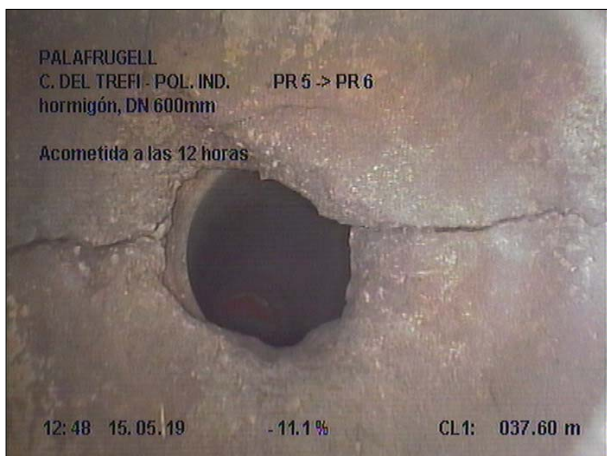
Fotografía: 37b, Nº Video: 070, 00:05:22 37,6m, Acometida a las 12 horas
