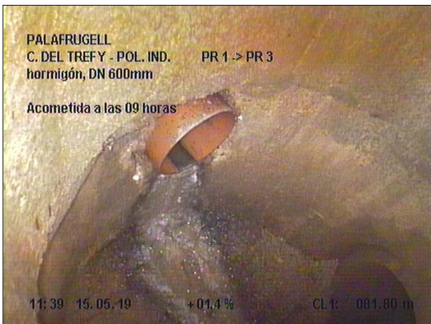
Fotografía: 17a, Nº Video: 070, 00:11:27 81,8m, Acometida a las 09 horas
