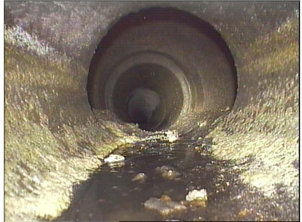
Fotografía: 31a, Nº Video: 070, 00:05:40 51,7m, Llegada al punto deseado
