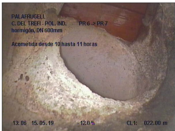
Fotografía: 46b, Nº Video: 070, 00:02:23 22m, Acometida desde 10 hasta 11 horas
