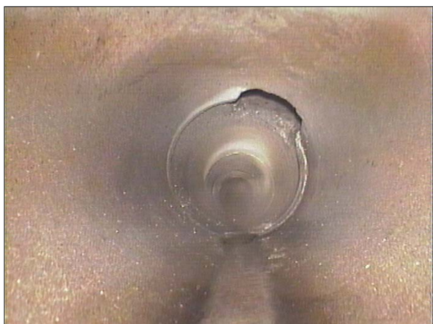
Fotografía: 22a, Nº Video: 070, 00:03:51 34,4m, Acometida desde 01 hasta 02 horas
