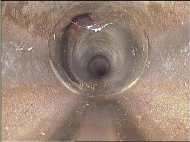
Fotografía: 23a, Nº Video: 070, 00:05:01 49,2m, Acometida desde 10 hasta 11 horas
