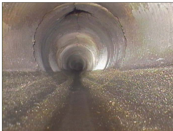
Fotografía: 37a, Nº Video: 070, 00:05:22 37,6m, Acometida a las 12 horas
