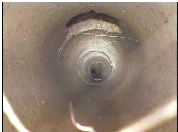
Fotografía: 3a, Nº Video: 070, 00:02:20 22,7m, Acometida desde 10 hasta 12 horas DE EMBORNAL
