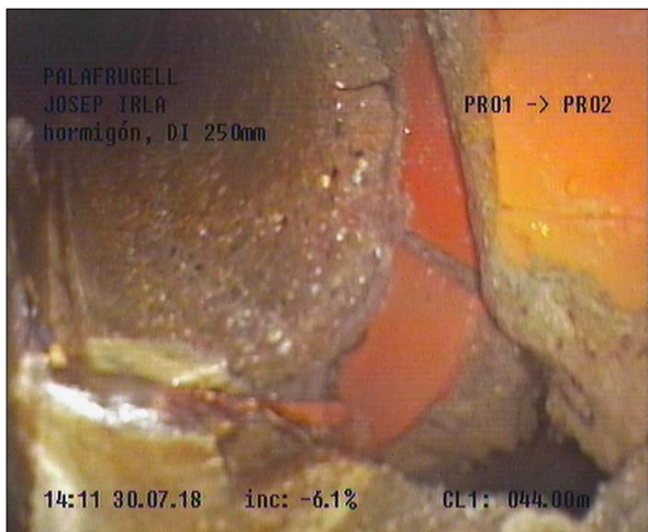
Fotografía: 6a, Nº Video: 0155, 00:19:43 44m, Acometida desde 01 hasta 03 horas
