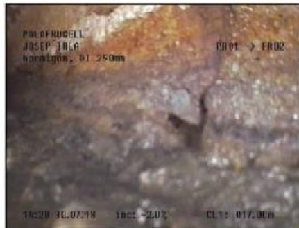
Fotografia: 16a, N° Video: 0155, 00:25:32 17m, Roturas. Falten trozos desde 04 hasta 05 horas, con el fondo visible
