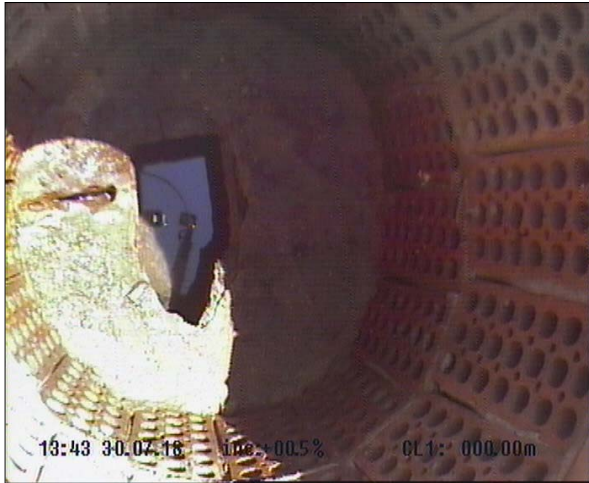
Fotografía: 1a, Nº Video: 0155, 00:00:11 0m, Inicio de la inspección
