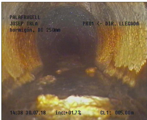
Fotografía: 31a, Nº Video: 0155, 00:01:59 5,4m, REPARACION DE 11 A 1 HORAS
