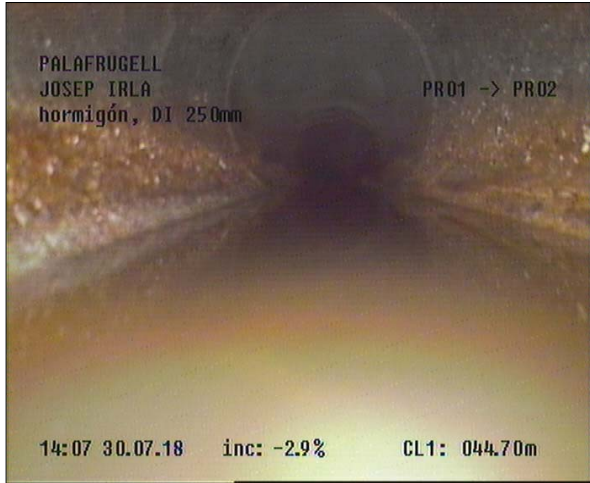
Fotografía: 4a, Nº Video: 0155, 00:16:50 44,7m, Inspección interrumpida. SALIDA
