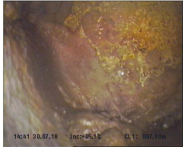
Fotografía: 35a, Nº Video: 0155, 00:03:43 7,9m, Inspección interrumpida FINAL DEL TUBO
