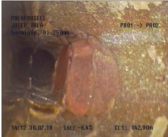
Fotografía: 7a, Nº Video: 0155, 00:20:10 42,9m, REPARACION DE 10 A 2 HORAS
