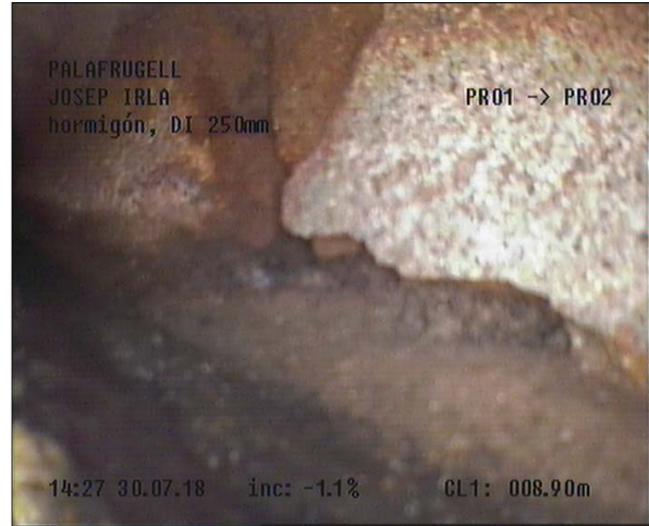
Fotografía: 24a, Nº Video: 0155, 00:29:41 8,9m, Roturas. Faltan trozos desde 03 hasta 06 horas, con el fondo visible
