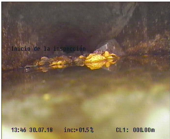
Fotografía: 2a, Nº Video: 0155, 00:00:18 0m, Retención de agua ? m, desde 05 hasta 07 horas
