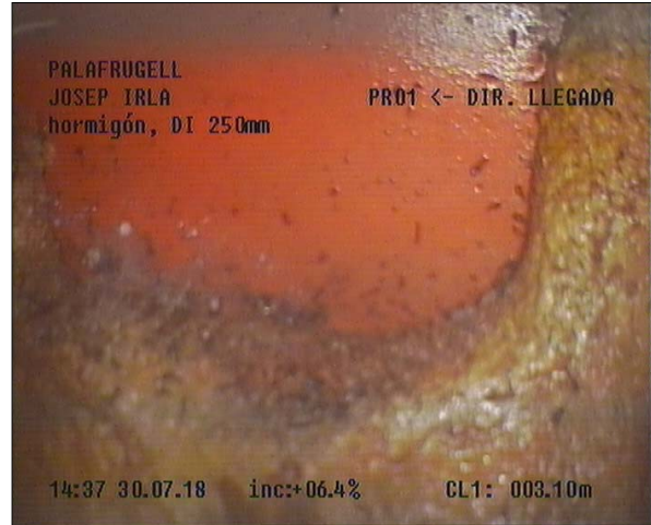
Fotografía: 30a, Nº Video: 0155, 00:01:43 3,1m, REPARACION DE 11 A 1 HORAS
