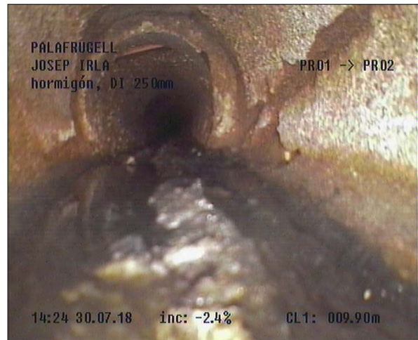
Fotografía: 21a, Nº Video: 0155, 00:28:27 9,9m, Desgaste mecánico desde 01 hasta 05 horas
