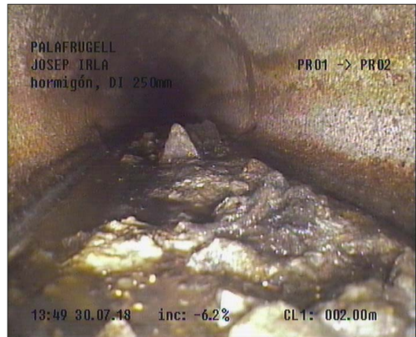
Fotografía: 3a, Nº Video: 0155, 00:02:26 2m, Obstáculo por sedimentaciones desde 05 hasta 07 horas. Reducción de sección ? %
