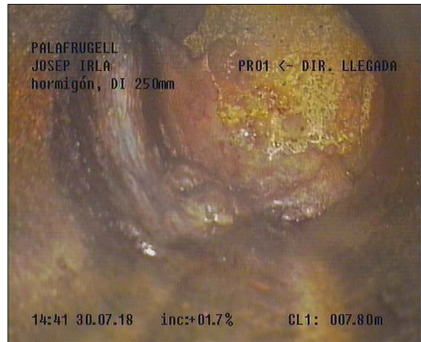
Fotografía: 34a, Nº Video: 0155, 00:03:31 7,9m, Acometida desde 09 hasta 11 horas
