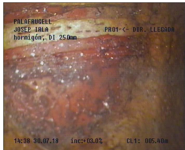
Fotografía: 31b, Nº Video: 0155, 00:01:59 5,4m, REPARACION DE 11 A 1 HORAS
