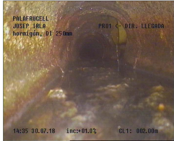
Fotografía: 27a, Nº Video: 0155, 00:00:17 2m, Obstáculo por sedimentaciones desde 05 hasta 07 horas. Reducción de sección ? %
