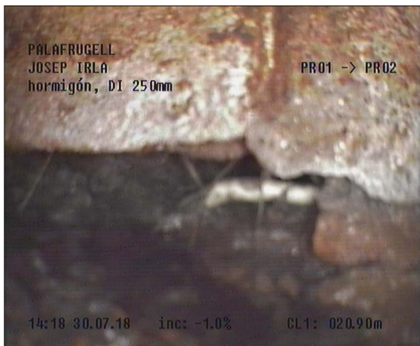
Fotografía: 14a, Nº Video: 0155, 00:24:12 20,9m, Roturas. Faltan trozos desde 04 hasta 05 horas, con el fondo visible CON RAICES
