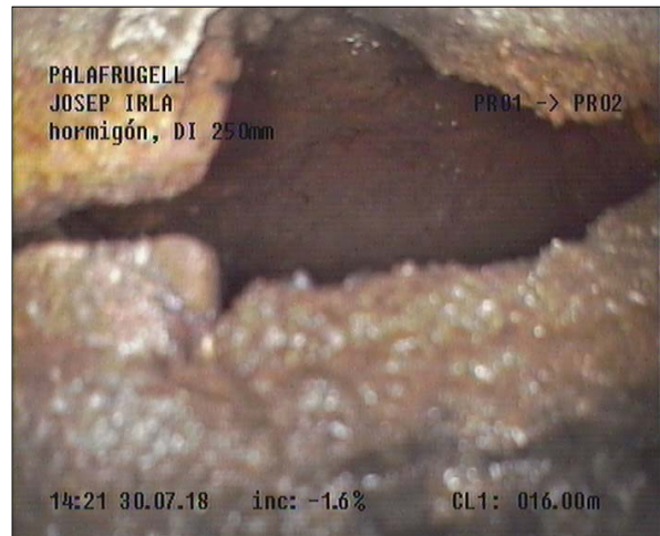
Fotografía: 17a, Nº Video: 0155, 00:26:00 16m, Derrumbamiento desde 07 hasta 08 horas, con humedad visible
