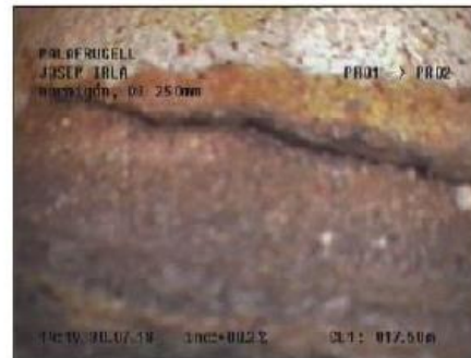
Fotografia: 15a, N° Video: 0155, 00:24:47 17.6m, Derrumbamiento desde 04 hasta 05 horas, con el fondo visible
