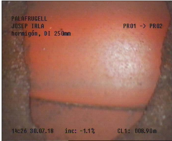
Fotografía: 23a, Nº Video: 0155, 00:29:27 8,9m, REPARACION DE 11 A 1 HORAS
