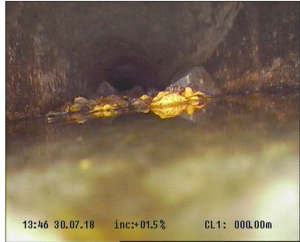
Fotografía: 1b, Nº Video: 0155, 00:00:11 0m, Inicio de la inspección
