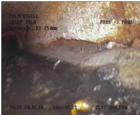
Fotografía: 22a, Nº Video: 0155, 00:28:53 9,3m, Roturas. Faltan trozos desde 04 hasta 05 horas, con el fondo visible
