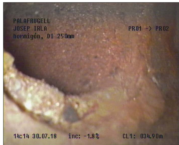
Fotografía: 9a, Nº Video: 0155, 00:21:36 34,9m, Acometida desde 09 hasta 11 horas
