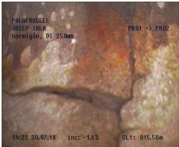
Fotografía: 18a, Nº Video: 0155, 00:26:36 15,5m, Grieta longitudinal desde 02 hasta 03 horas. Anchura ? cm
