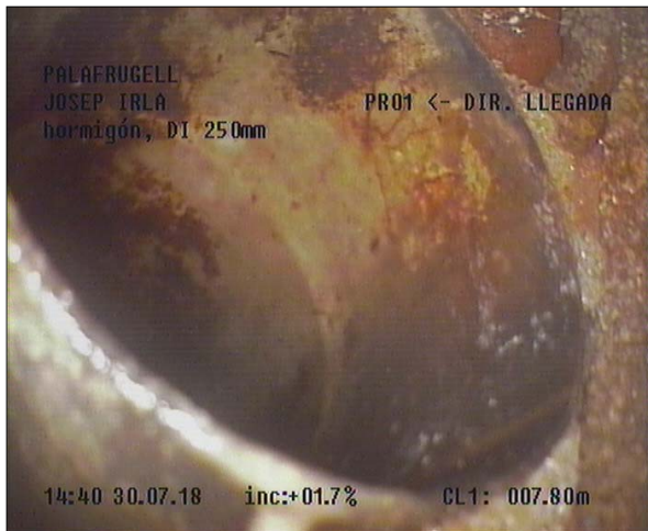
Fotografía: 33b, Nº Video: 0155, 00:03:04 7,8m, Acometida desde 12 hasta 02 horas
