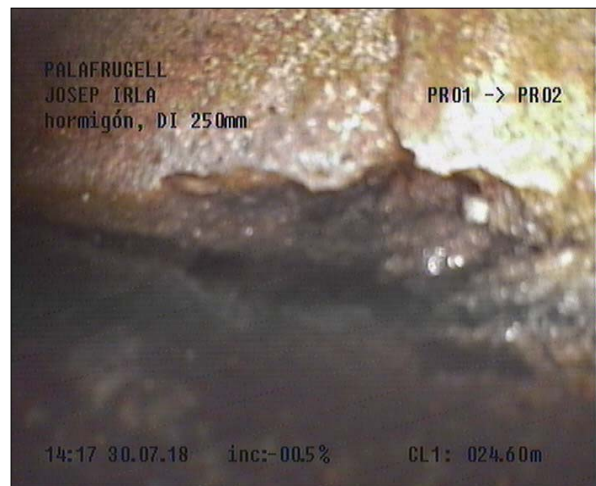
Fotografía: 13a, Nº Video: 0155, 00:23:39 24,6m, Roturas. Faltan trozos desde 04 hasta 05 horas, con el fondo visible
