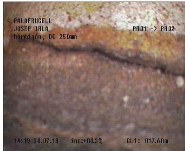
Fotografía: 15a, Nº Video: 0155, 00:24:47 17,6m, Derrumbamiento desde 04 hasta 05 horas, con el fondo visible
