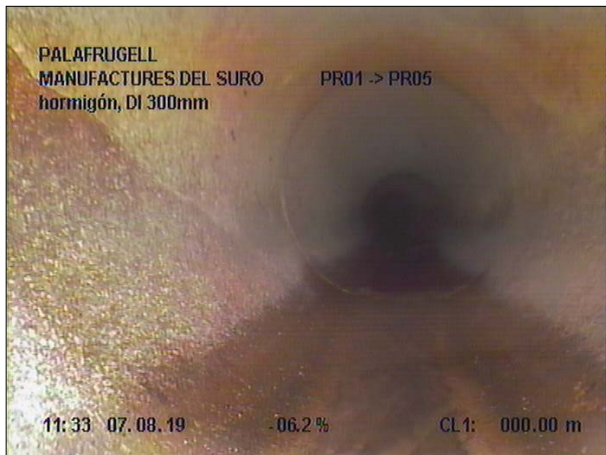
Fotografía: 27a, Nº Video: 139 0m, Inicio de la inspección
