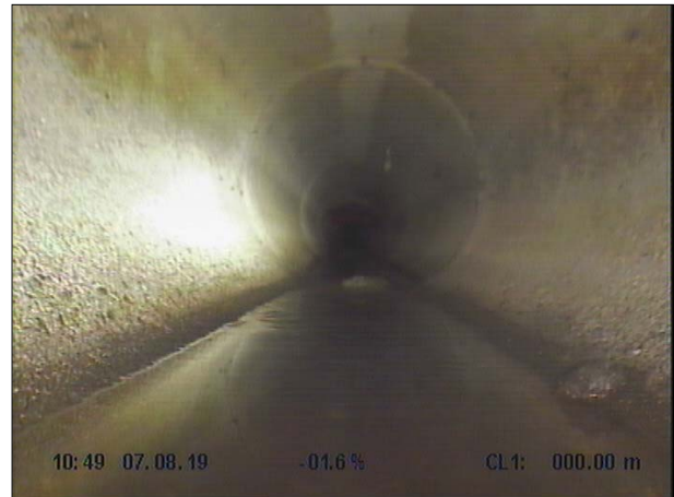
Fotografía: 1b, Nº Video: 139, 00:00:08 0m, Inicio de la inspección
