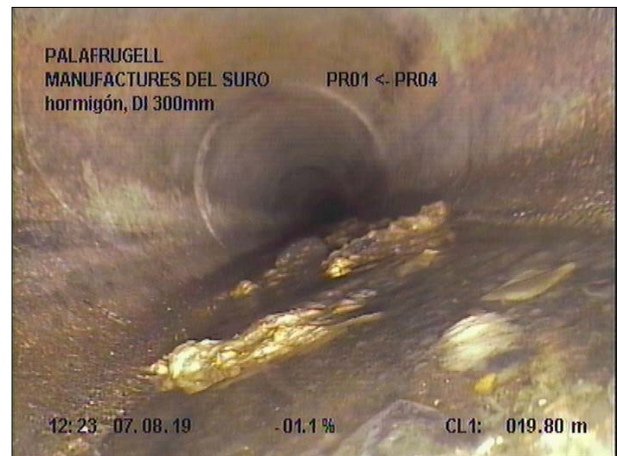
Fotografía: 46a, Nº Video: 139, 00:04:52 19,8m, Obstáculo por sedimentaciones desde 05 hasta 07 horas. Reducción de sección ? %
