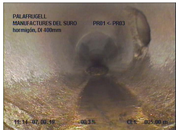
Fotografía: 16a, Nº Video: 139, 00:01:34 5,7m, Acometida desde 01 hasta 03 horas
