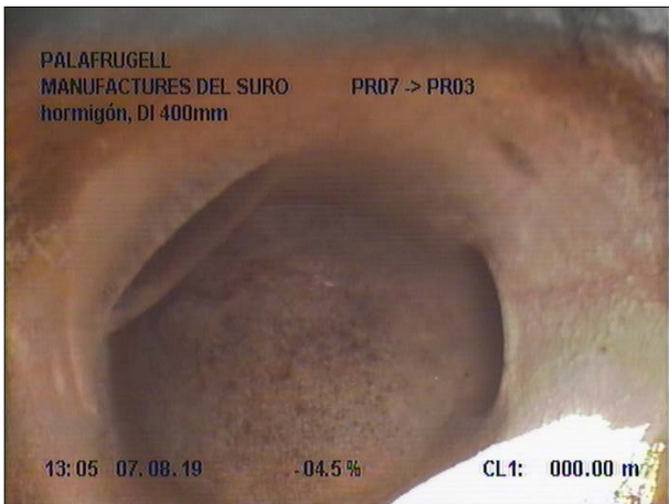
Fotografía: 52a, Nº Video: 139, 00:00:06 0m, Inicio de la inspección
