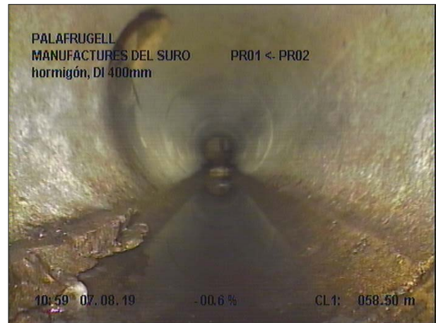
Fotografía: 8a, Nº Video: 139, 00:07:59 59,3m, Acometida desde 09 hasta 11 horas
