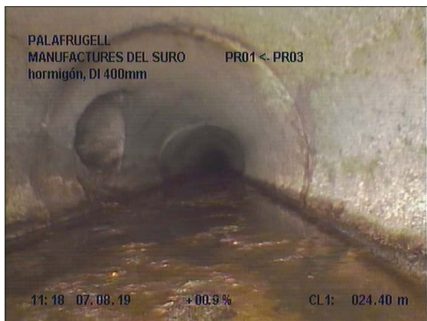
Fotografía: 20a, Nº Video: 139, 00:04:01 25,1m, Acometida desde 09 hasta 11 horas
