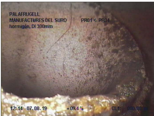
Fotografía: 43b, Nº Video: 139, 00:00:04 1,2m, Acometida sobresaliente desde 01 hasta 03 horas, (sobresale ? cm)
