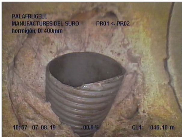
Fotografía: 7b, Nº Video: 139, 00:06:14 46,1m, Acometida desde 09 hasta 11 horas
