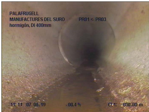
Fotografía: 14a, Nº Video: 139 0m, Inicio de la inspección
