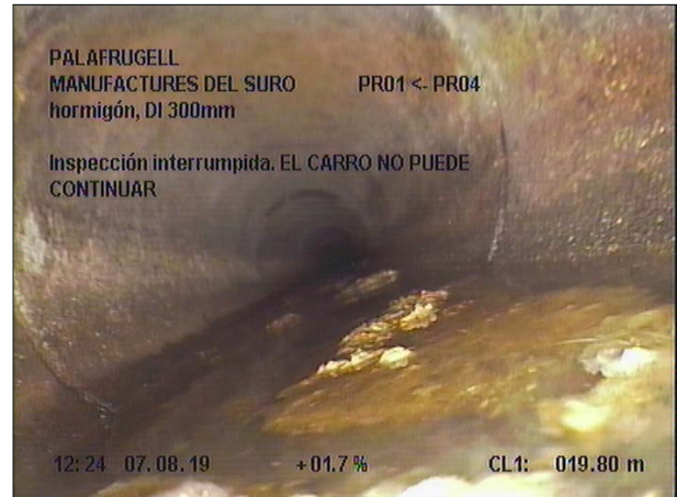
Fotografía: 48a, Nº Video: 139, 00:05:15 19,8m, Fin de la inspección. LLEGADA
