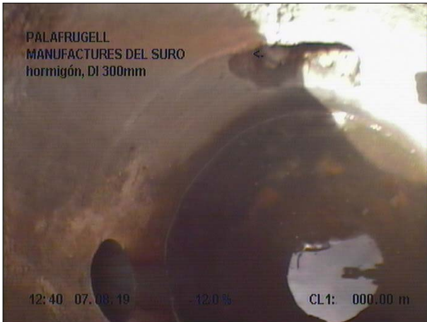
Fotografía: 49a, Nº Video: 139, 00:00:11 0m, Inicio de la inspección
