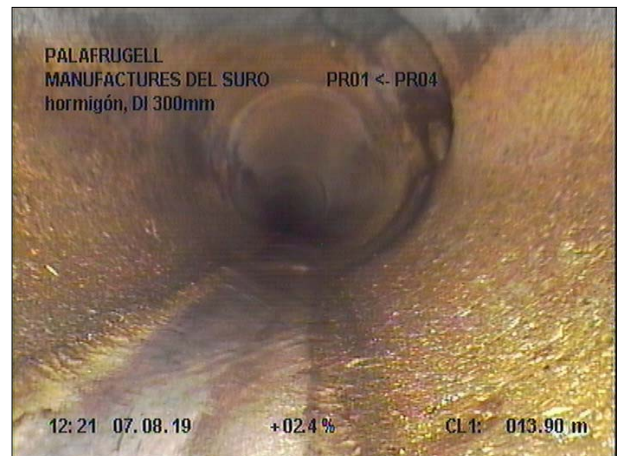
Fotografía: 44a, Nº Video: 139, 00:03:52 14,3m, Acometida desde 01 hasta 03 horas
