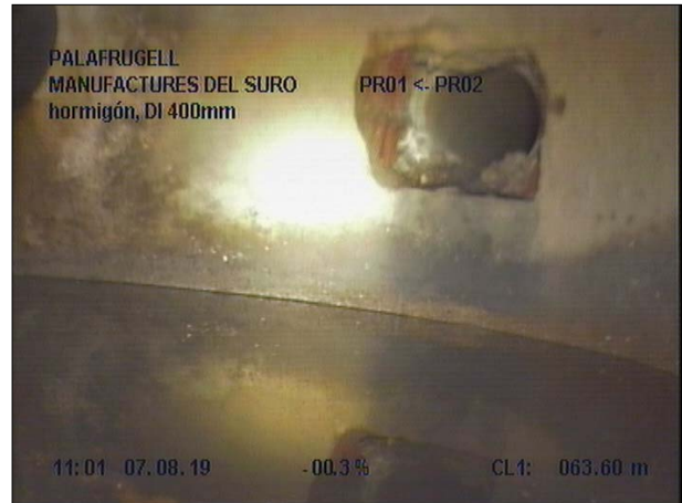
Fotografía: 10a, Nº Video: 139, 00:09:02 63,6m, Acometida desde 01 hasta 02 horas
