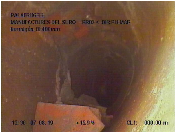
Fotografía: 64a, Nº Video: 139 0m, Inicio de la inspección
