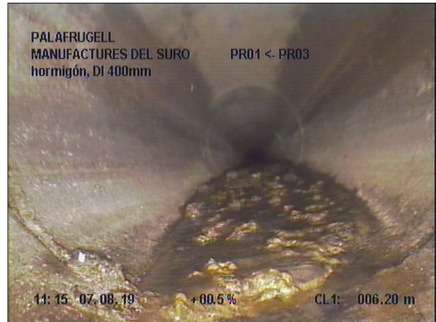
Fotografía: 17a, Nº Video: 139, 00:01:50 6,2m, Obstáculo por sedimentaciones desde 05 hasta 07 horas. Reducción de sección ? %
