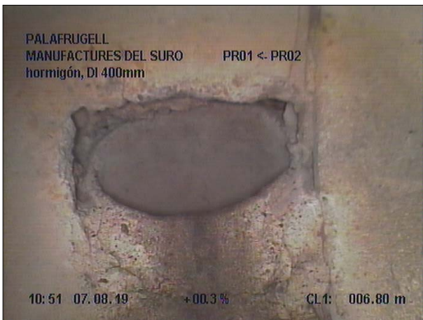
Fotografía: 4a, Nº Video: 139, 00:01:39 6,8m, Acometida desde 09 hasta 11 horas
