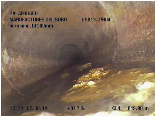
Fotografía: 47a, Nº Video: 139, 00:05:08 19,8m, Inspección interrumpida. EL CARRO NO PUEDE CONTINUAR
