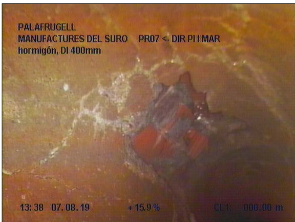
Fotografía: 66a, Nº Video: 139, 00:00:39 0m, Inspección interrumpida. EL CARRO NO PUEDE CONTINUAR
