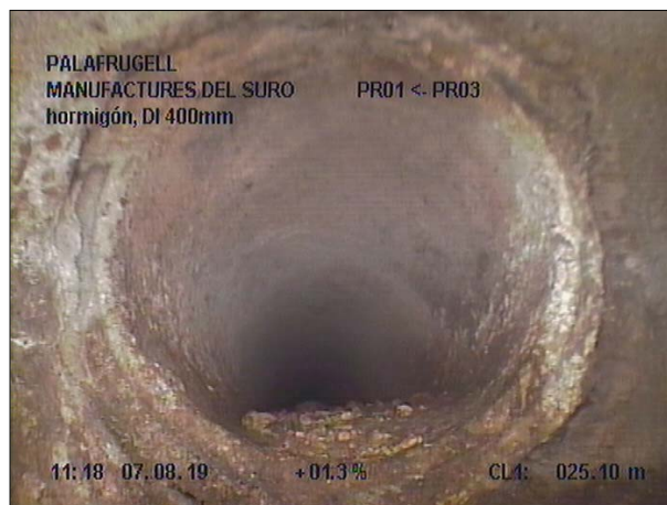
Fotografía: 20b, Nº Video: 139, 00:04:01 25,1m, Acometida desde 09 hasta 11 horas
