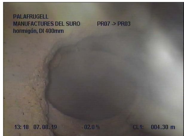
Fotografía: 53b, Nº Video: 139, 00:01:15 4,3m, Acometida desde 01 hasta 02 horas
