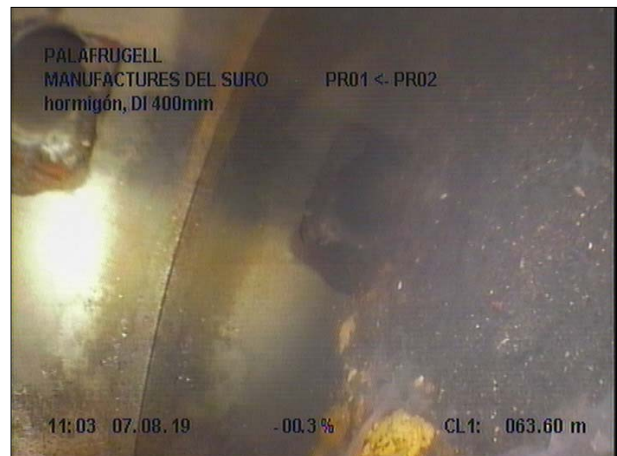
Fotografía: 13a, Nº Video: 139, 00:12:02 63,6m, Fin de la inspección
