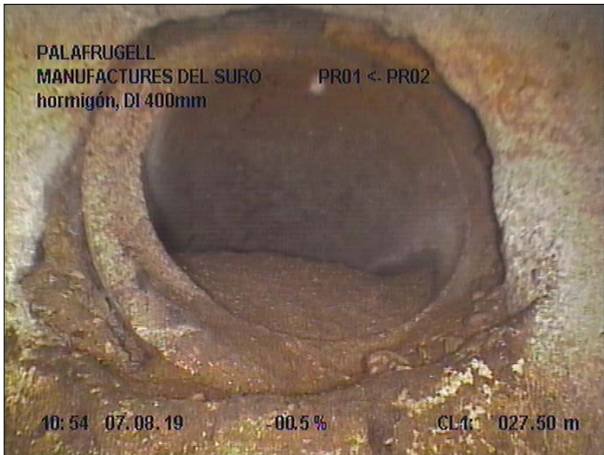
Fotografía: 5b, Nº Video: 139, 00:03:54 27,5m, Acometida desde 01 hasta 03 horas
