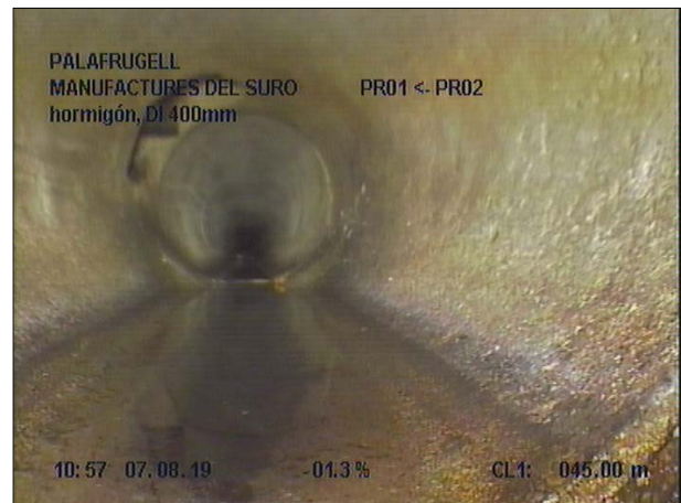
Fotografía: 7a, Nº Video: 139, 00:06:14 46,1m, Acometida desde 09 hasta 11 horas
