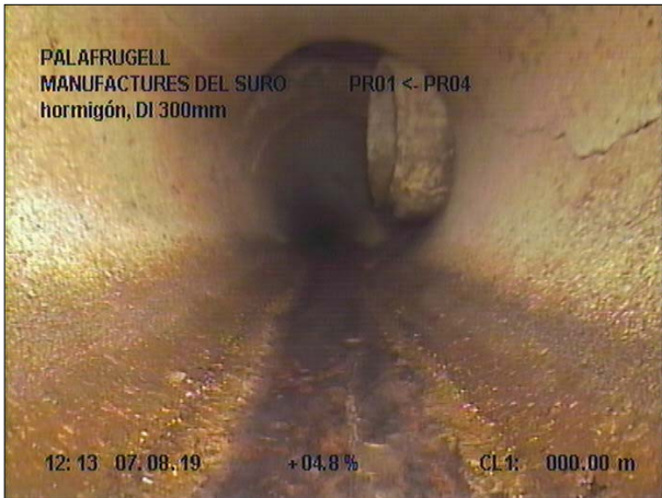
Fotografía: 42a, Nº Video: 139 0m, Inicio de la inspección
