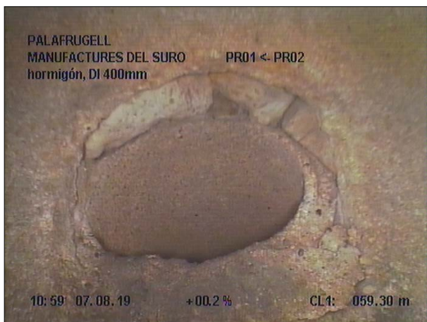
Fotografía: 8b, Nº Video: 139, 00:07:59 59,3m, Acometida desde 09 hasta 11 horas
