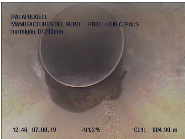
Fotografía: 50a, Nº Video: 139, 00:01:12 4,9m, Cambio del material. Nuevo material (material) PVC 160MM
