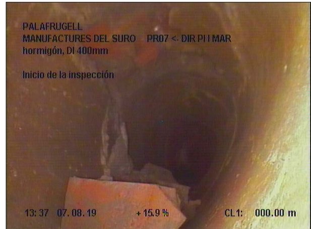
Fotografía: 65a, Nº Video: 139 0m, Obstáculo por sedimentaciones desde 05 hasta 07 horas. Reducción de sección ? %
