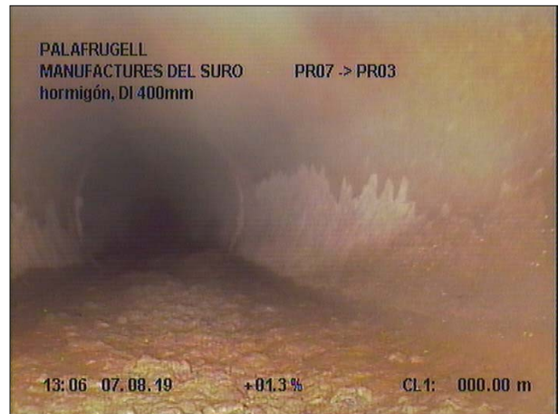
Fotografía: 52b, Nº Video: 139, 00:00:06 0m, Inicio de la inspección
