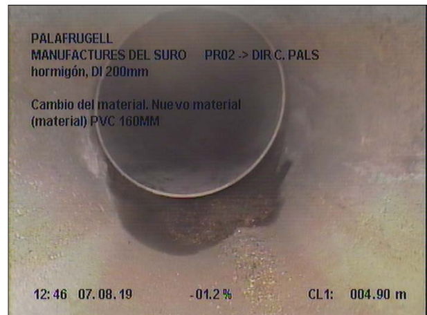
Fotografía: 51a, Nº Video: 139, 00:01:21 4,9m, Inspección interrumpida
