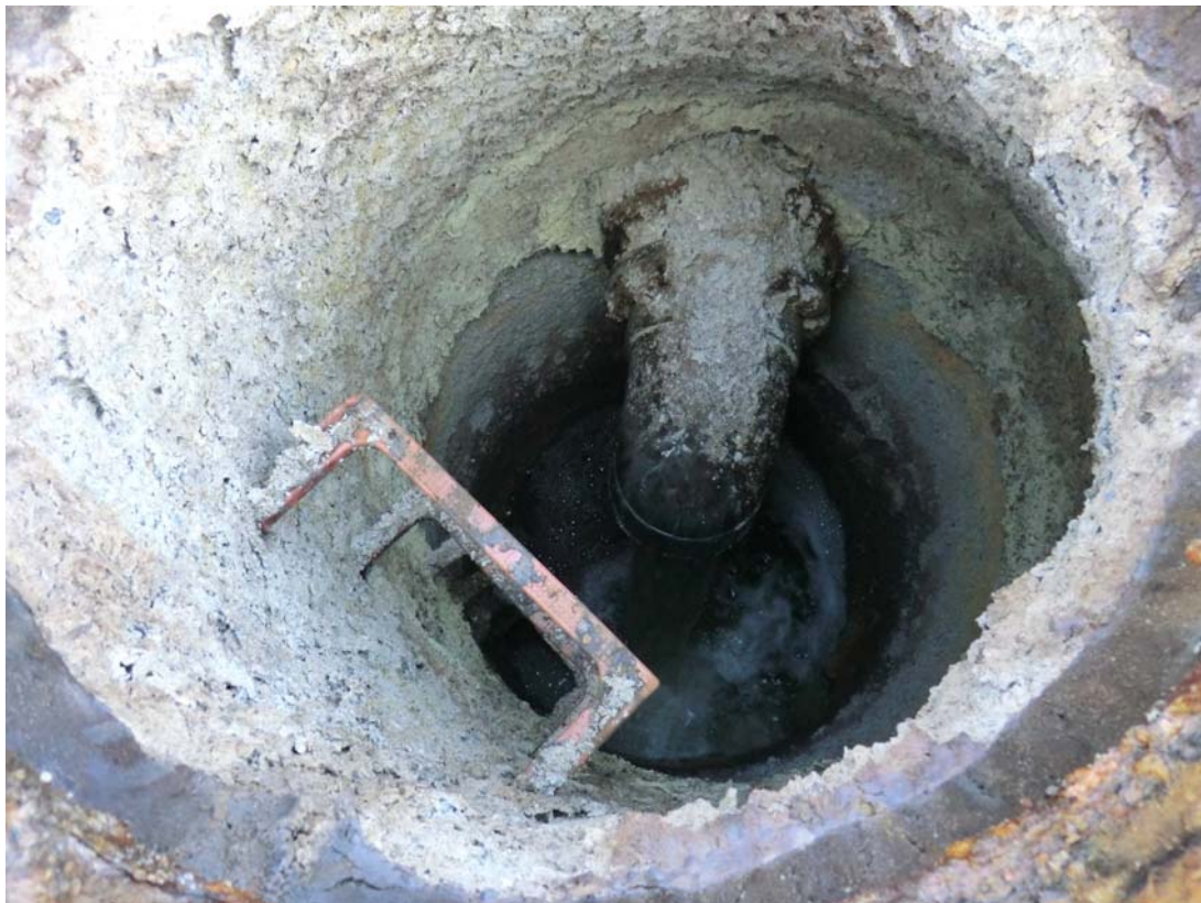
Arxiu: Arqueta Trencament Càrrega (1).JPG
