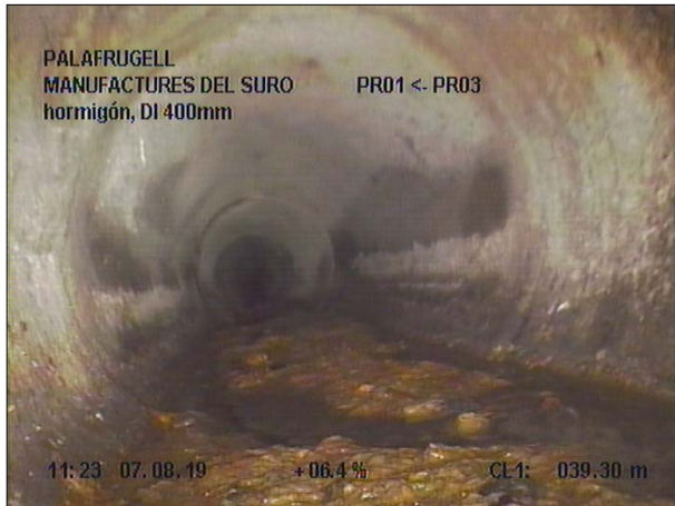
Fotografía: 23a, Nº Video: 139, 00:08:20 39,3m, Fin de la inspección. LLEGADA
