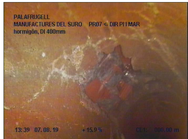
Fotografía: 67a, Nº Video: 139, 00:01:12 0m, REPARACION Y GRIETAS, desde 08 hasta 12 horas
