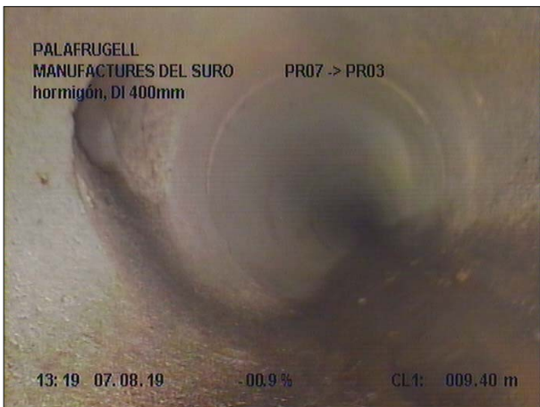
Fotografía: 55a, Nº Video: 139, 00:02:14 10m, Acometida desde 10 hasta 11 horas
