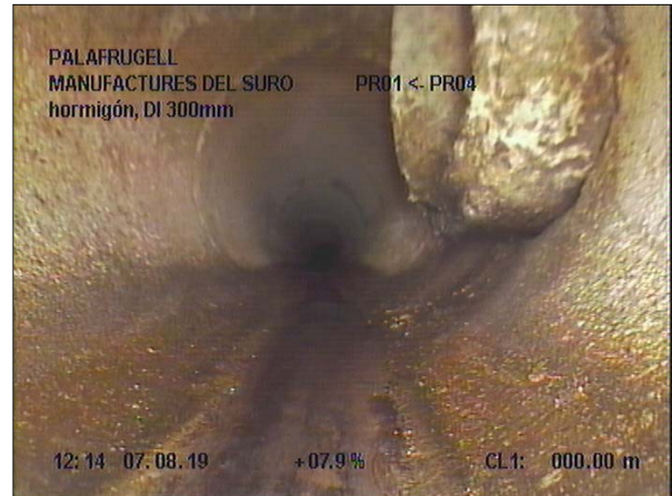
Fotografía: 43a, Nº Video: 139, 00:00:04 1,2m, Acometida sobresaliente desde 01 hasta 03 horas, (sobresale ? cm)
