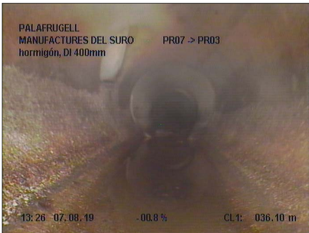
Fotografía: 60a, Nº Video: 139, 00:07:06 37m, Acometida desde 10 hasta 11 horas
