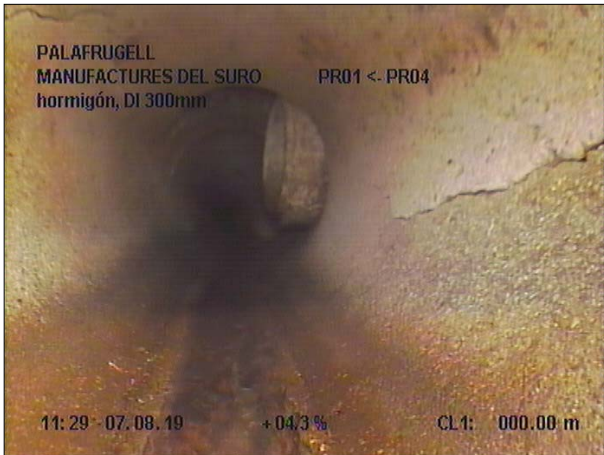
Fotografía: 24a, Nº Video: 139 0m, Inicio de la inspección
