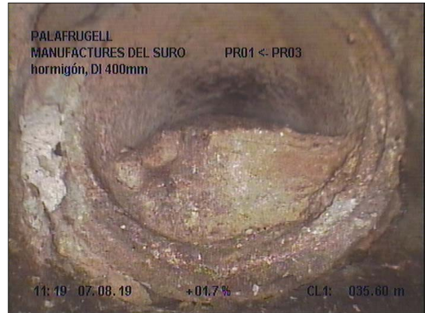
Fotografía: 21b, Nº Video: 139, 00:04:59 35,6m, Acometida desde 09 hasta 11 horas
