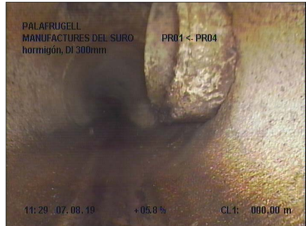
Fotografía: 25a, Nº Video: 139, 00:00:56 1,2m, Acometida sobresaliente desde 01 hasta 03 horas, (sobresale ? cm)
