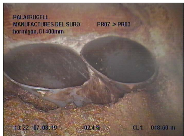
Fotografía: 57b, Nº Video: 139, 00:03:48 18,6m, Acometida DOBLE desde 12 hasta 02 horas
