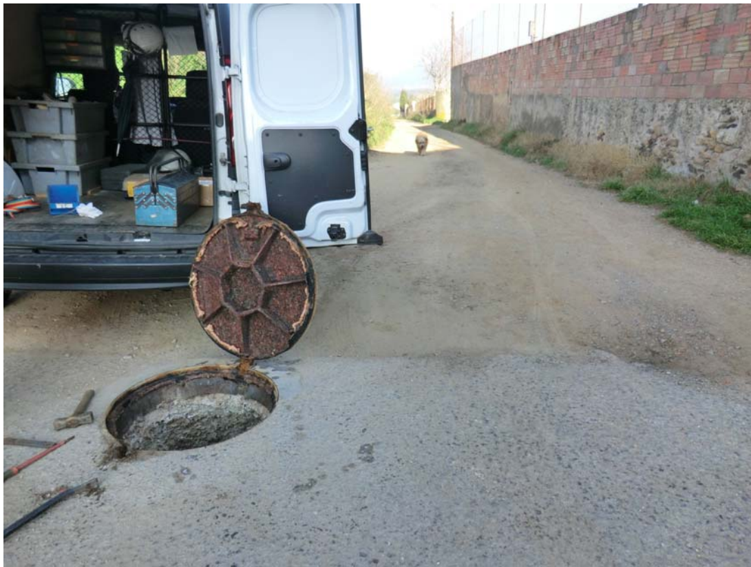
Arxiu: Arqueta Trencament Càrrega (3).JPG
