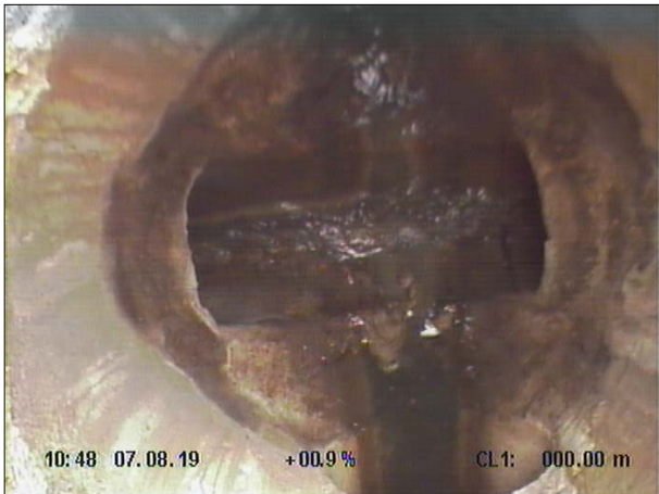
Fotografía: 1a, Nº Video: 139, 00:00:08 0m, Inicio de la inspección
