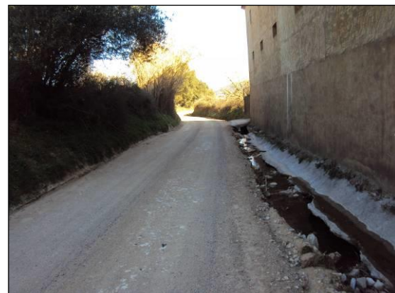
Vista de la cuneta al límit amb el camí
