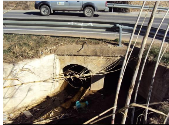
Vista de l'obra de fàbrica des d'aigua amunt
