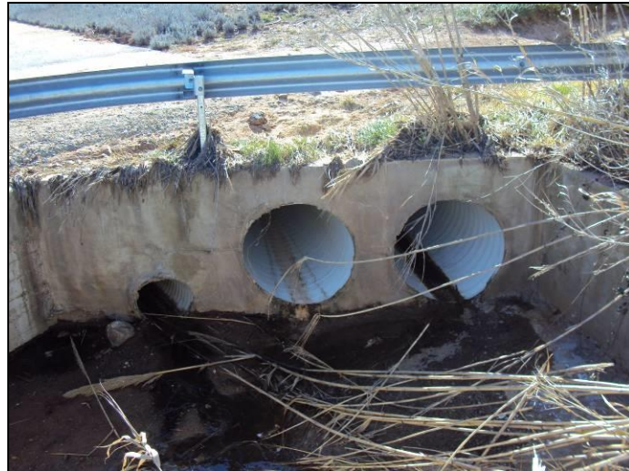
Sortida del col·lector interceptor a la cuneta de drenatge
