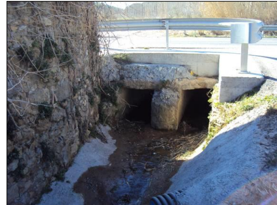
Vista de l'obra de fàbrica des d'aigua avall
