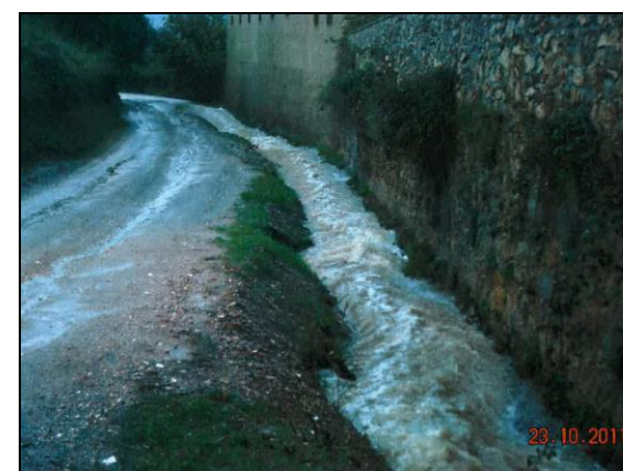
Flux d'aigua circulant per la cuneta de drenatge i camí rural en episodis de pluja
