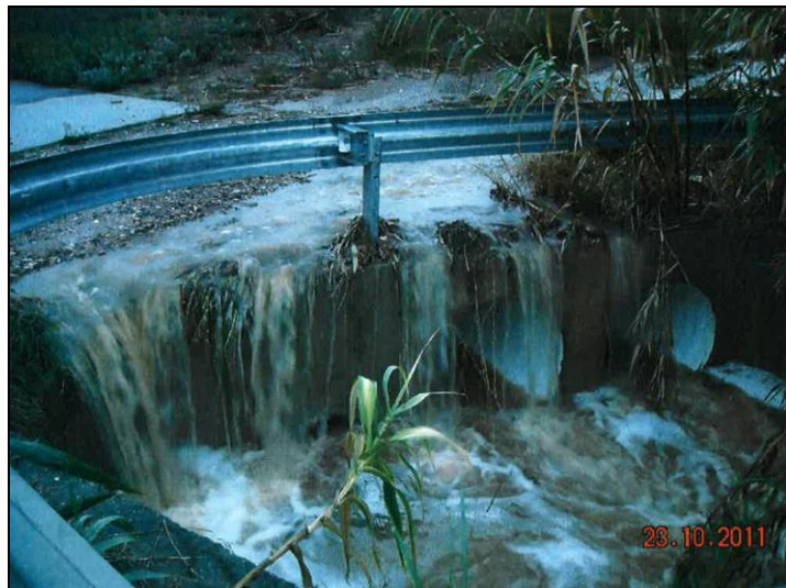
Vessament del flux d'aigua circulant pel camí a l'obra de fàbrica de la Cuneta de drenatge (ctra. C-31)
