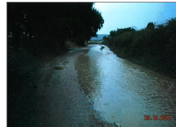
Flux d'aigua circulant per la cuneta de drenatge i camí rural en episodis de pluja
