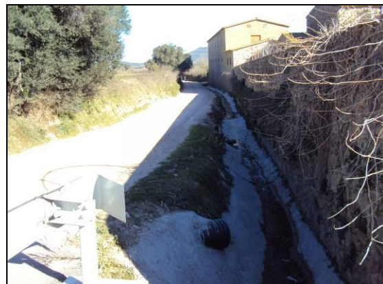
Vista de la cuneta de drenatge aigua amunt C-31
