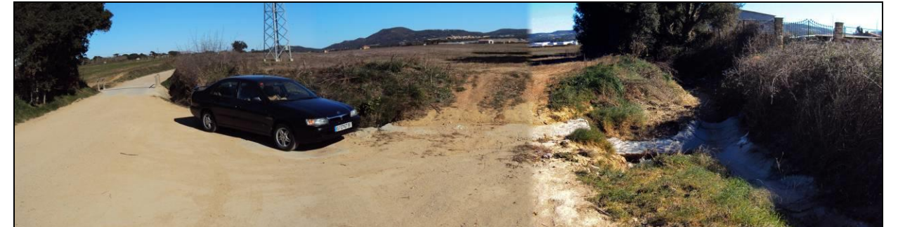
Zona de confluència entre la riera de Ca l'Abellí i la cuneta de drenatge
