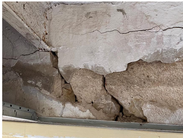
Il·lustració 14.- esquerda a l'obra de fàbrica
