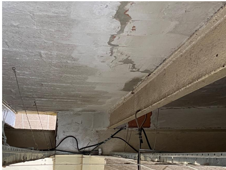
Il·lustració 4.- bigueta i solera ceràmica
