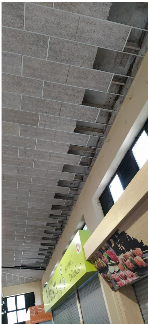
Il·lustració 9. - plaques de fals sostre retirades
