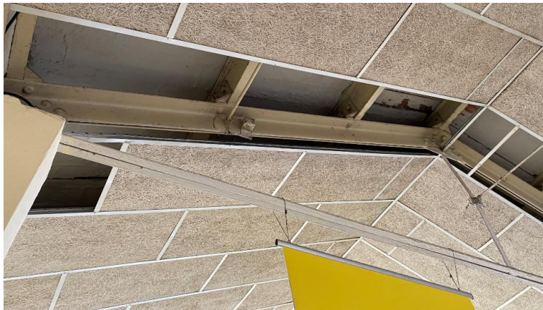
Il·lustració 8.- Vista de l'encavallada central
