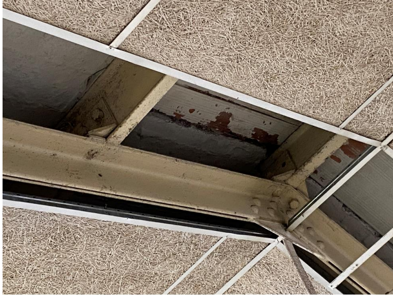
Il·lustració 7.- Cordó superior de l'encavallada
