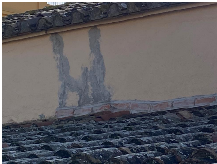
Il·lustració 28.- reparació d'esquerdes a la paret de la coberta central
