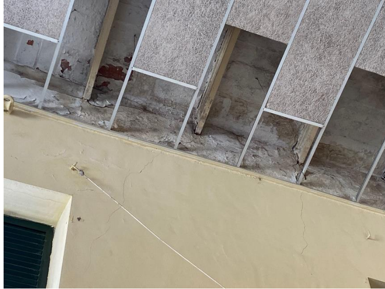
Il·lustració 13.- vista de diferents recolzaments de biguetes
