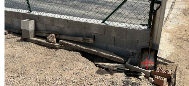
Fotografia del punt d'origen de replanteig a cota +44.00m s.n.m. = 0.00 NOTA: Informació sobre fonamentació de tanques, portals i escala en els plans corresponents
