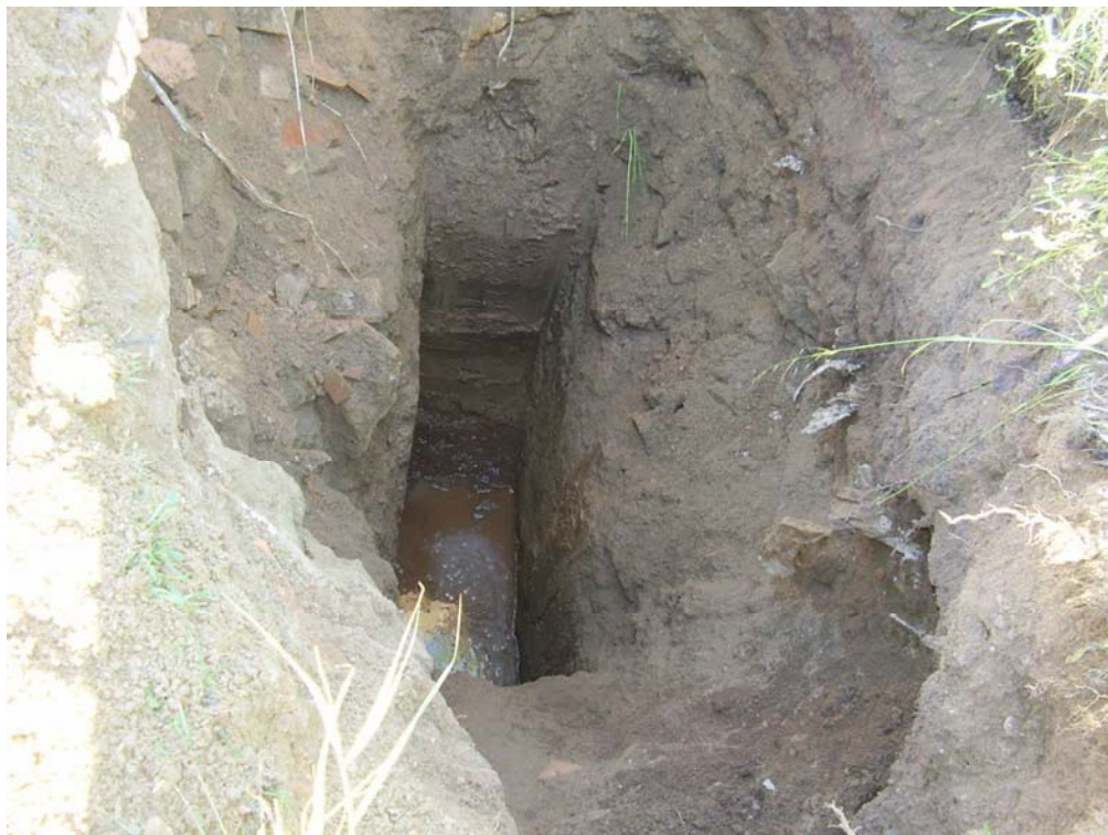
Detalle Calicata C-1
