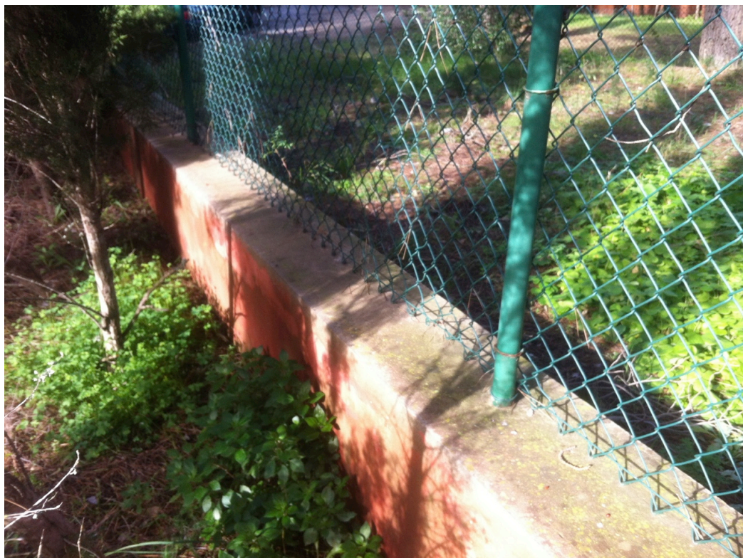
MURET I FILAT EXISTENT DE SEPARACIÓ AMB LA PARCEL LA
