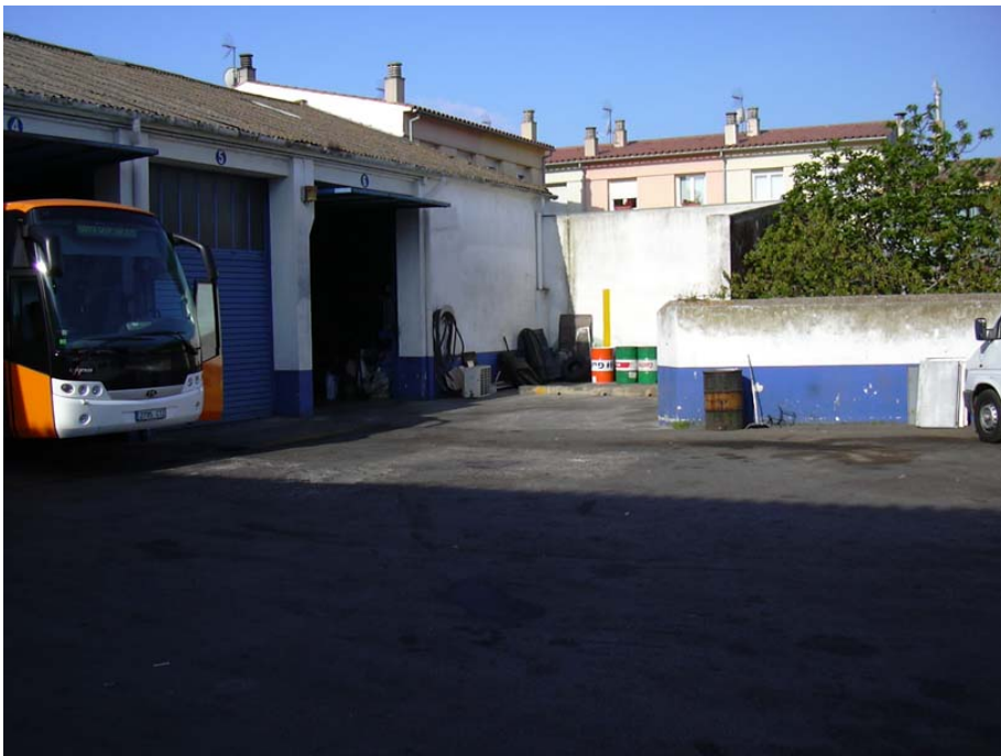
Pati interior. Imatge des de l'interior mirant l'edificació del carrer Nou.
