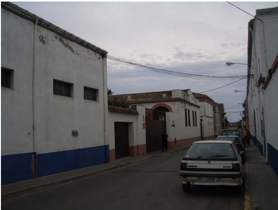
Carrer Girona: Accés principal autobusos.
