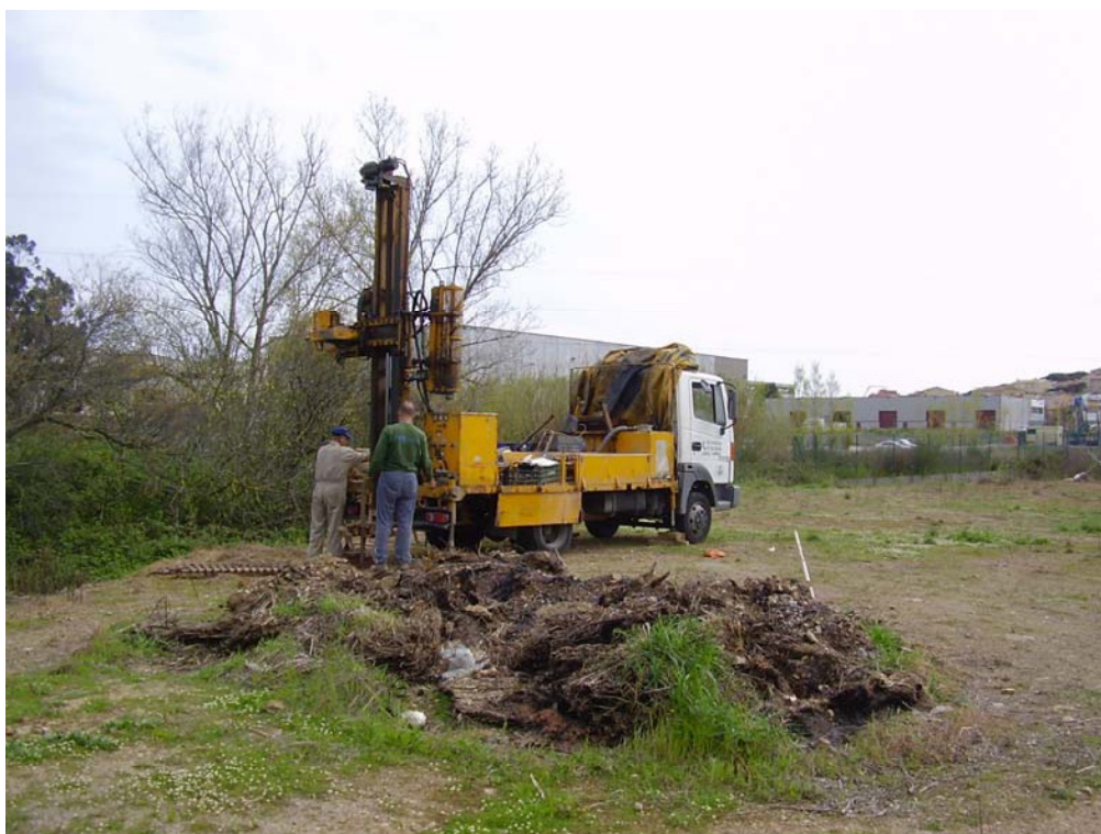
Sondeo S.2. Emplazamiento.
