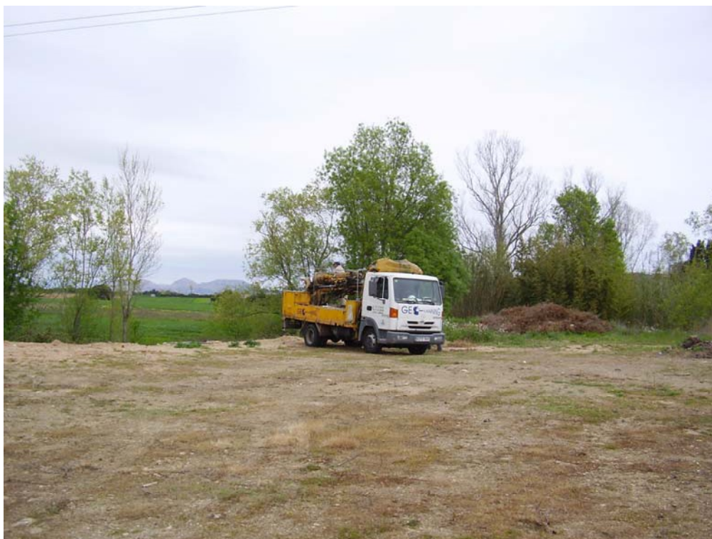
Sondeo S.1. Emplazamiento.
