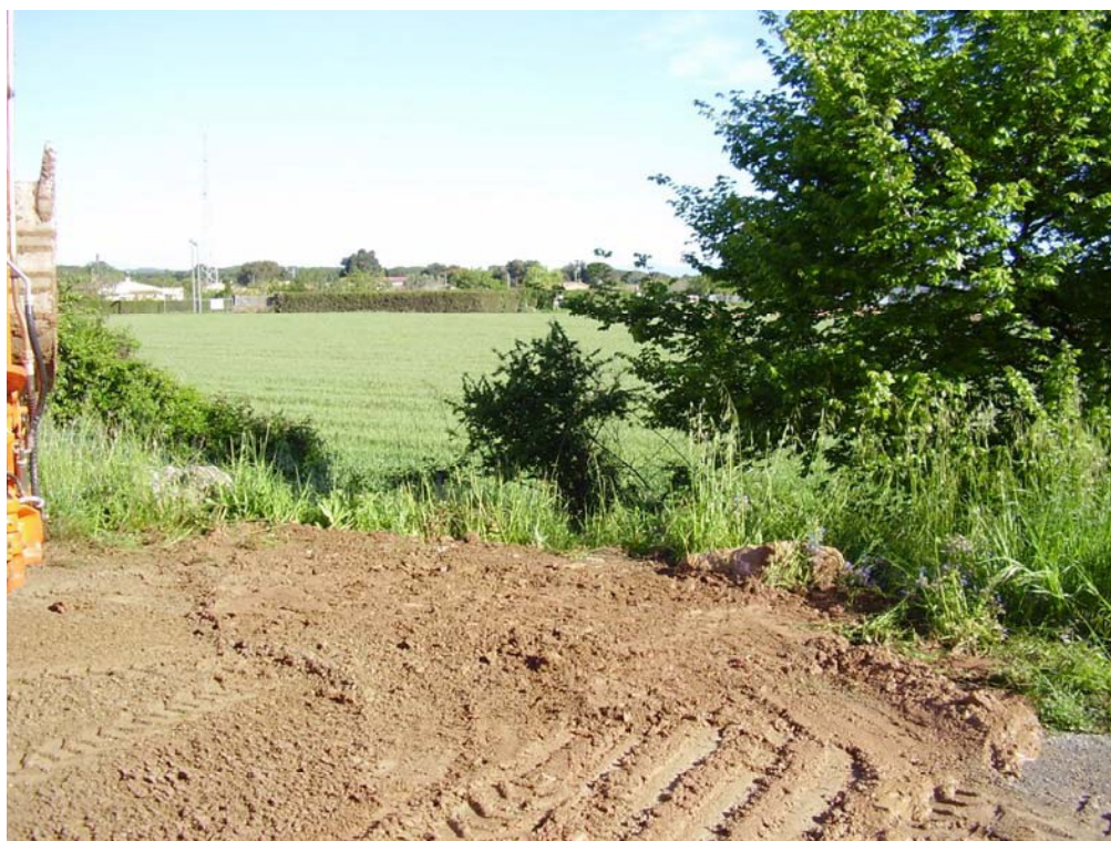
Vista general de la zona de realización de la calicata.
